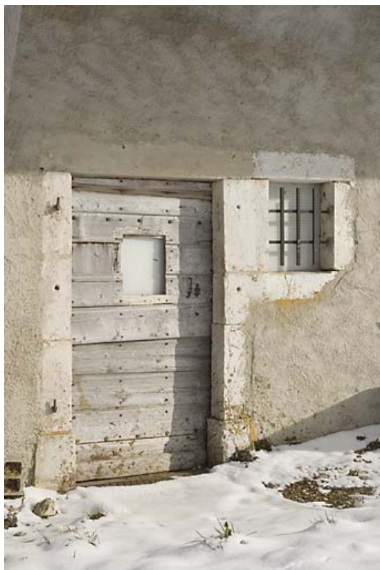
Façade antérieure : porte d'étable.
