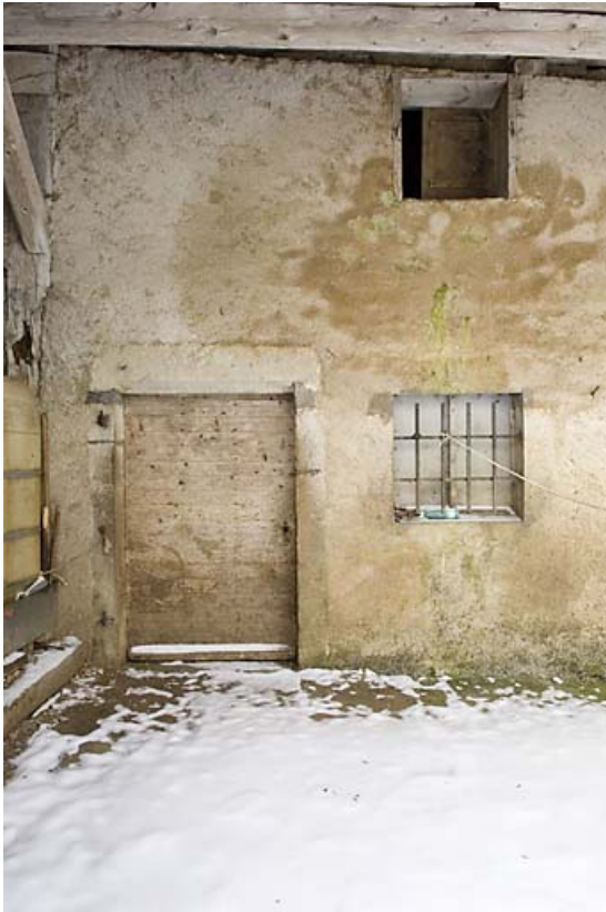
Façade postérieure : porte.
