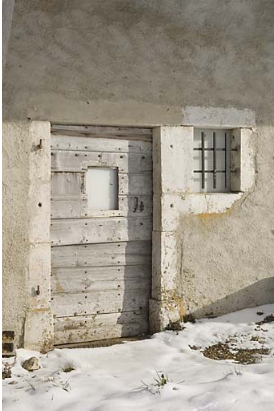
Façade antérieure : porte d'étable.
