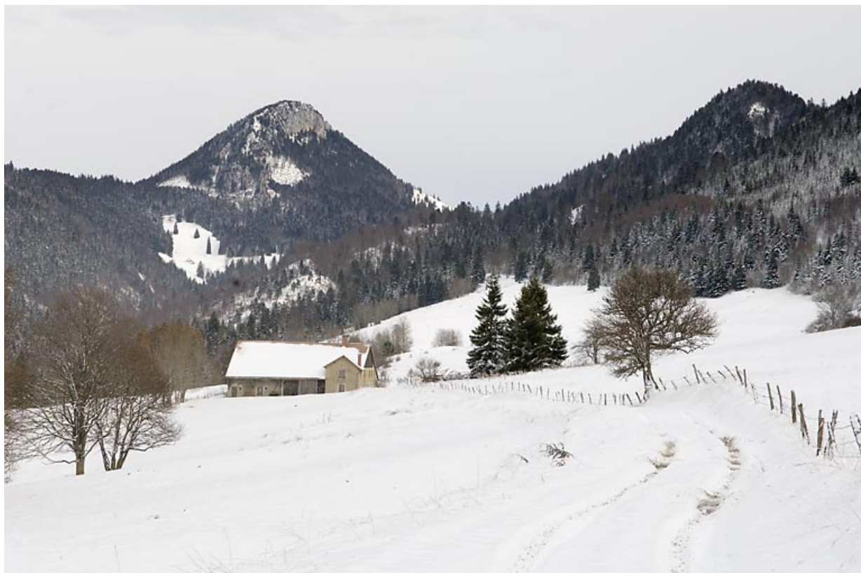
Vue d'ensemble depuis le sud-ouest, en hiver.
