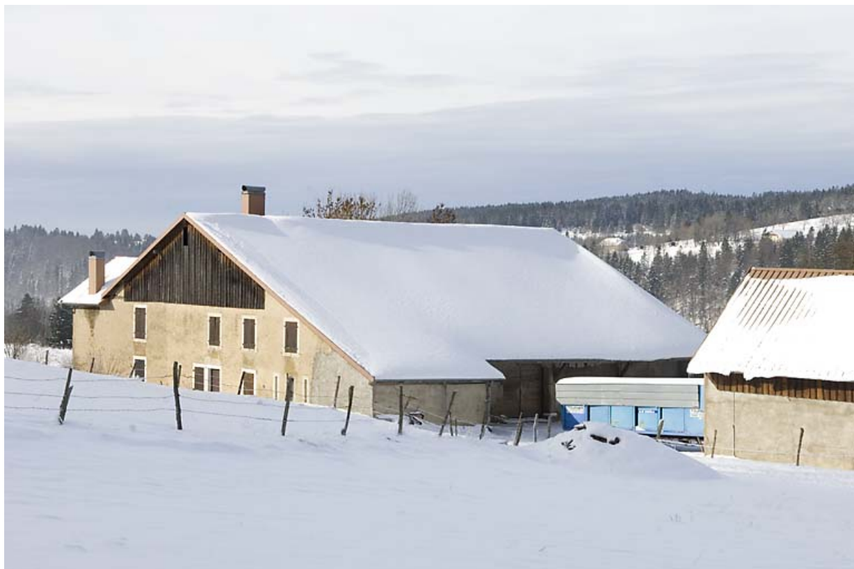
Façades postérieure et latérale droite, en hiver.
