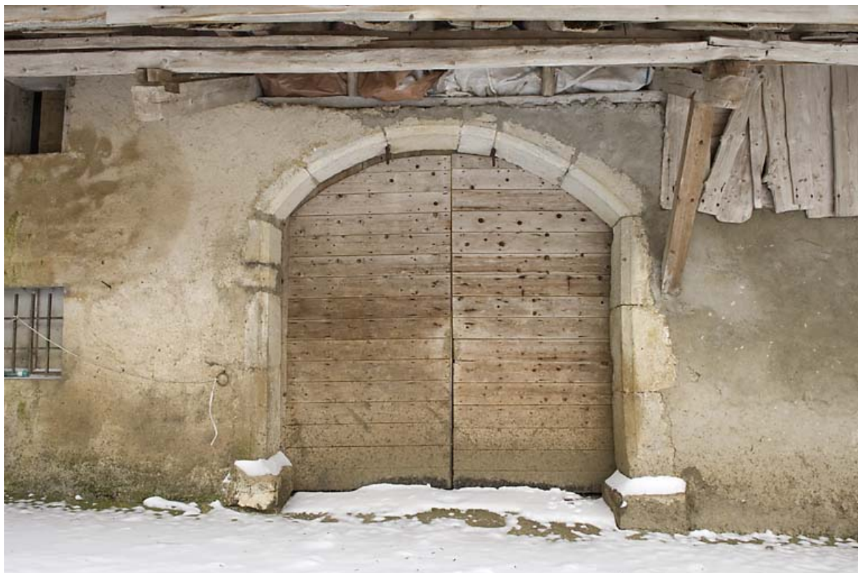
Façade postérieure : porte de grange.
