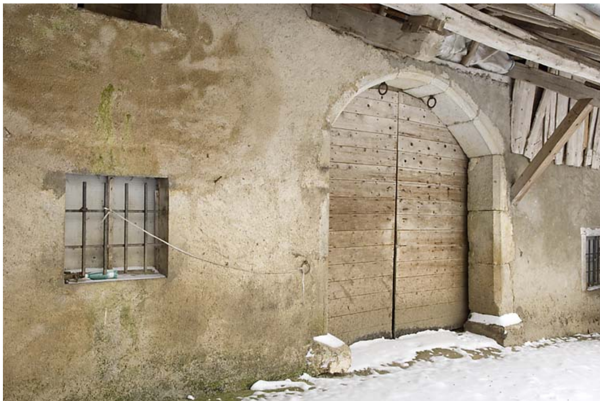
Façade postérieure : porte de grange, de trois quarts gauche. 25, Jougne, lieudit : Palzard
