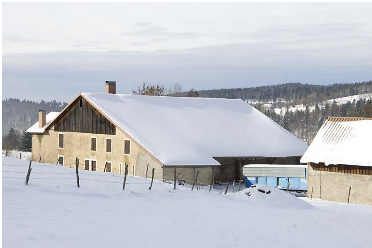
Façades postérieure et latérale droite, en hiver.
