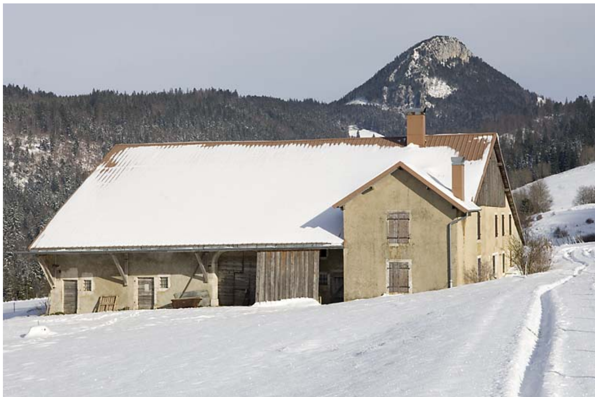
Façades antérieure et latérale droite, en hiver.
