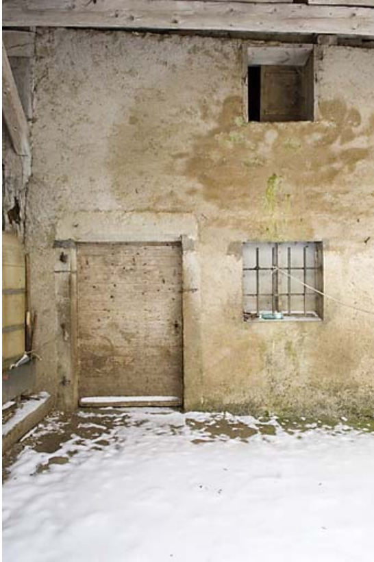
Façade postérieure : porte.
