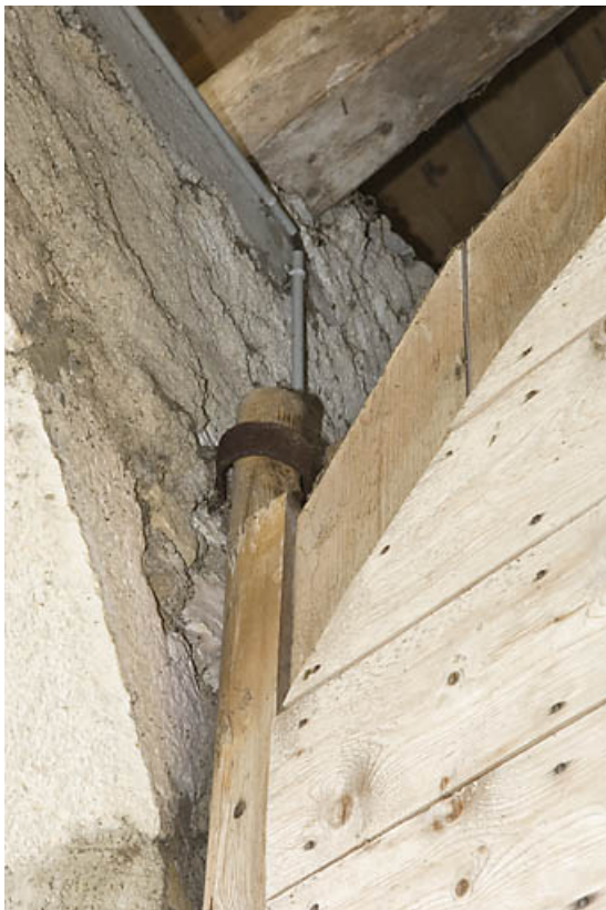
Façade postérieure, porte de grange : gond supérieur du vantail de gauche. 25, Jougne, lieudit : Palzard
