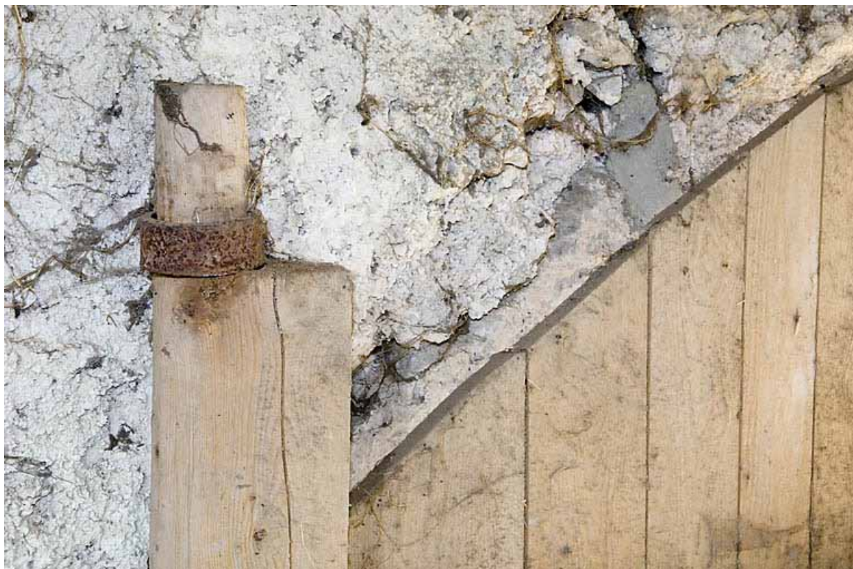
Façade postérieure, porte de grange : gond supérieur du vantail de droite. 25, Jougne, lieudit : Palzard
