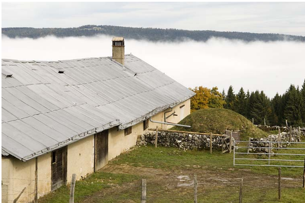
Façade antérieure vue en enfilade et citerne.
