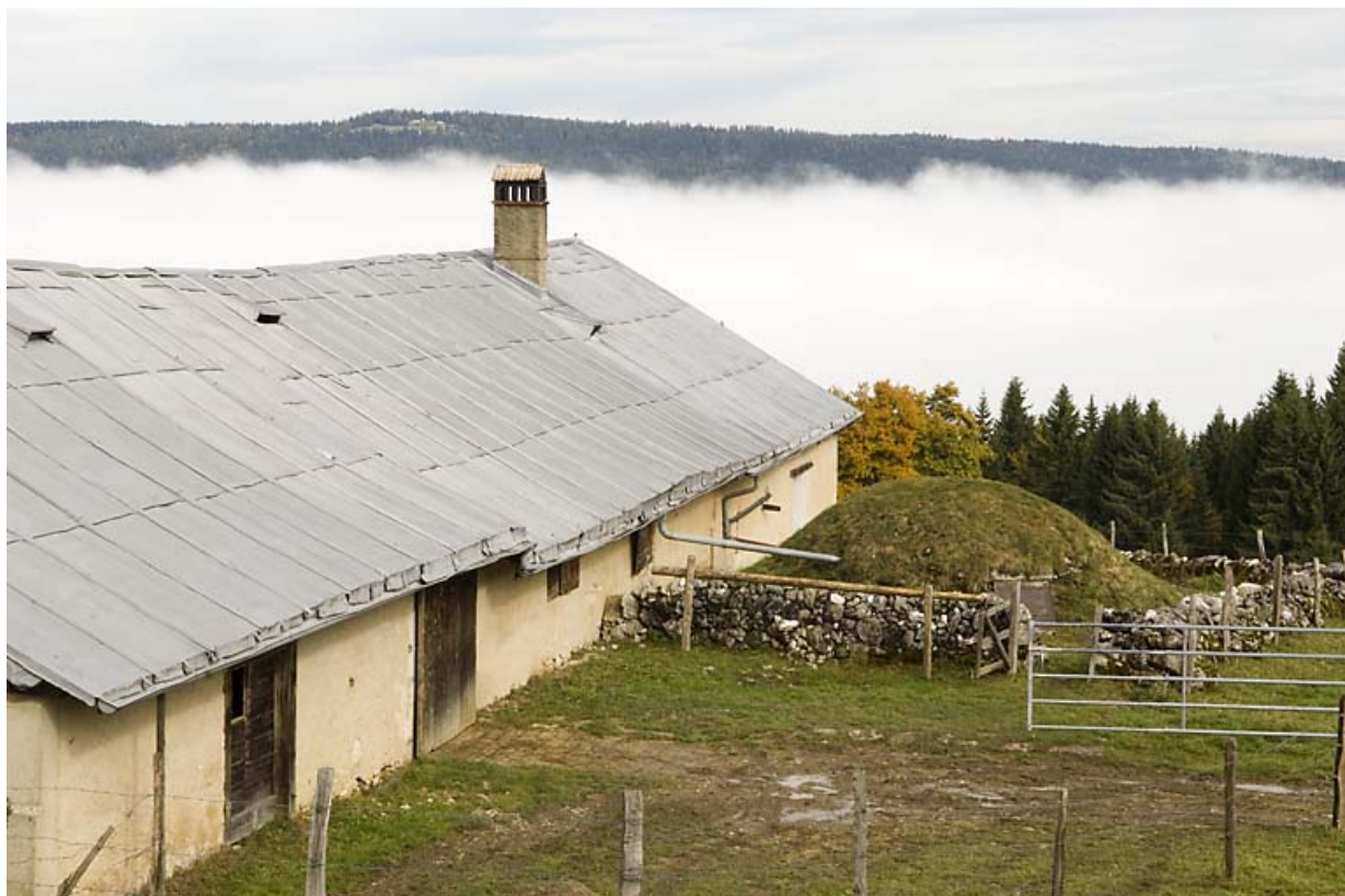
Façade antérieure vue en enfilade et citerne.
