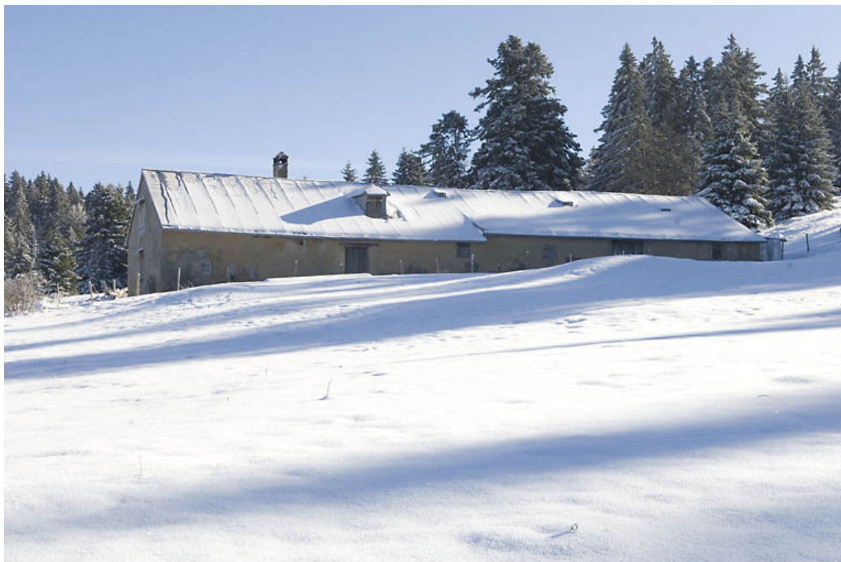
Façade postérieure, en hiver. 25, Jougne, lieudit : Tous Vents
