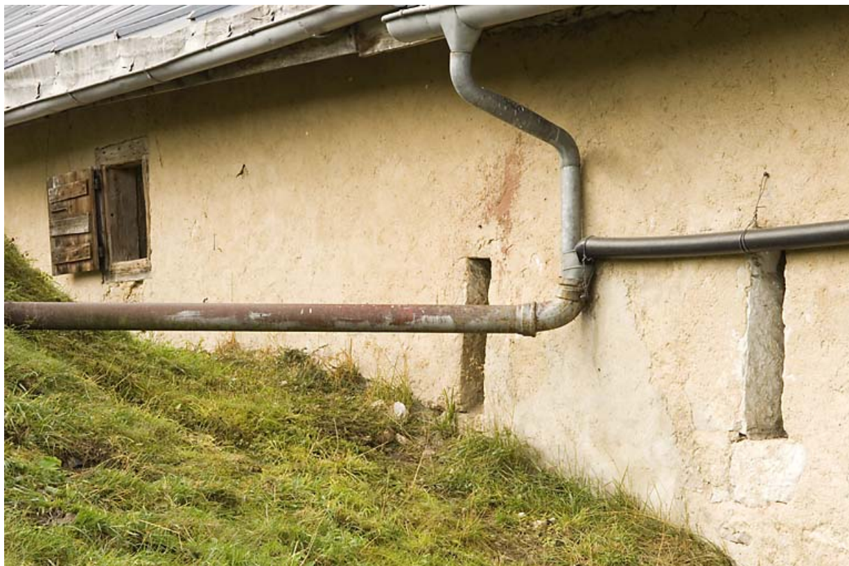
Façade antérieure : extrémité avec les baies fromagères.
