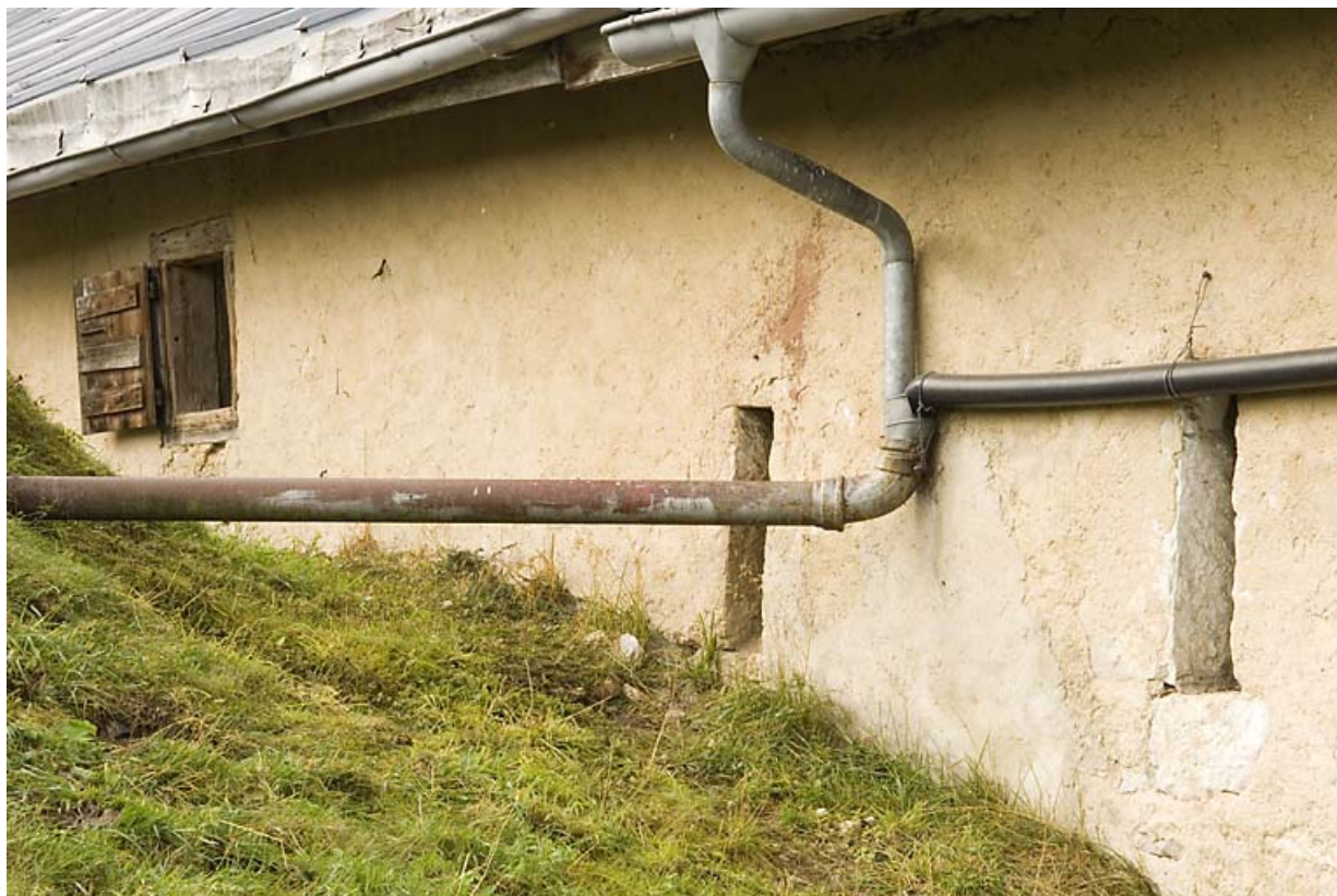
Façade antérieure : extrémité avec les baies fromagères.
