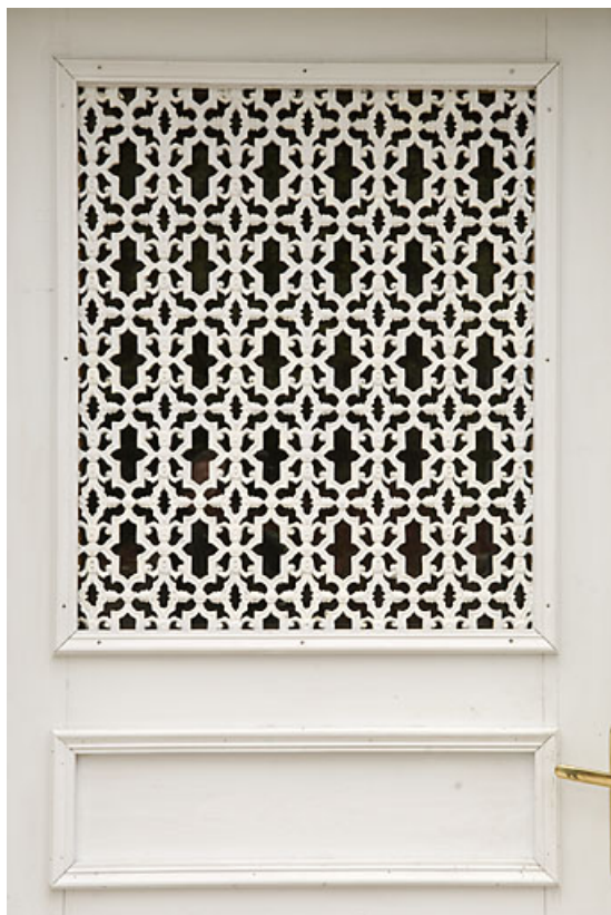
Bâtiment 62-64 rue des Forges : ferronnerie d'une porte (62 rue des Forges). 25, Jougue
