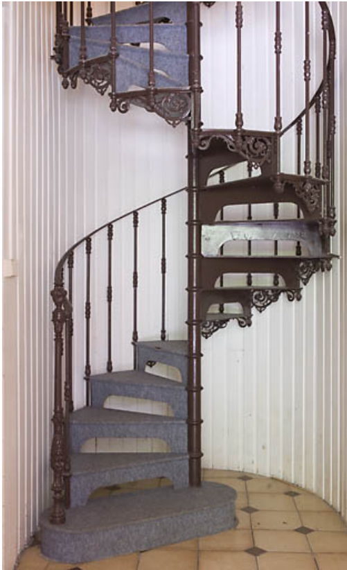
"Grand Château" : escalier métallique en vis. 25, Jougne
