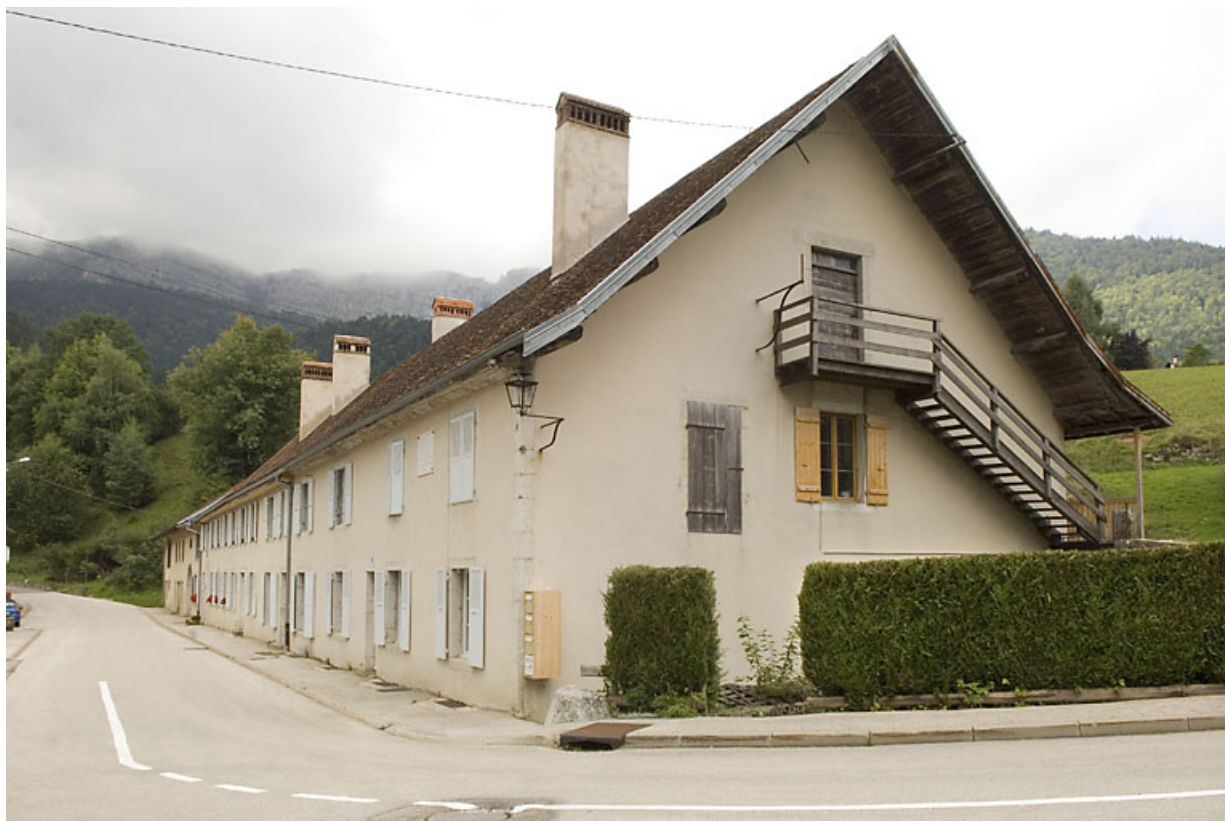
Ancien bâtiment des forges puis logement patronal (62-64 rue des Forges, 2020 Ai 94, 232). 25, Jougne
