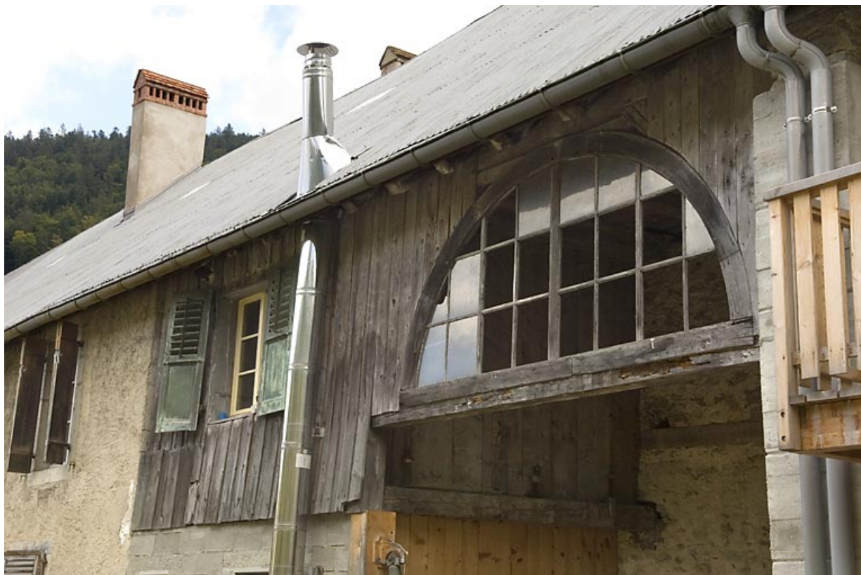
Bâtiment 62-64 rue des Forges : portail sur la façade postérieure. 25, Jougne
