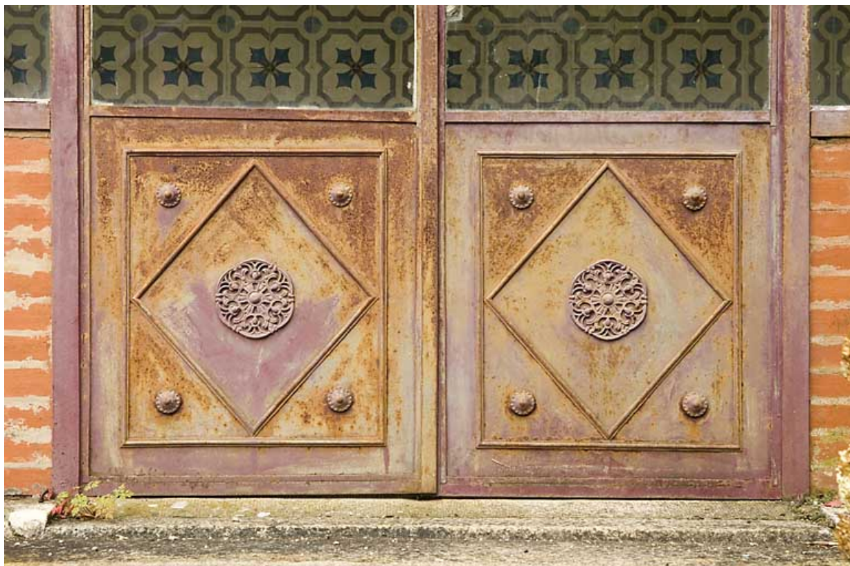
Serre : ferronnerie de la porte.
