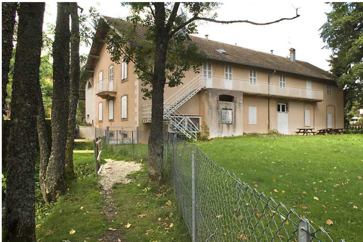
Bâtiment 25 rue des Forges : façade postérieure, de trois quarts gauche. 25, Jougne
