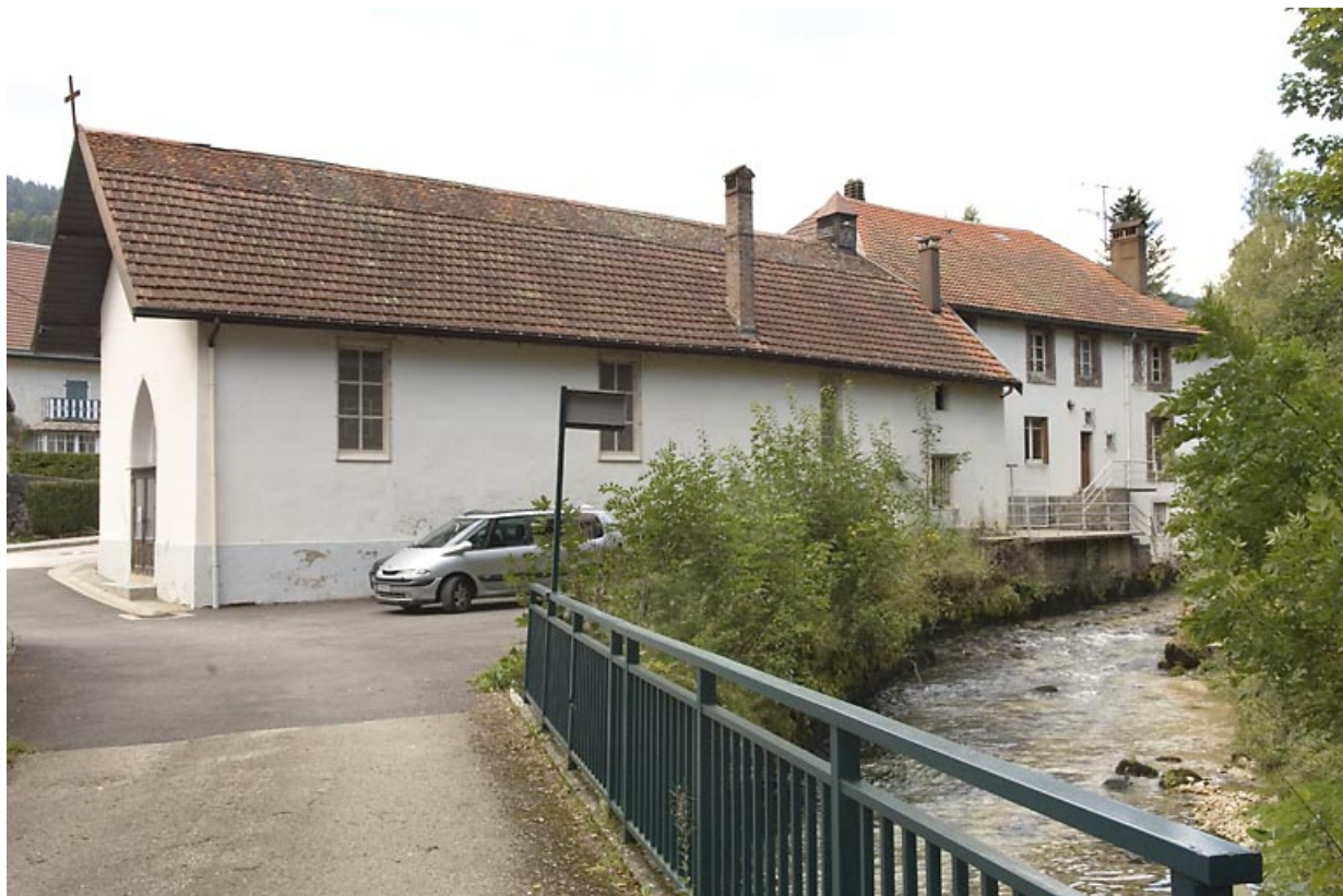
Chapelle rue des Forges : façade latérale droite. 25, Jougne
