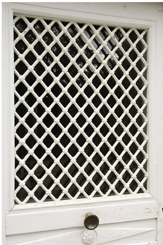
Bâtiment 62-64 rue des Forges : détail de la ferronnerie de la porte (64 rue des Forges). 25, Jougue
