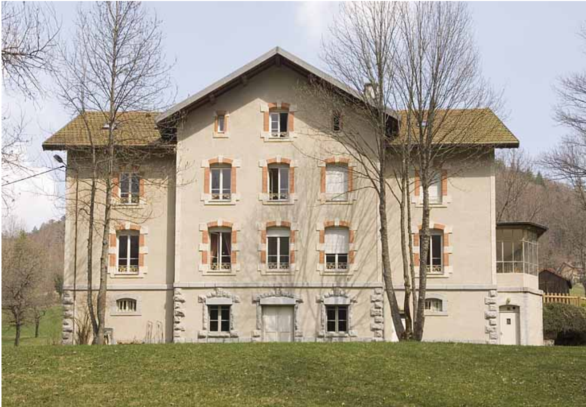
Logement patronal dit le "Grand Château" (2020 AI 47) : façade postérieure. 25, Jougne
