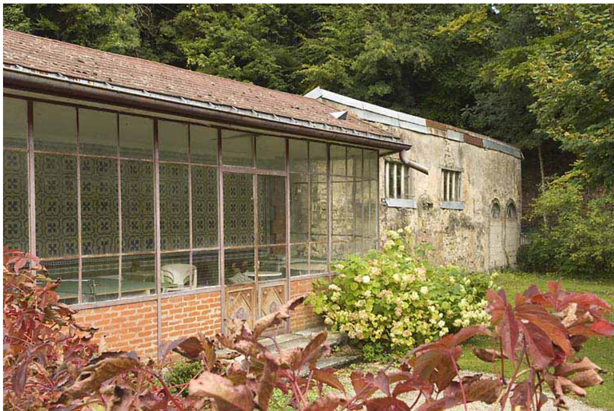
Serre et garage, vus de trois quarts. 25, Jougne
