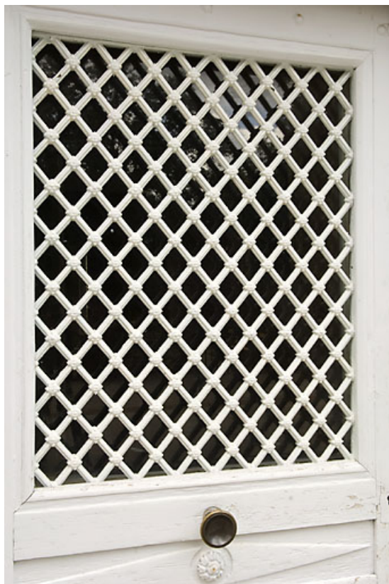
Bâtiment 62-64 rue des Forges : détail de la ferronnerie de la porte (64 rue des Forges). 25, Jougue
