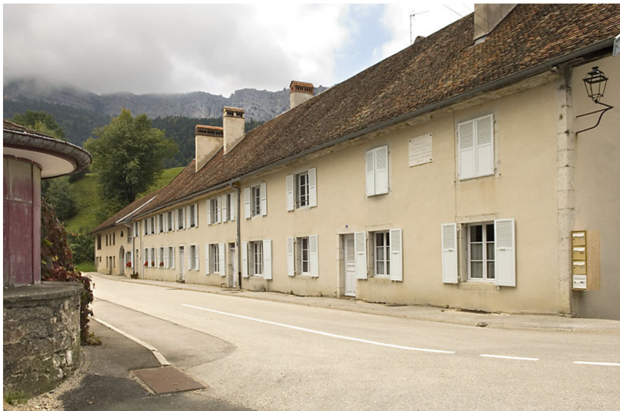
Bâtiment 62-64 rue des Forges, vu de trois quarts droite. 25, Jougne
