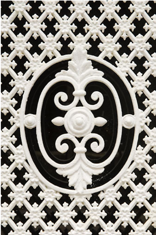
Bâtiment 62-64 rue des Forges : détail de la ferronnerie d'une porte (64 ter rue des Forges). 25, Jougue
