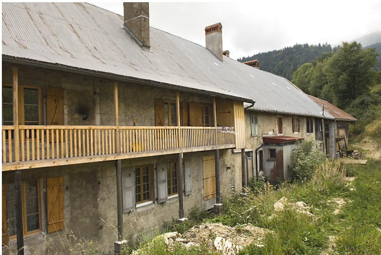
Bâtiment 62-64 rue des Forges : façade postérieure, de trois quarts gauche. 25, Jougne
