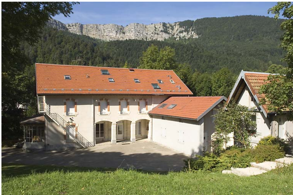
Logement patronal dit le "Grand Château" (2020 AI 47) : façade antérieure. 25, Jougne
