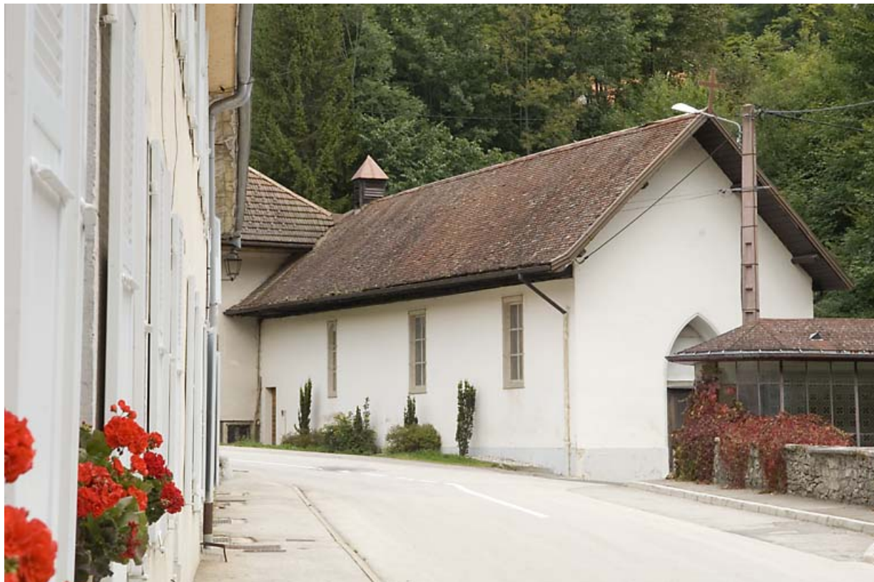
Chapelle rue des Forges (2020 AI 355) : façades antérieure et latérale gauche. 25, Jougne
