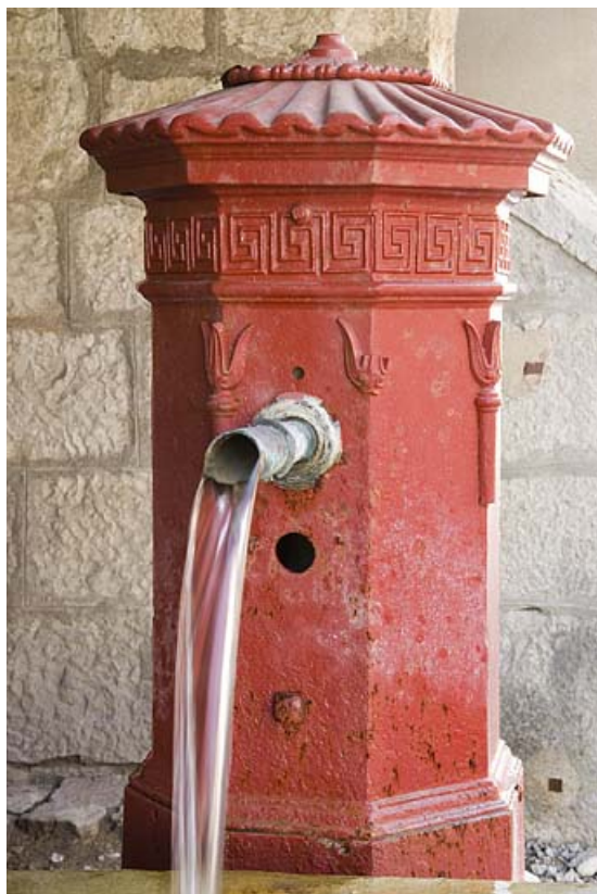
Fontaine-lavoir-abreuvoir du Chalet : la borne fontaine. 25, Jougne
