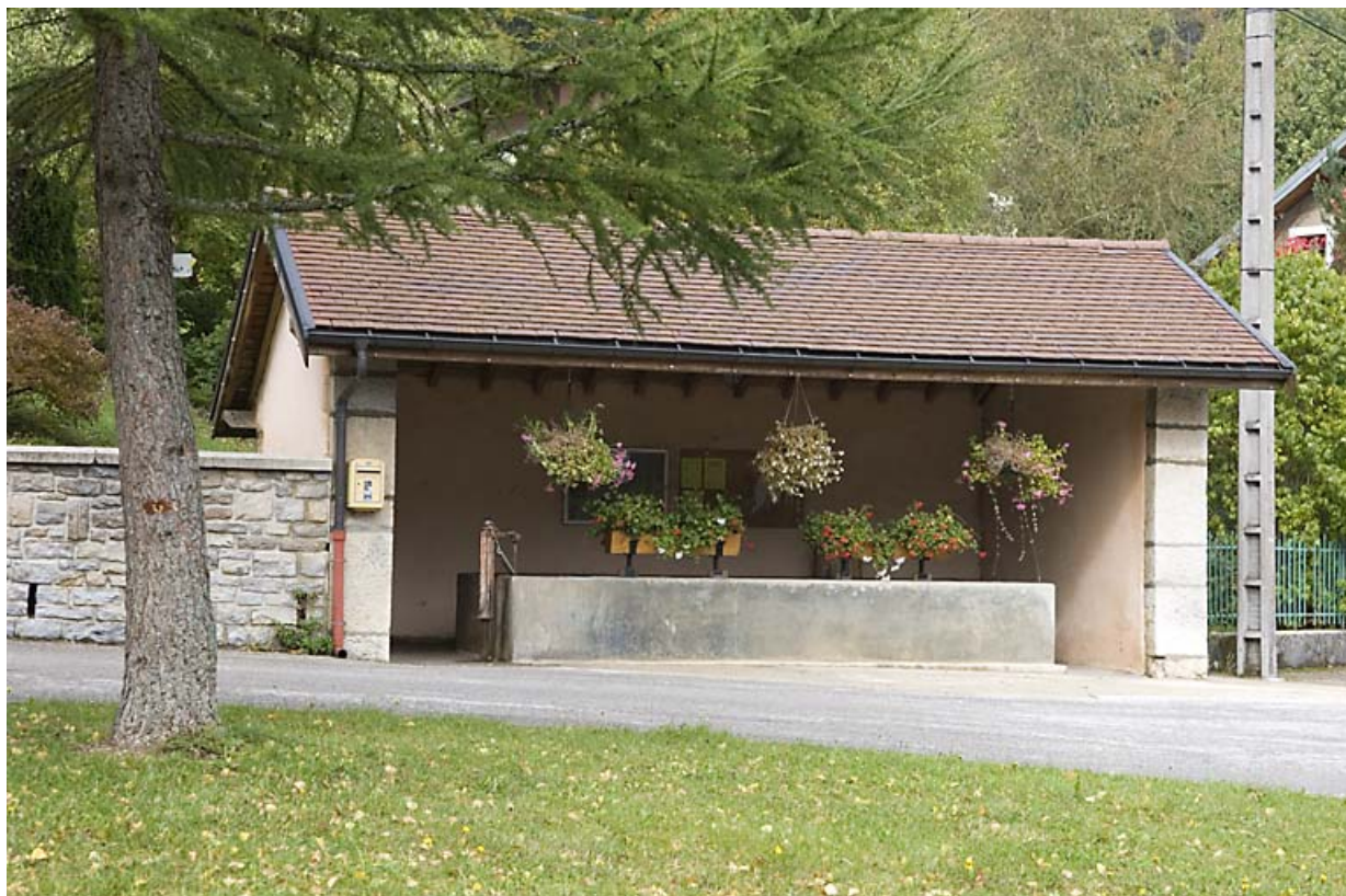
Fontaine-lavoir-abreuvoir du Moulin.
