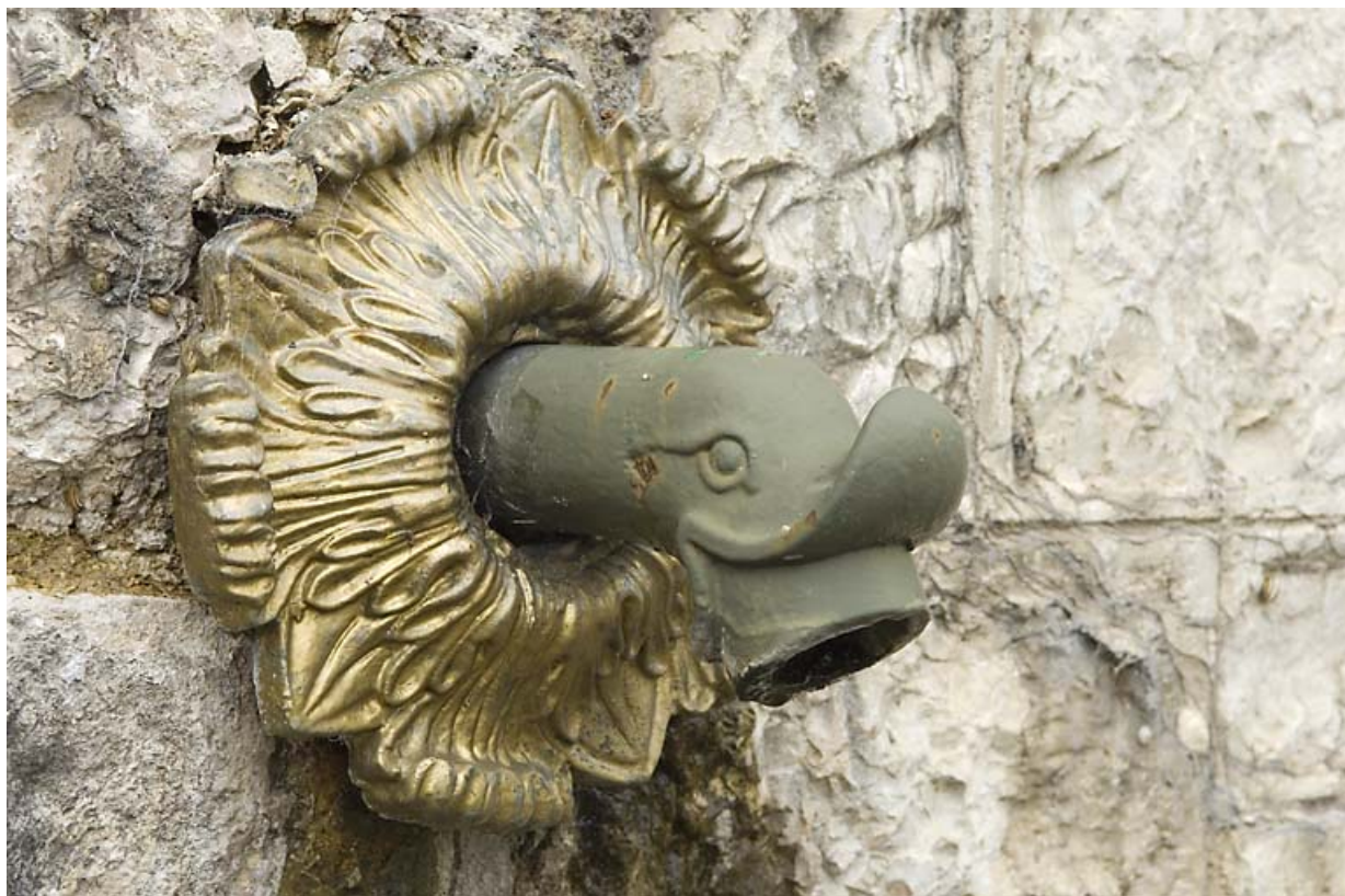
Réservoir des Tavins : sortie en forme de tête de canard. 25, Jougne
