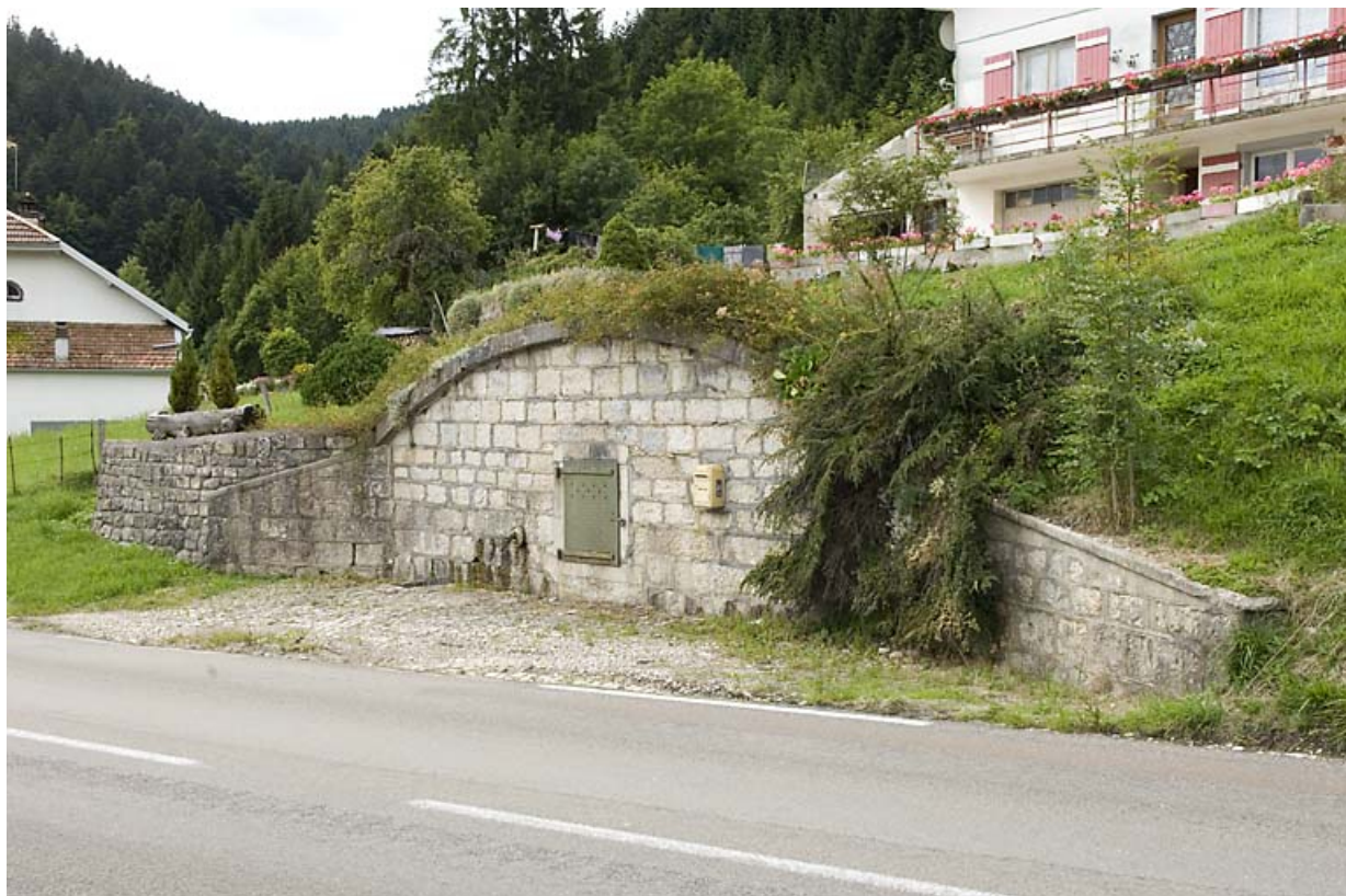
Réservoir des Tavins (route de Vallorbe, 2008 AH 16). 25, Jougne
