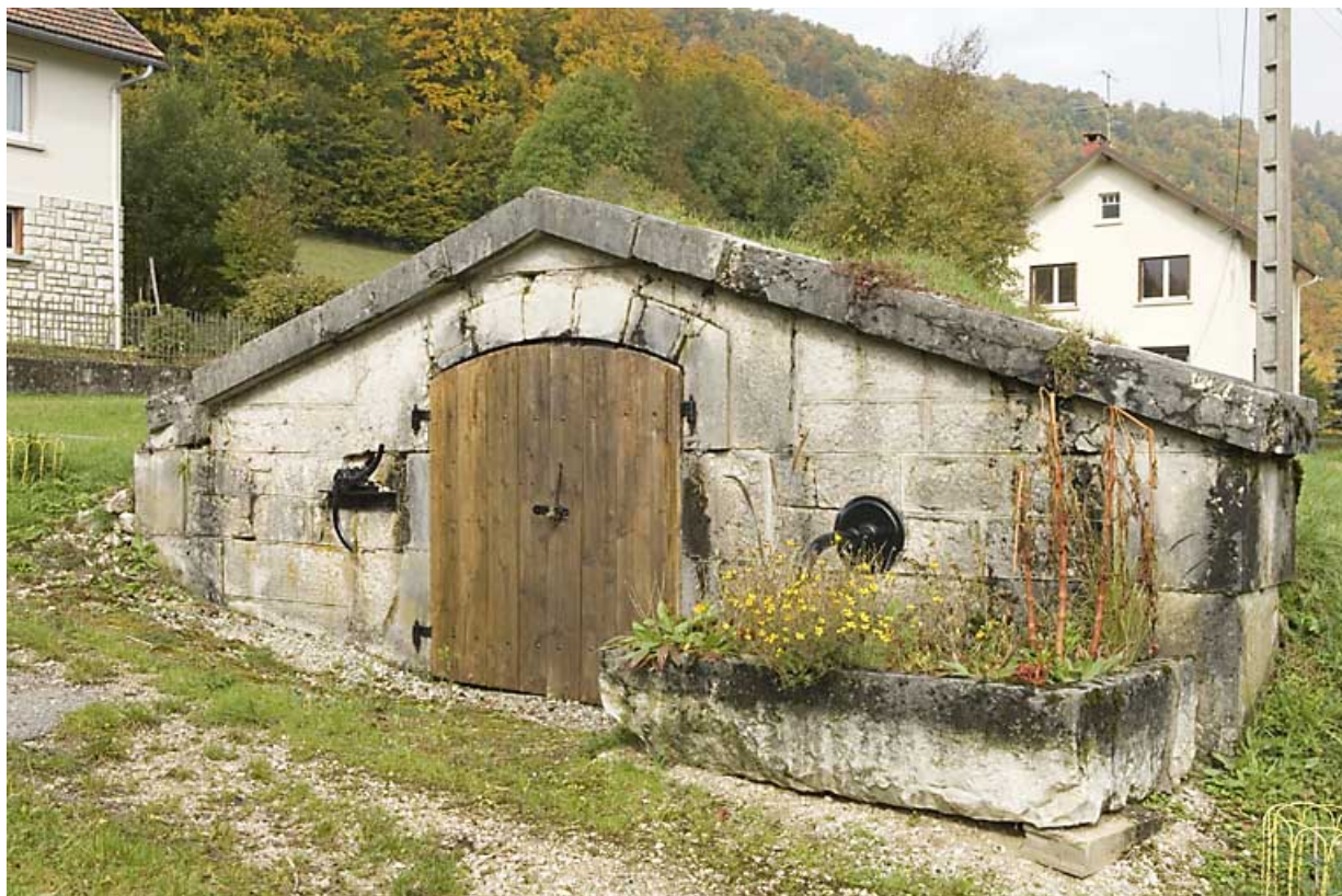
Réservoir des Maillots, de trois quarts droite (rue du Bois, 2008 AE 109). 25, Jougne
