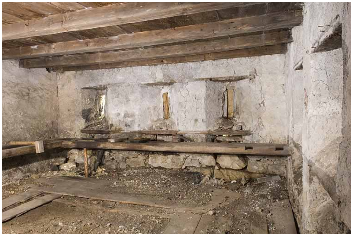
Ferme du Pré Malvilain (2008 A 5) : baies fromagères, vues de l'intérieur. 25, Jougne
