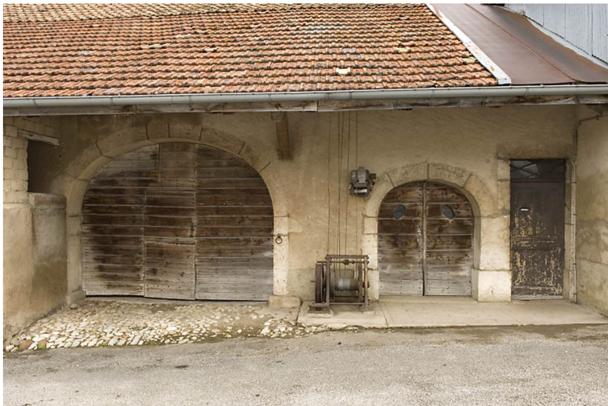
Ferme au 1 place des Cloutiers (Entre-les-Fourgs) : entrées protégées par un avant-toit, abritant aussi la déchargeuse à fourrage. 25, Jougne
