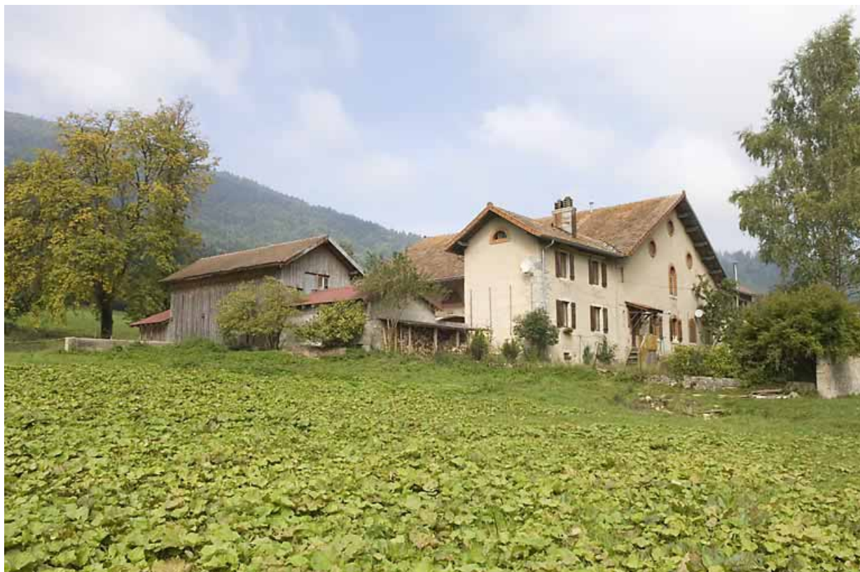
Ferme de la Grange Dessous (la Ferrière). 25, Jougne
