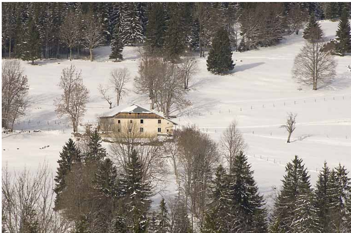
Ferme du Laquerez (2020 A 167), en hiver : façade sud. 25, Jougne
