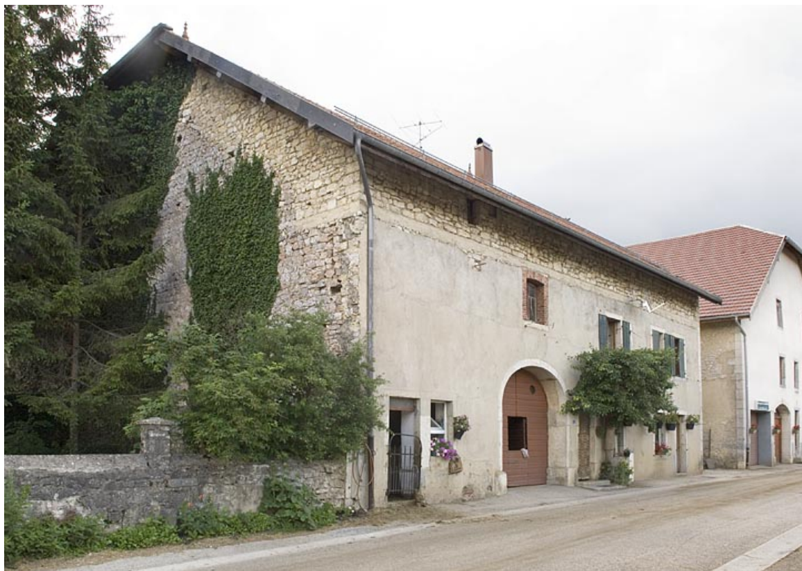
Ferme au 4 rue du Faubourg (2008 AB 47). 25, Jougne
