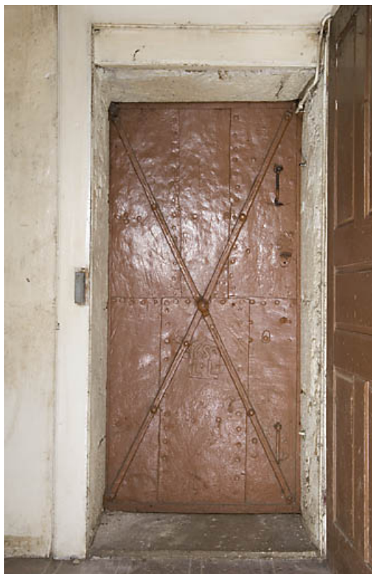
Ferme au 17 rue du Faubourg : porte coupe-feu métallique. 25, Jougne
