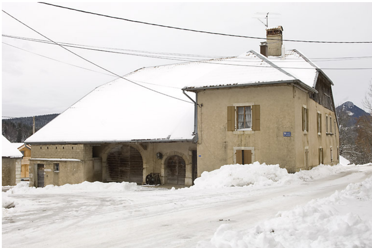
Ferme au 1 place des Cloutiers (Entre-les-Fourgs). 25, Jougne
