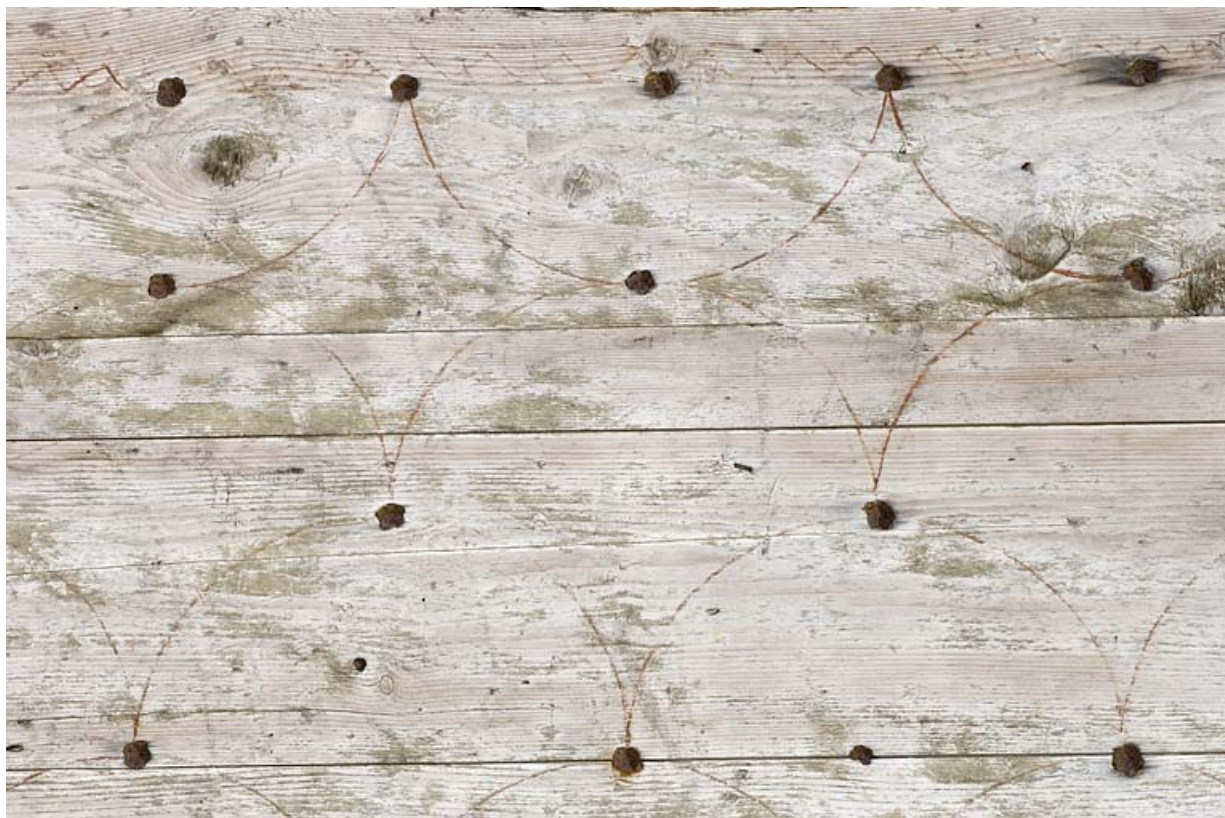
Ferme d'Entre-les-Fourgs (rue de Jougne, 2020 AD 173 ?) : détail d'une porte de grange montrant les tracés au compas utilisés pour positionner les clous de manière régulière.
