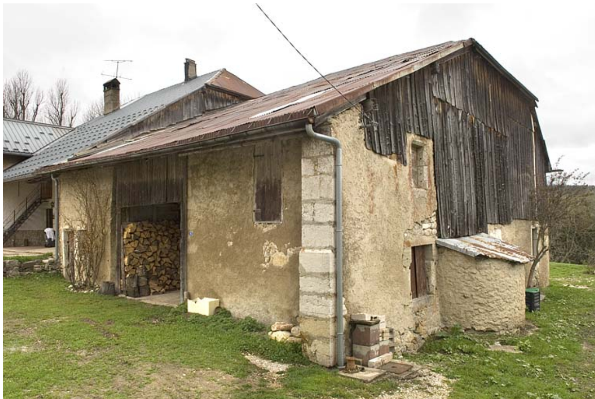
Ferme rue de Jougne (Entre-les-Fourgs, 2020 AD 173), avec avant-toit, mur pare-vent, cache-bois, talvane et four à pain en saillie sur la façade latérale.
