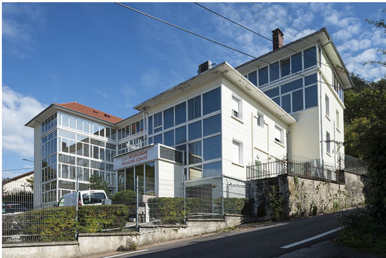
Siège et services centraux de France Ebauches, de 1987 à 1994 (ancienne fabrique de ressorts de montres Billon et Fils puis d'ébauches Zenith), chemins des Ragots à Besançon.
