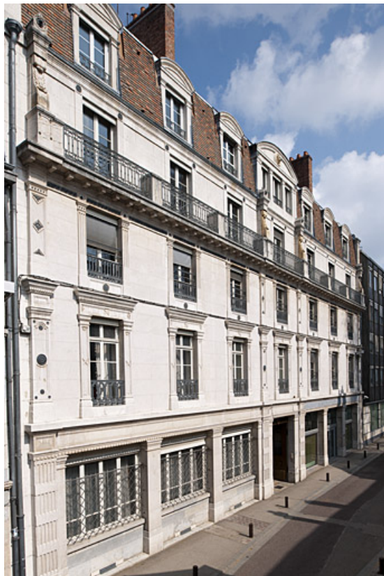
Vue d'ensemble depuis la rue de trois quarts gauche. 25, Besançon
