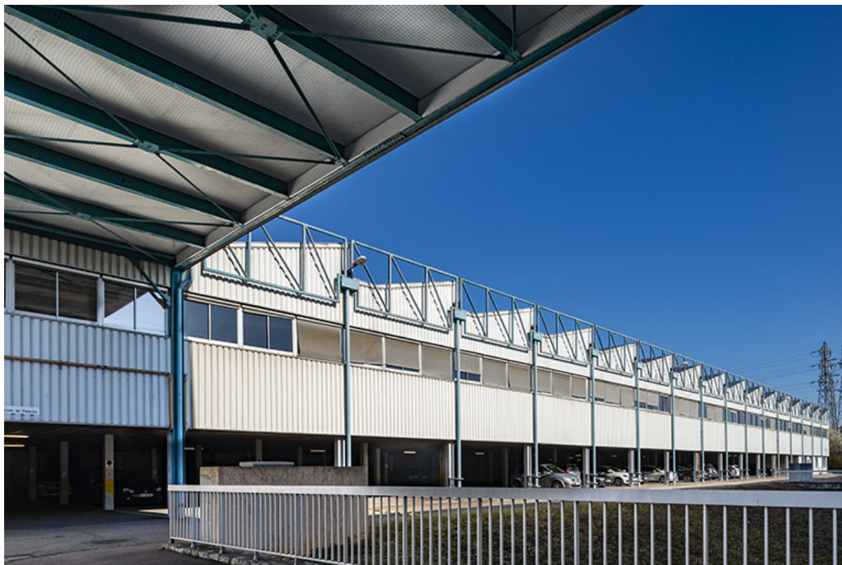
Usine d'horlogerie et de mécanique de précision Lip (3e quart 20e siècle), chemin de Palente. 25, Besançon
