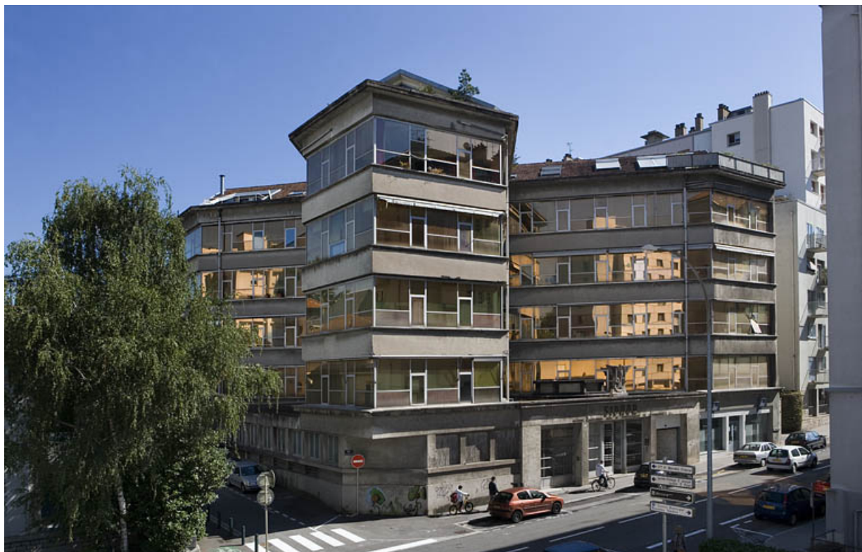
Usine Sidhor (1947-1948), 23 rue de la Mouillère. 25, Besançon
