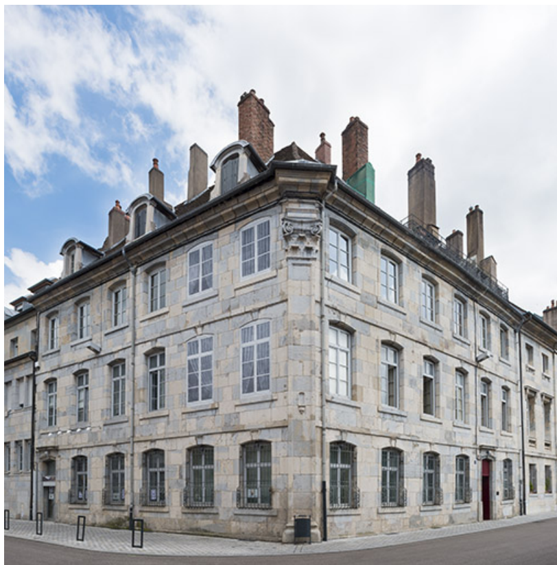
Vue d'ensemble depuis l'ouest. 25, Besançon
