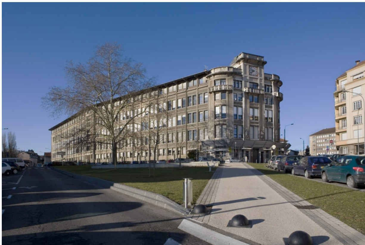
Vue d'ensemble, depuis l'est. 25, Besançon
