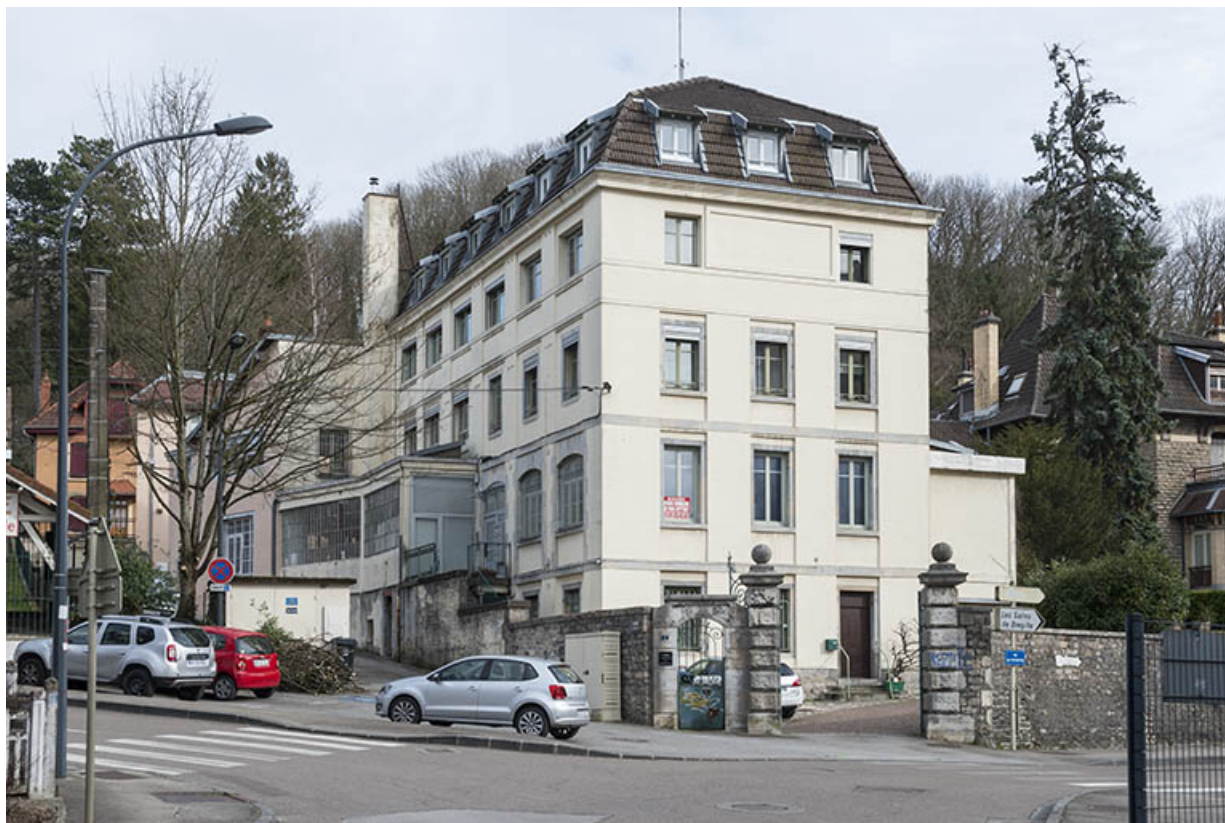
Vue d'ensemble, depuis le nord-ouest. 25, Besançon
