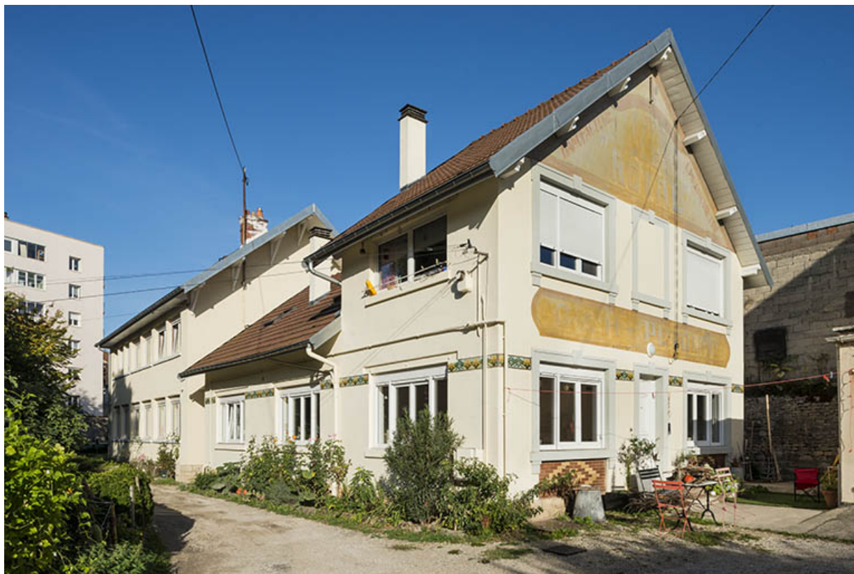
Vue d'ensemble des bâtiments industriels depuis le sud-est. 25, Besançon
