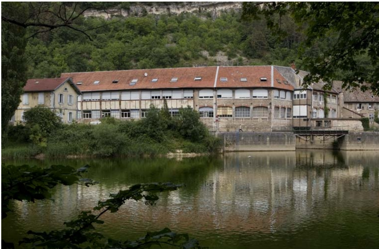
Vue d'ensemble de la façade sur rivière (postérieure) des ateliers de fabrication. 25, Besançon
