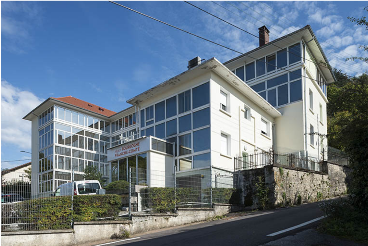
Siège et services centraux de France Ebauches, de 1987 à 1994 (ancienne fabrique de ressorts de montres Billon et Fils puis d'ébauches Zenith), chemins des Ragots à Besançon.
