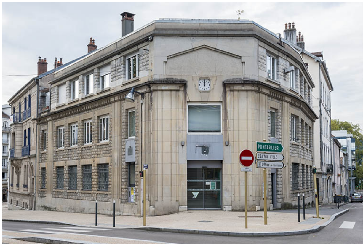
Vue d'ensemble depuis le nord. 25, Besançon
