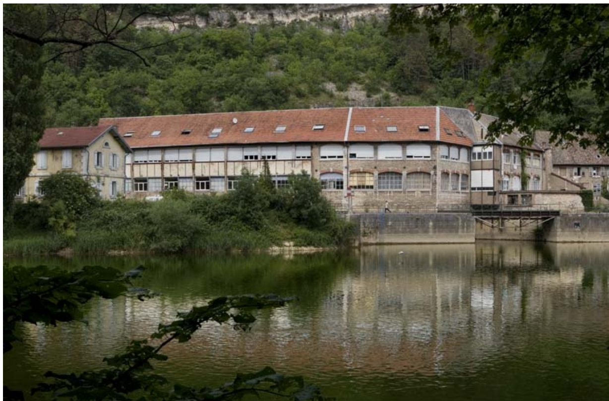
Vue d'ensemble de la façade sur rivière (postérieure) des ateliers de fabrication. 25, Besançon
