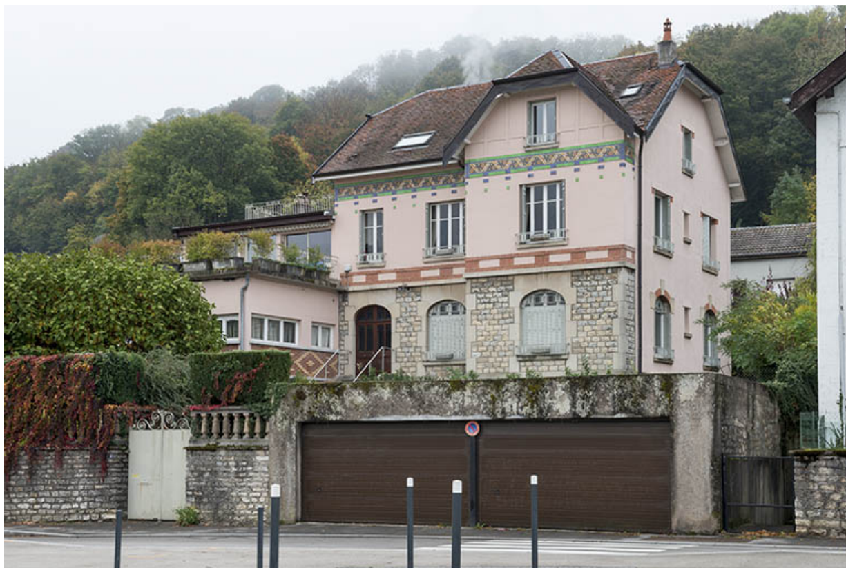
Vue d'ensemble depuis le nord-ouest. 25, Besançon
