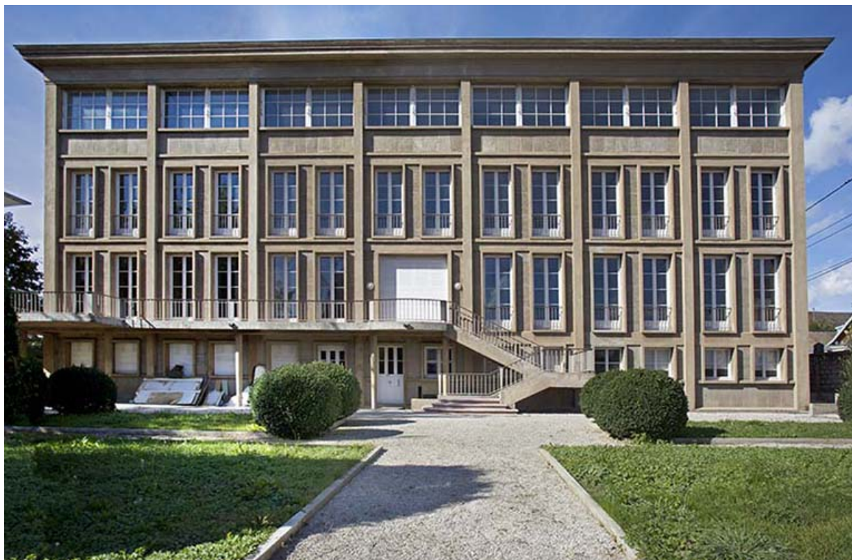
Face latérale gauche (vue rapprochée).
