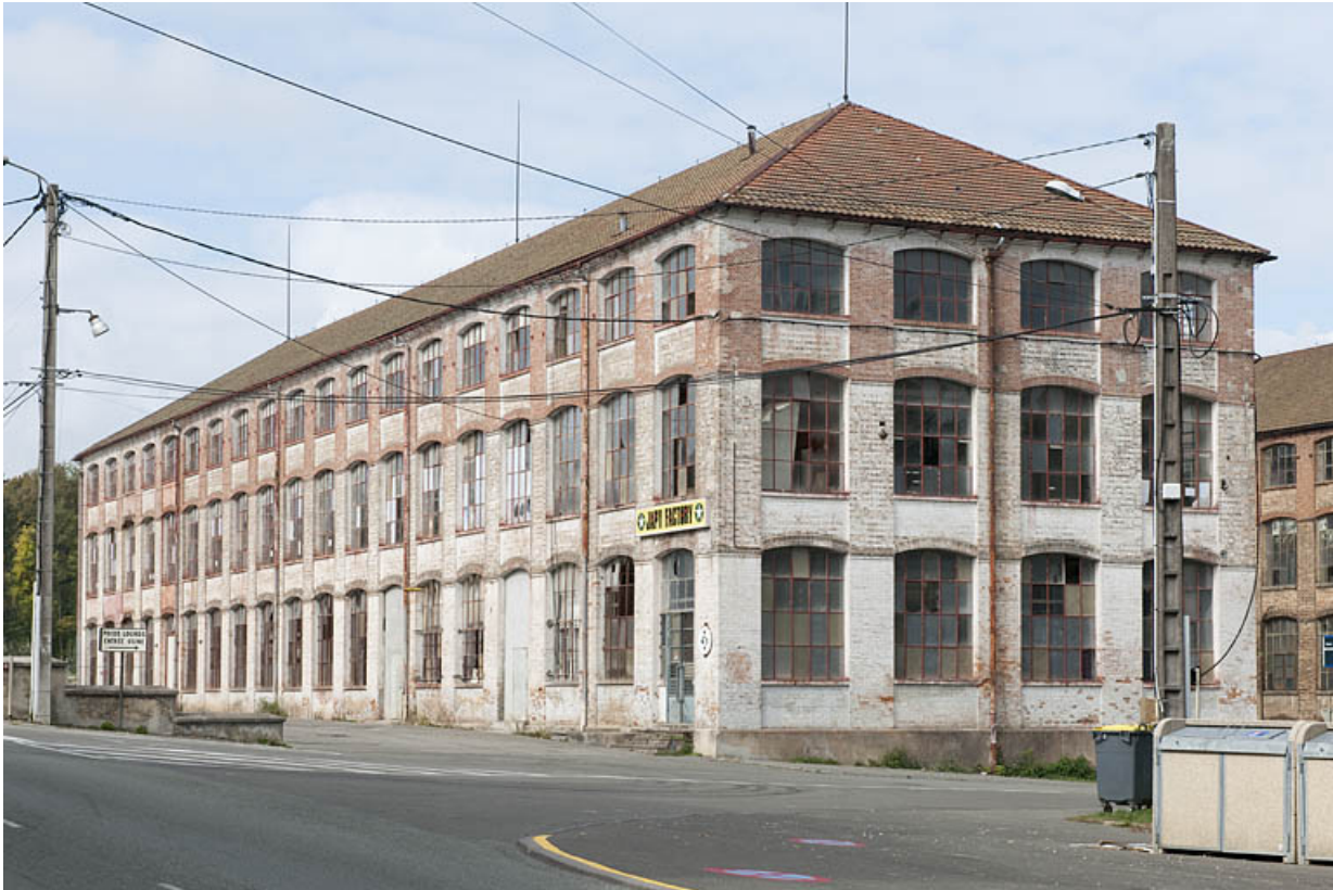
Vue d'ensemble rapprochée depuis le sud-est.
