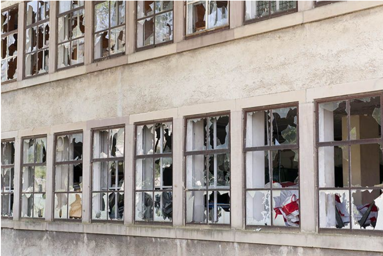
Détail des baies de la façade postérieure.
