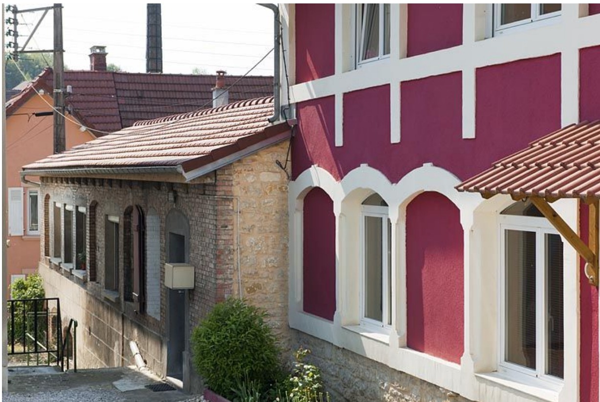
Façade sud des ateliers.
