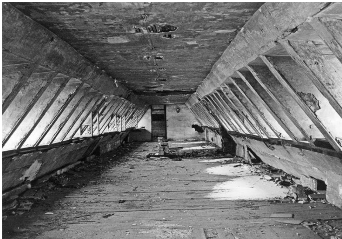
Atelier de fabrication : vue intérieure du deuxième étage de comble.
