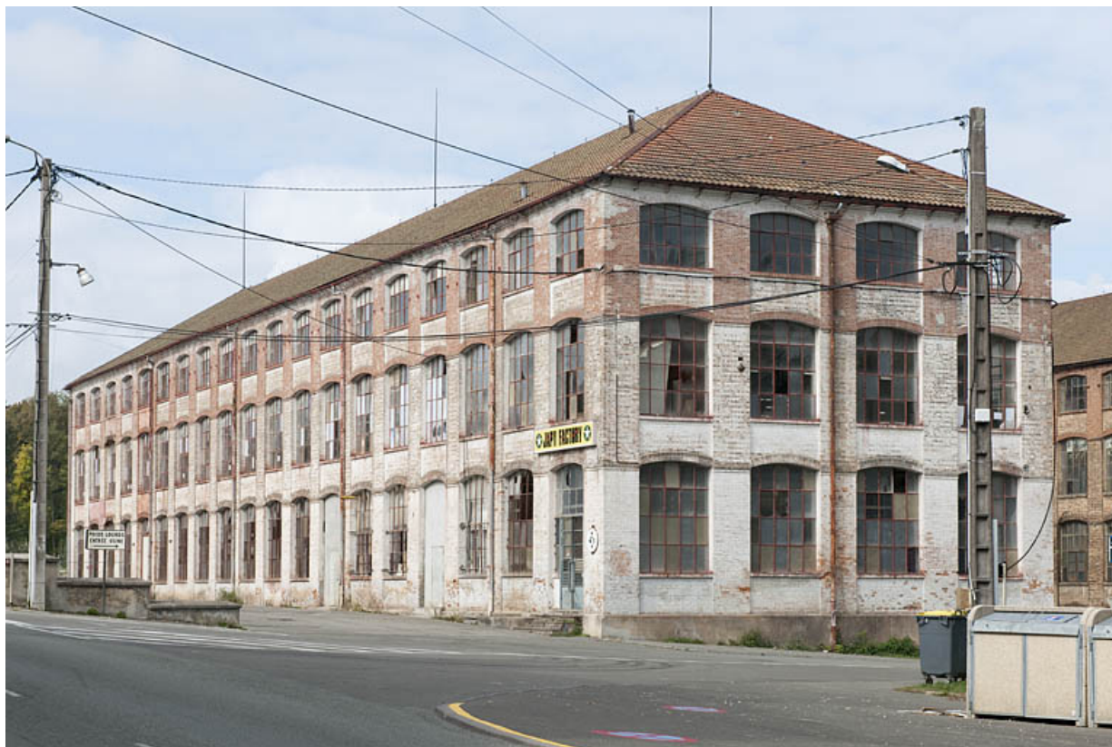
Vue d'ensemble rapprochée depuis le sud-est.
