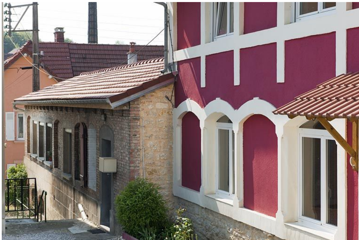
Façade sud des ateliers.
