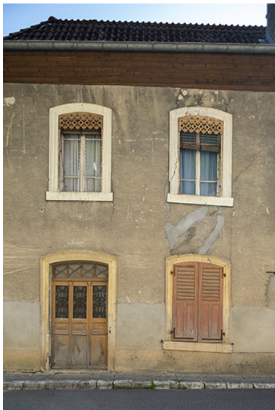
Logement, élévation antérieure : deux travées de gauche. 25, Saint-Hippolyte rue du Dessoubre
