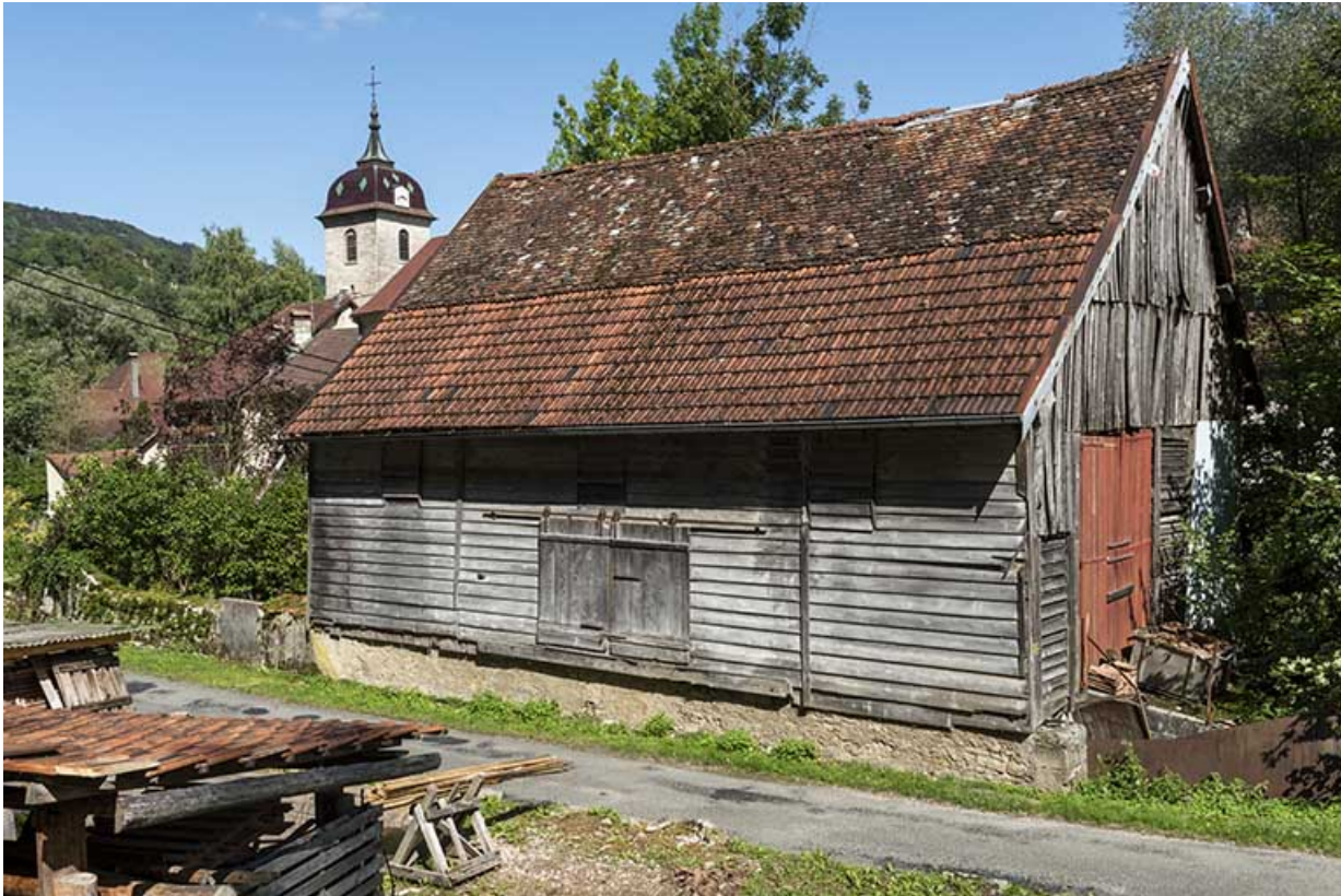
Séchoir et entrepôt industriel rive gauche du Dessoubre.
