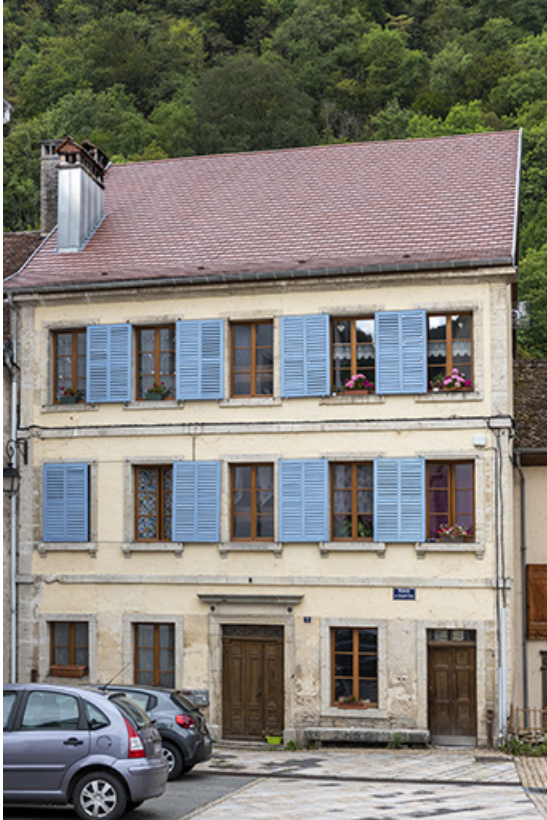
Immeuble 3 place du Chapitre : façade antérieure.
