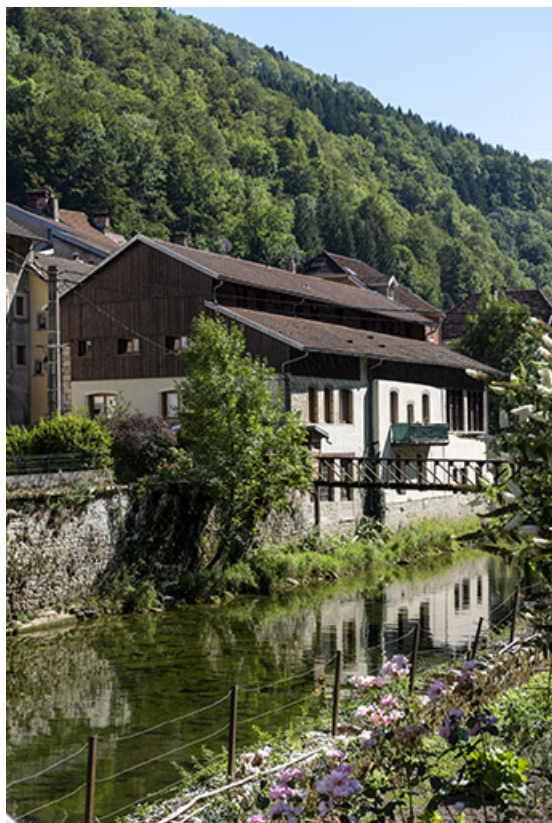
Tannerie : vue d'ensemble, depuis le nord-ouest (façades antérieure et latérale droite). 25, Saint-Hippolyte, 2-4 impasse de la Tannerie
