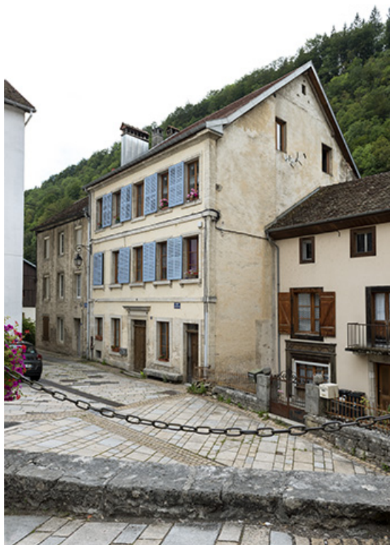
Immeuble 3 place du Chapitre : façades antérieure et latérale droite.
