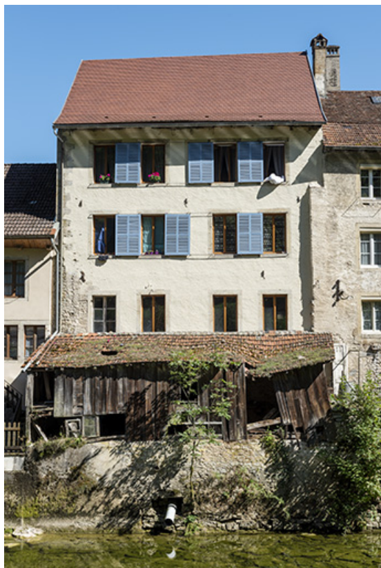
Immeuble 3 place du Chapitre : façade postérieure. 25, Saint-Hippolyte, 2-4 impasse de la Tannerie
