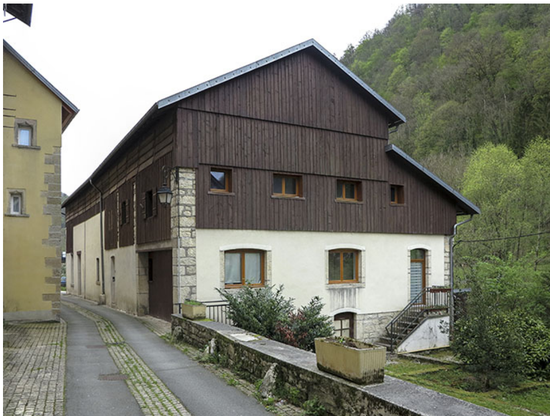
Tannerie : façades antérieure et latérale gauche.
