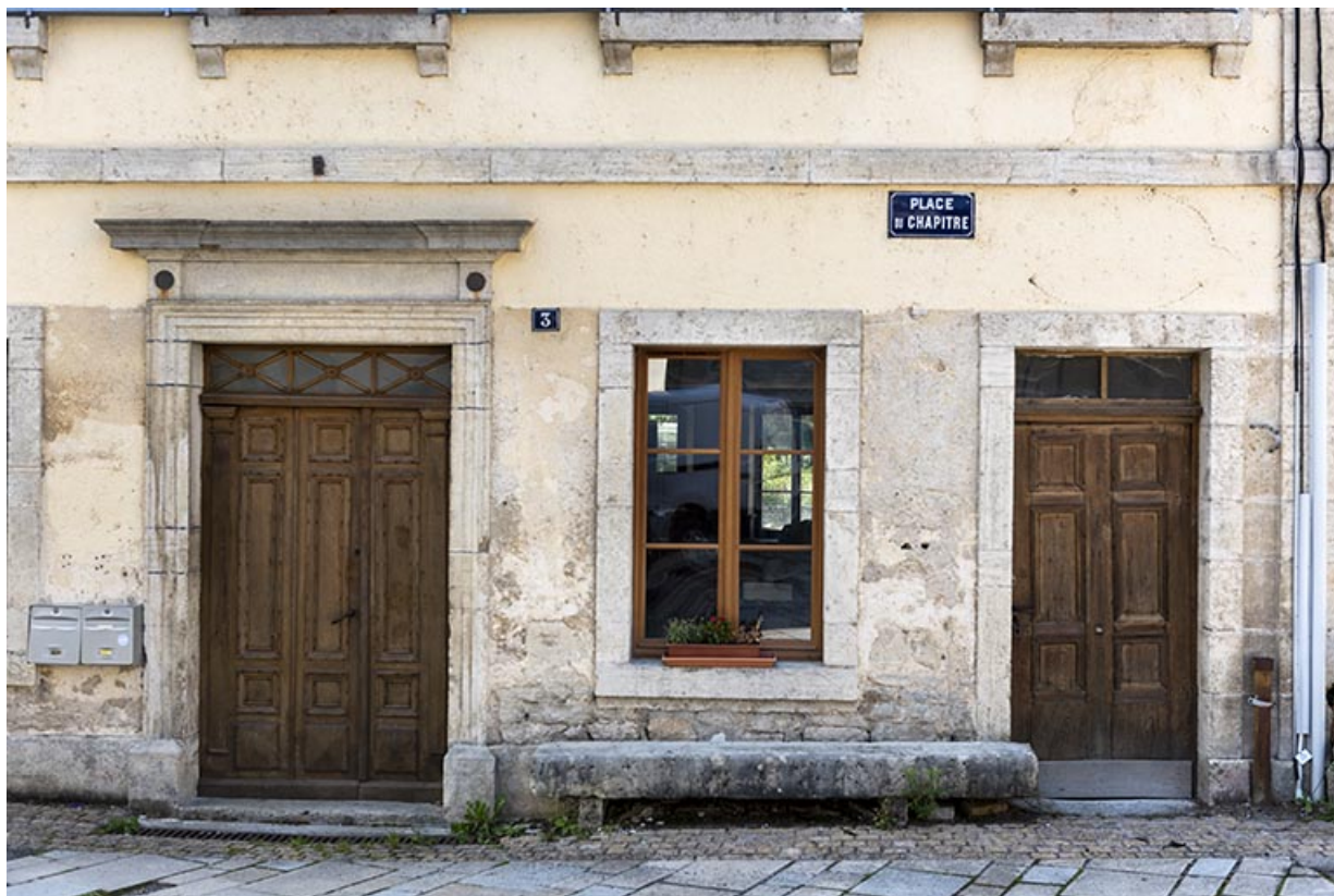
Immeuble 3 place du Chapitre, façade antérieure : entrée.
