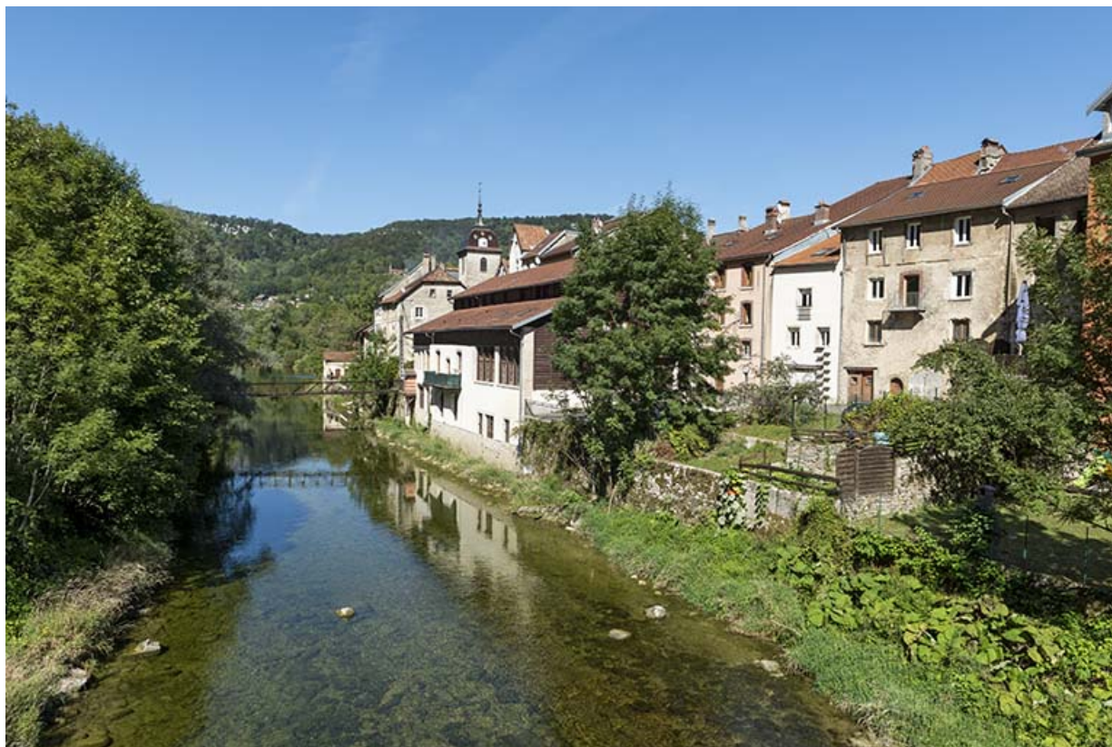
Vue d'ensemble, depuis le pont au sud.
