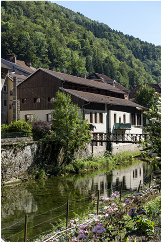
Tannerie : vue d'ensemble, depuis le nord-ouest (façades antérieure et latérale droite). 25, Saint-Hippolyte, 2-4 impasse de la Tannerie
