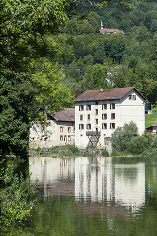
Façades postérieure et latérale gauche. 25, Saint-Hippolyte, 5 rue du Moulin Neuf
