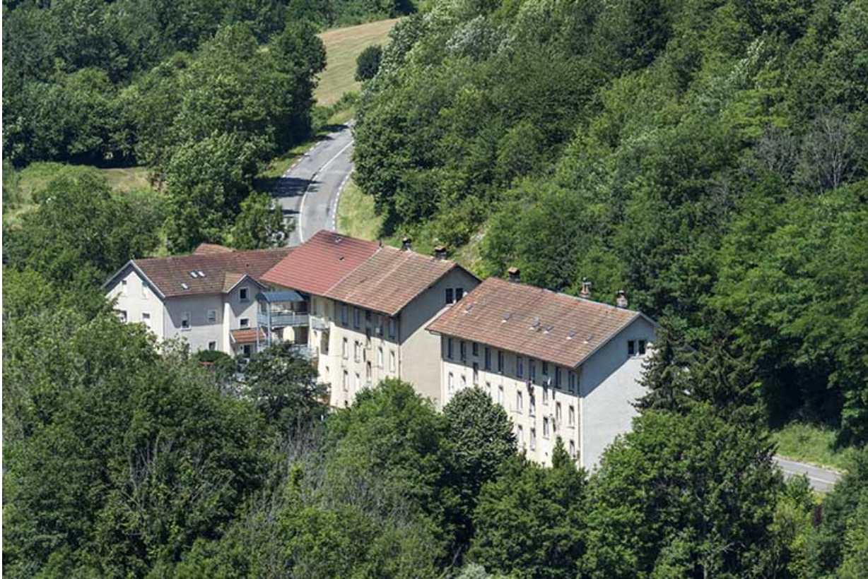
Vue d'ensemble plongeante rapprochée, depuis le sud-est.
