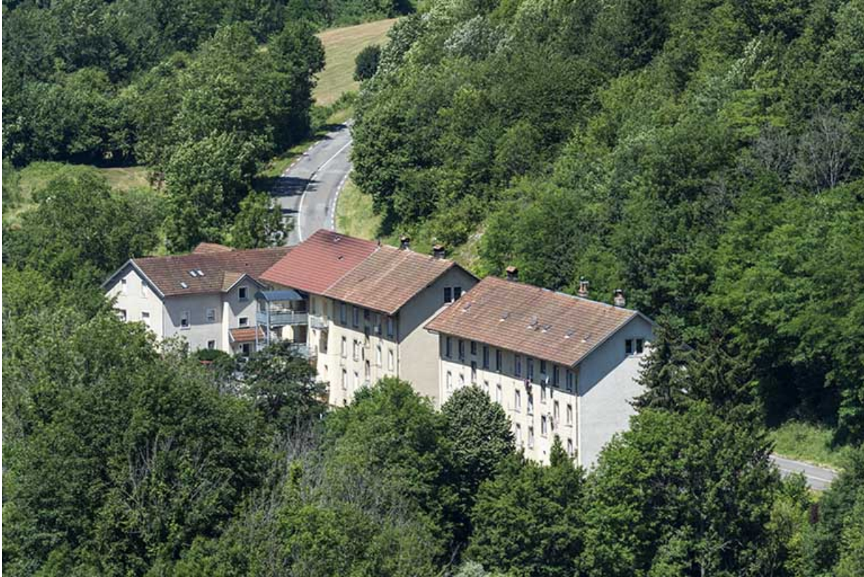
Vue d'ensemble plongeante rapprochée, depuis le sud-est.
