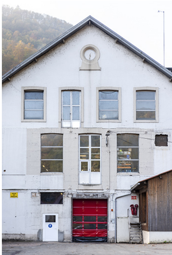
Atelier de fabrication (ancienne pointerie) : façade antérieure.
