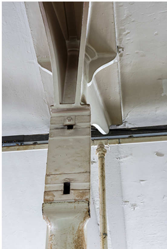
Atelier de fabrication (ancienne tréfilerie, 1er étage) : chapiteau du poteau en fonte et système de fixation des supports de transmission.
