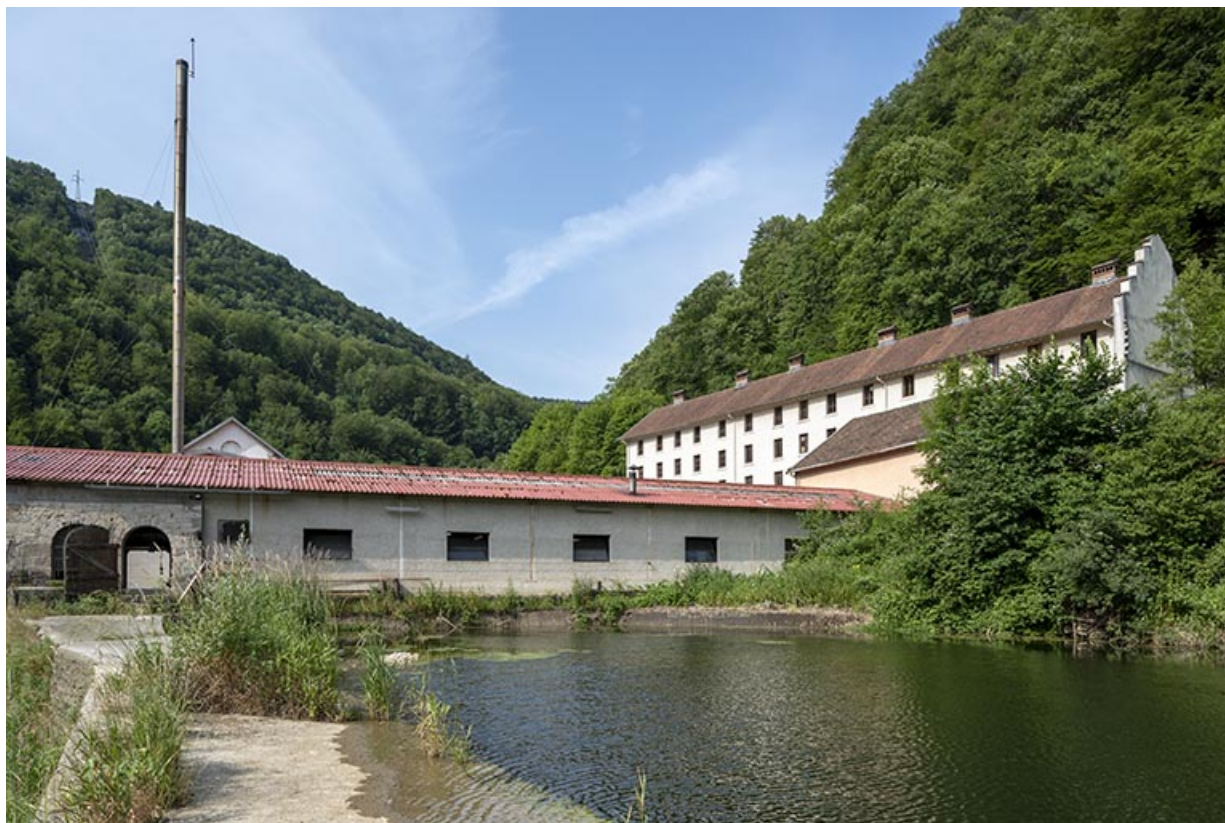
Bâtiment d'eau et entrepôt industriel, depuis l'amont (façade postérieure). 25, Liebvillers rue des Forges, lieudit : le Gouffre du Lods
