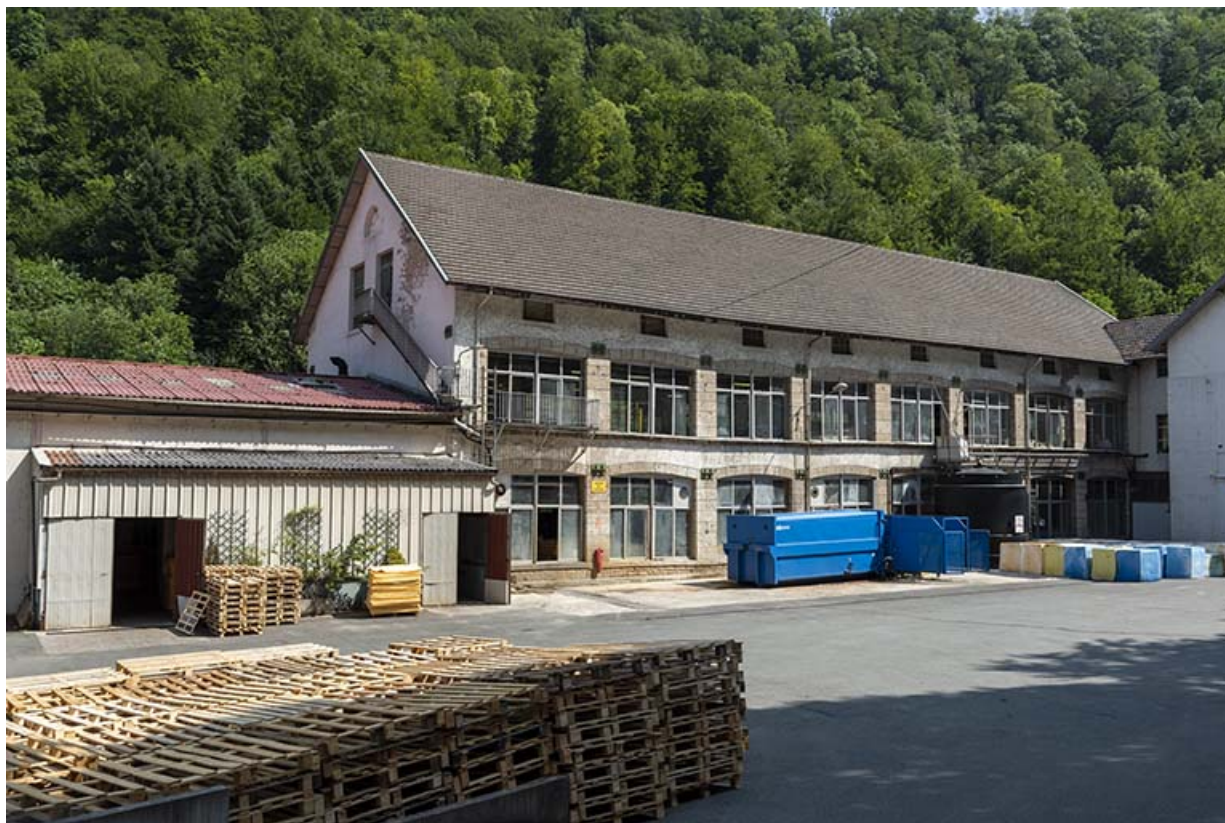
Atelier de fabrication (ancienne tréfilerie) : façade antérieure, de trois quarts gauche. 25, Liebvillers rue des Forges, lieudit : le Gouffre du Lods
