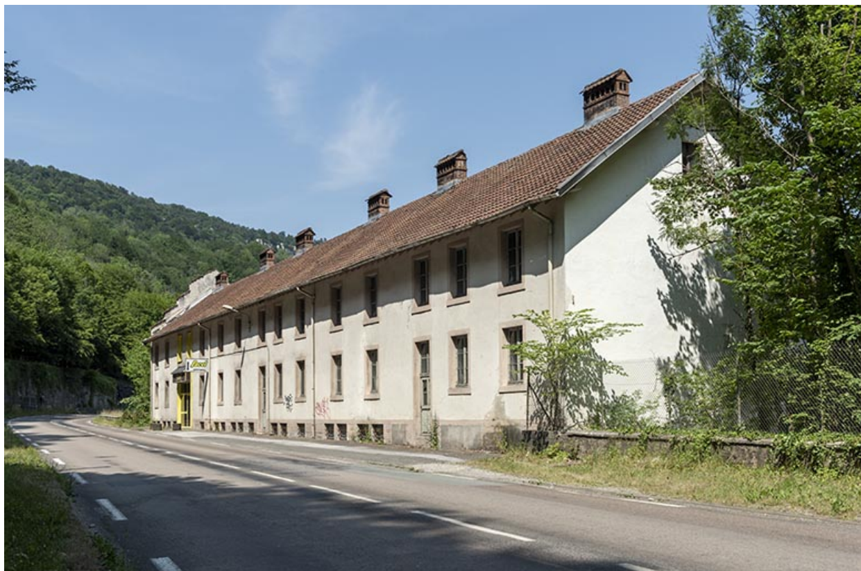
Bureau (anciens logements), depuis la route : façade antérieure, de trois quarts droite. 25, Liebvillers rue des Forges, lieudit : le Gouffre du Lods
