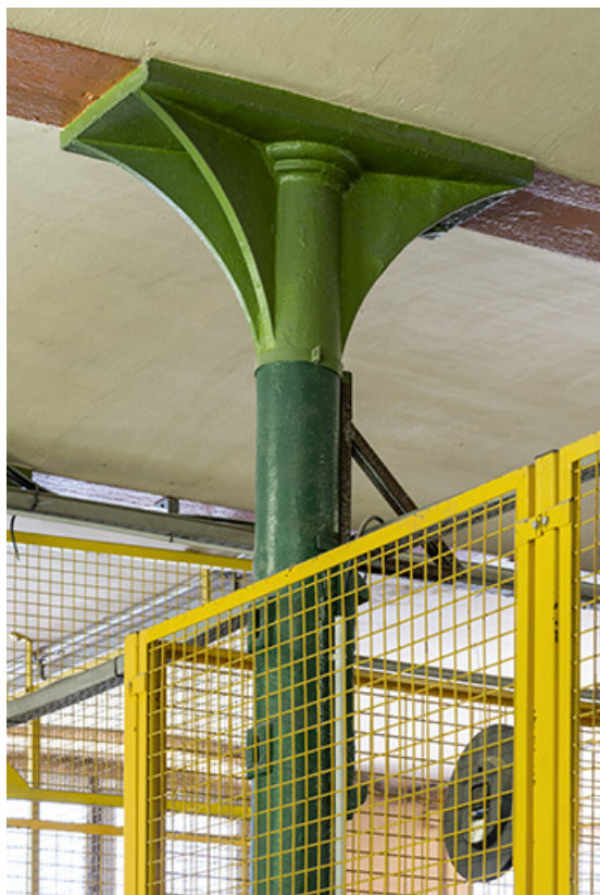
Atelier de fabrication (ancienne pointerie) : poteau en fonte (chapiteau). 25, Liebvillers rue des Forges, lieudit : le Gouffre du Lods
