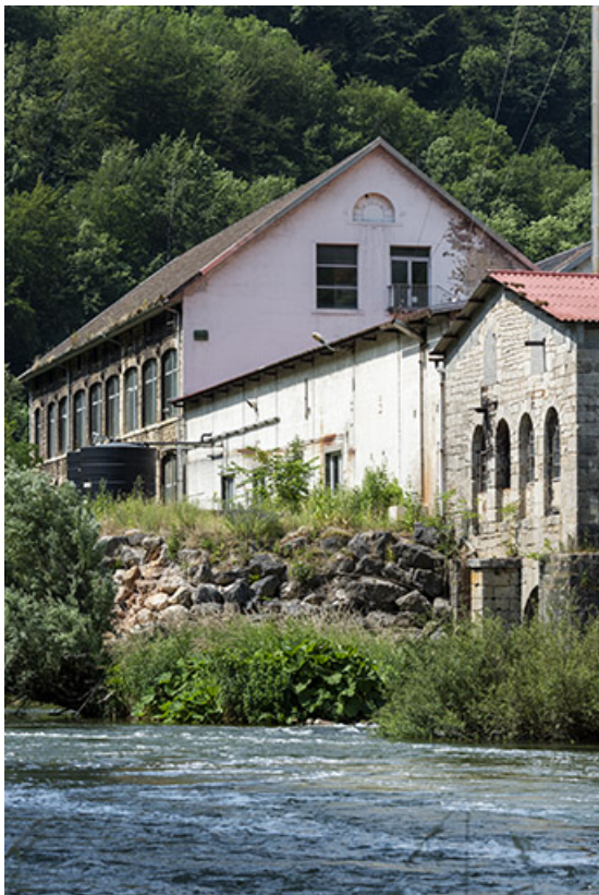
Magasin industriel et atelier de fabrication (ancienne tréfilerie) : façade postérieure. A droite, la façade latérale du bâtiment d'eau. 25, Liebvillers rue des Forges, lieudit : le Gouffre du Lods
