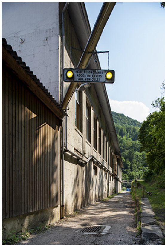
Atelier de fabrication (ancienne pointerie) : façade latérale droite, vue en enfilade. 25, Liebvillers rue des Forges, lieudit : le Gouffre du Lods
