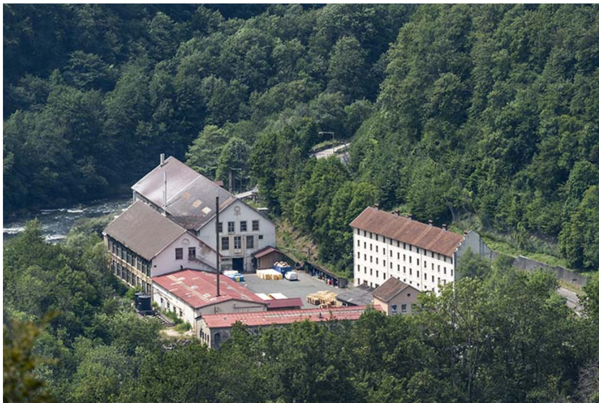
Anciennes forges au Gouffre du Lods, Liebvillers : vue d'ensemble plongeante, depuis le nord-est. 25, Liebvillers rue des Forges, lieudit : le Gouffre du Lods
