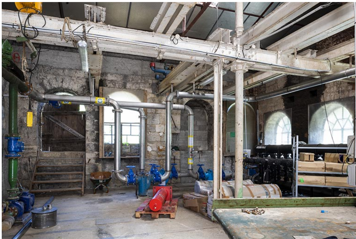
Bâtiment d'eau (actuellement station de pompage) : intérieur.
