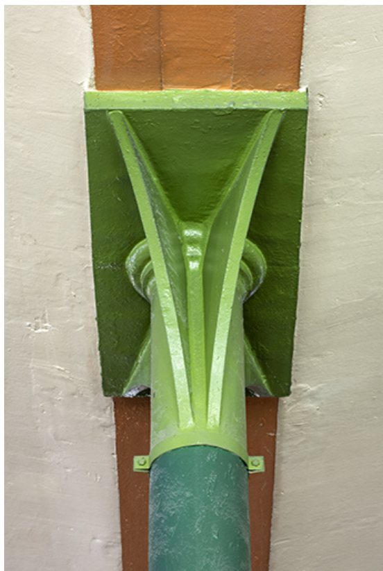
Atelier de fabrication (ancienne pointerie) : chapiteau d'un poteau en fonte. 25, Liebvillers rue des Forges, lieudit : le Gouffre du Lods
