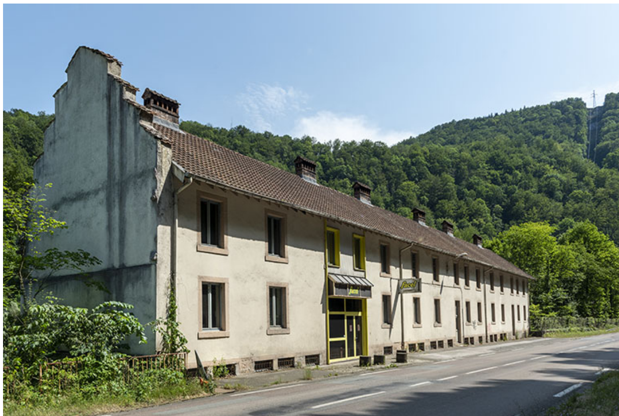
Bureau (anciens logements), depuis la route : façade antérieure, de trois quarts gauche. 25, Liebvillers rue des Forges, lieudit : le Gouffre du Lods
