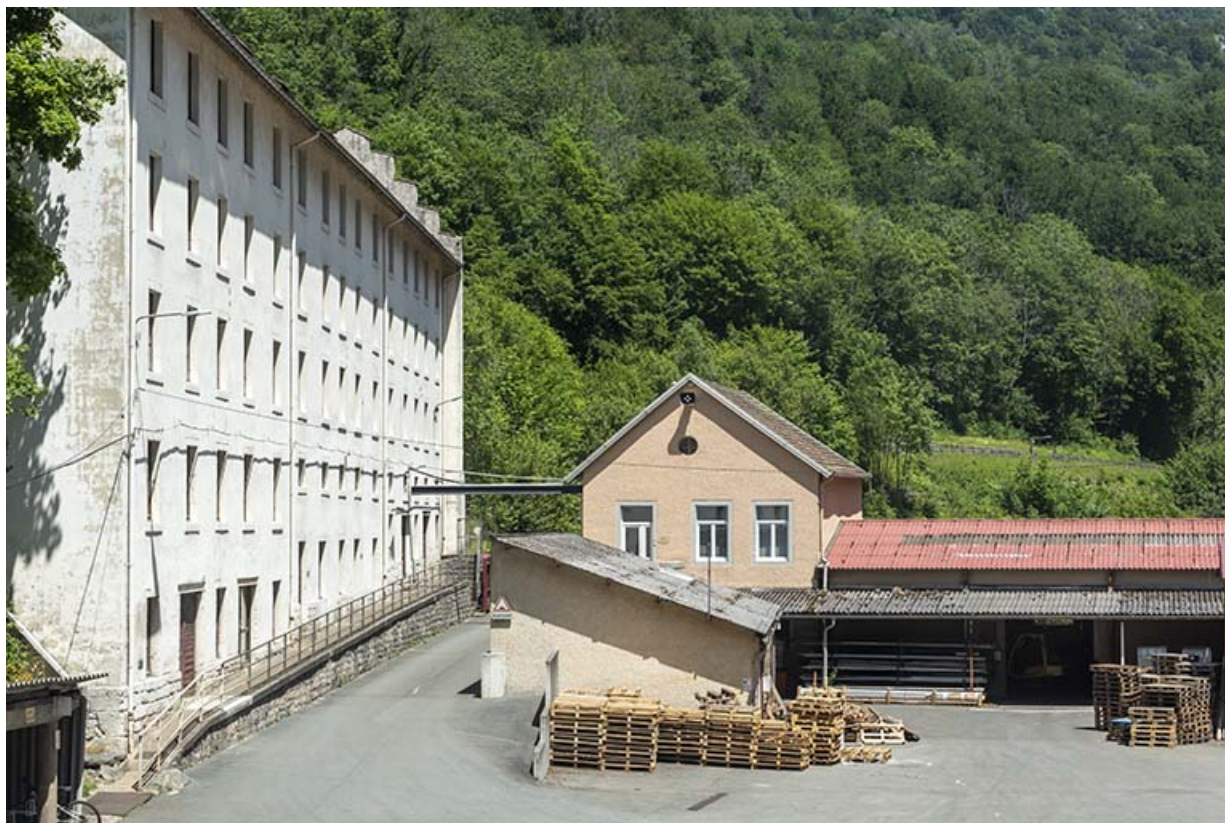
Entrée du site, depuis la cour : bureau à gauche, laboratoire au centre et entrepôts industriels. 25, Liebvillers rue des Forges, lieudit : le Gouffre du Lods
