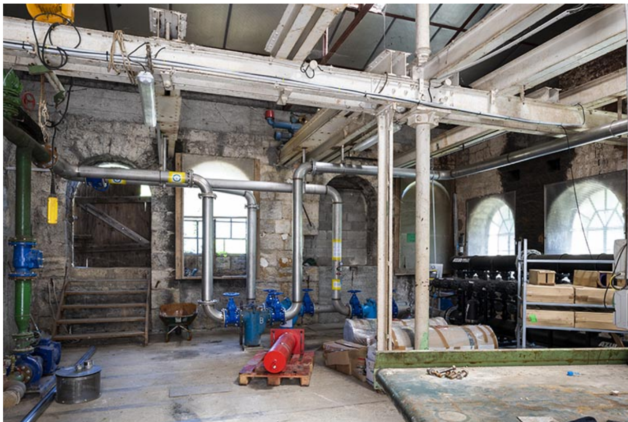
Bâtiment d'eau (actuellement station de pompage) : intérieur.
