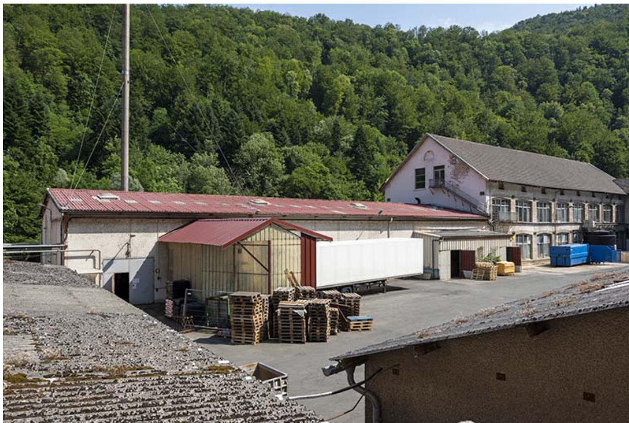
Magasin industriel (1968-1975) et atelier de fabrication (ancienne tréfilerie, 1897). 25, Liebvillers rue des Forges, lieudit : le Gouffre du Lods
