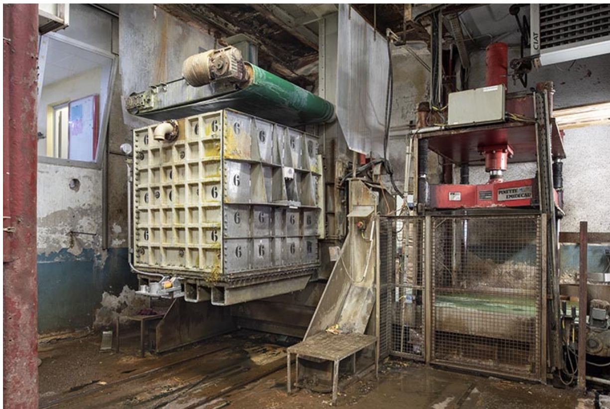
Fabrication : moule sur le poste de démoulage, avec presse à droite. 25, Liebvillers rue des Forges, lieudit : le Gouffre du Lods
