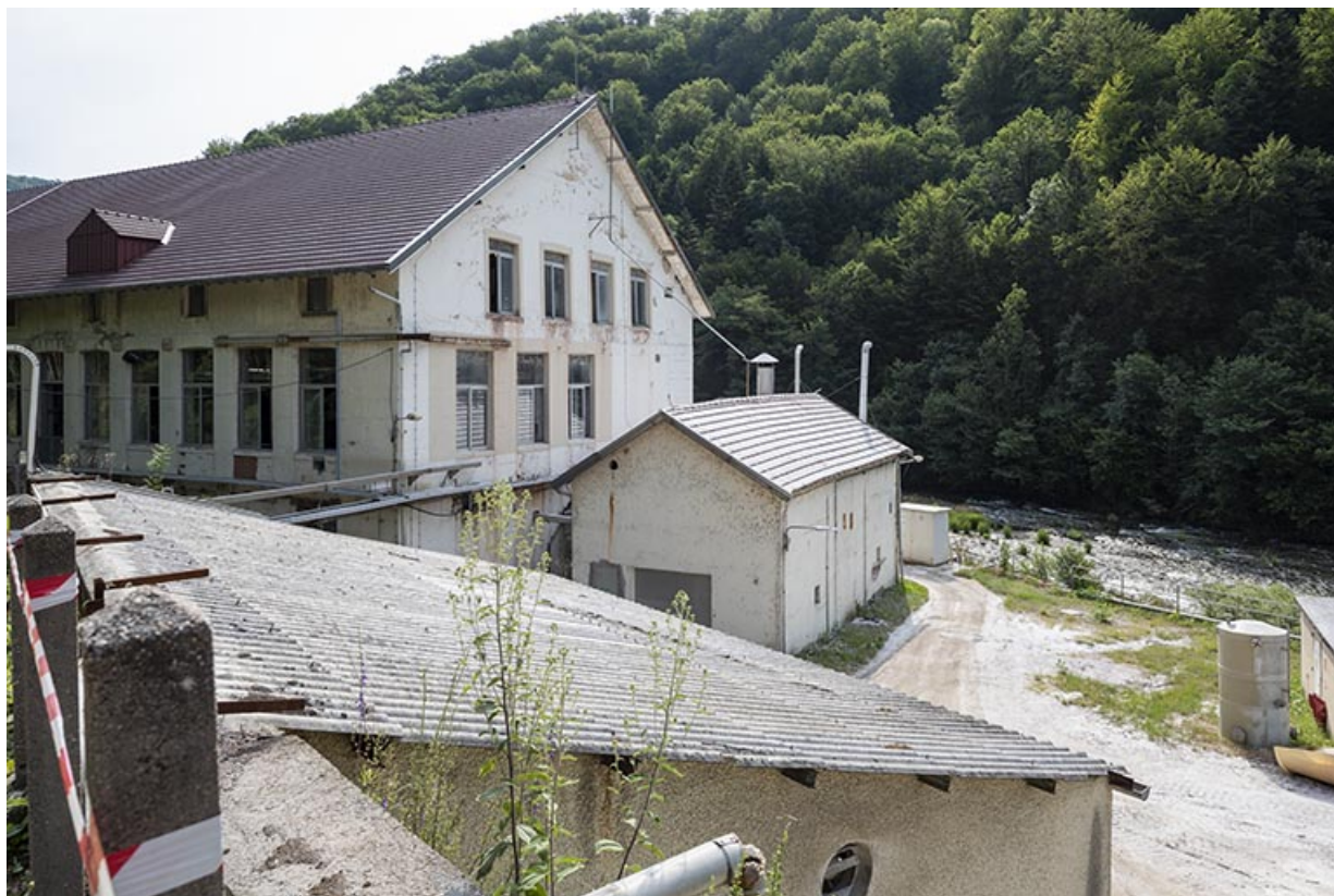
Atelier de fabrication (ancienne pointerie) : façades latérale droite et postérieure. 25, Liebvillers rue des Forges, lieudit : le Gouffre du Lods
