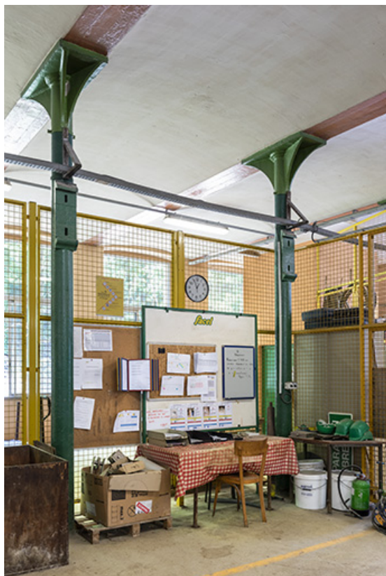
Atelier de fabrication (ancienne pointerie) : poteaux en fonte et voûtains en briques plâtrées. 25, Liebvillers rue des Forges, lieudit : le Gouffre du Lods
