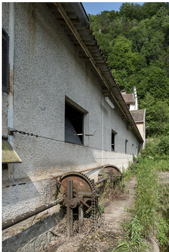
Entrepôt industriel, façade postérieure : prise d'eau, vue en enfilade. 25, Liebvillers rue des Forges, lieudit : le Gouffre du Lods
