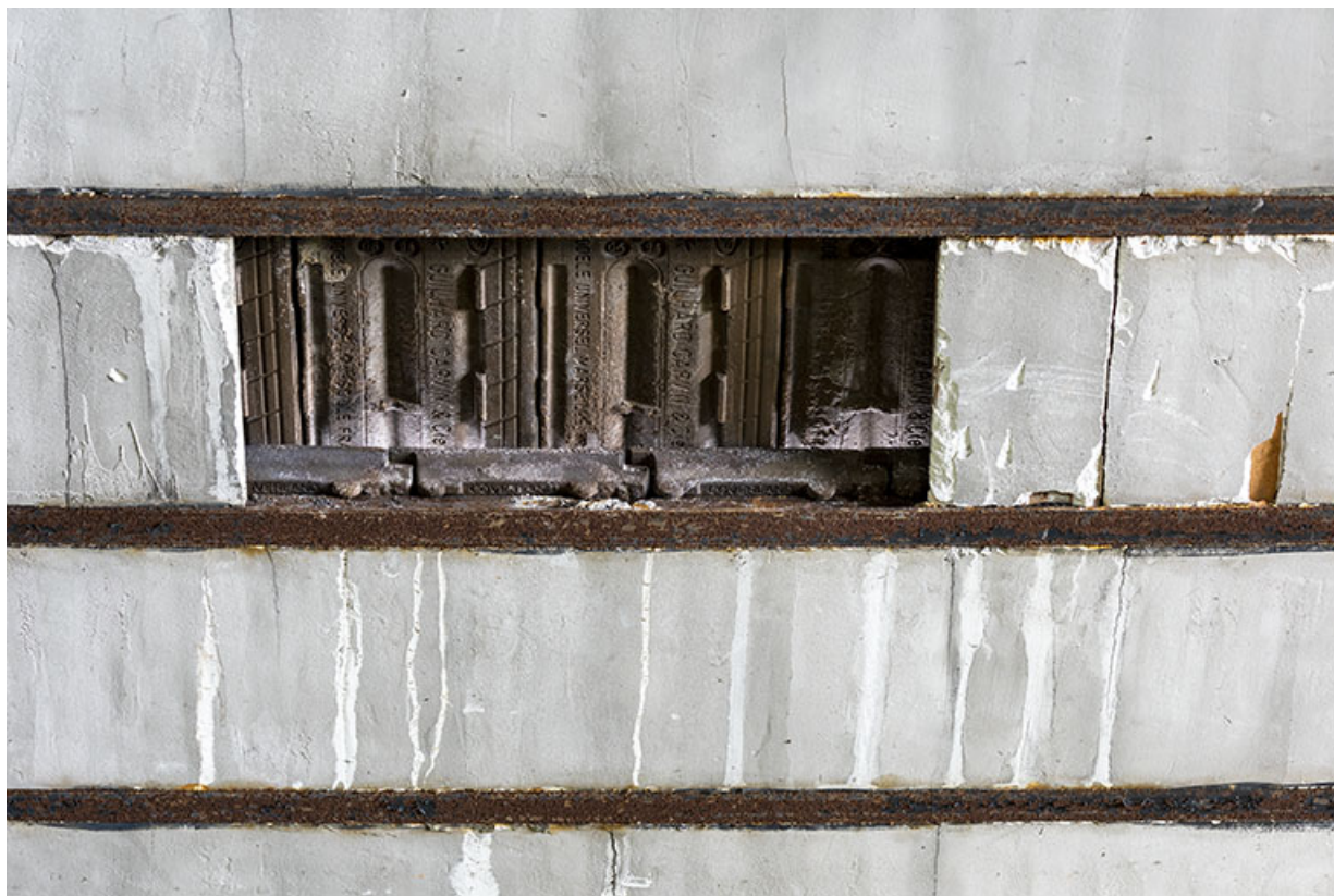
Atelier de fabrication (ancienne tréfilerie) : hourdis de briques plâtrées maintenues par la charpente métallique. 25, Liebvillers rue des Forges, lieudit : le Gouffre du Lods
