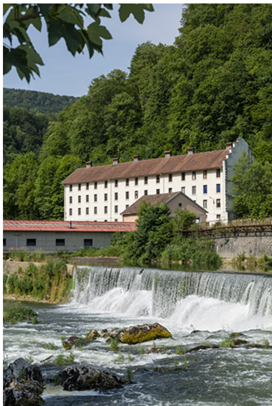
Bureau (anciens logements) : façade postérieure de trois quarts, depuis la rive droite 25, Liebvillers rue des Forges, lieudit : le Gouffre du Lods
