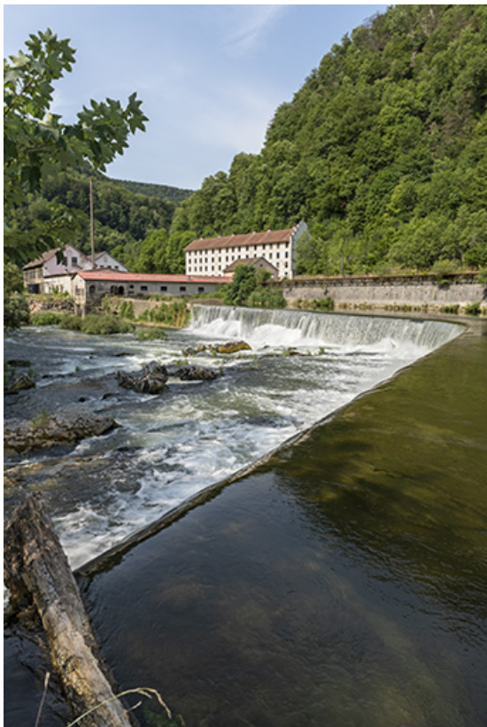
Barrage, depuis son extrémité sur la rive droite.
