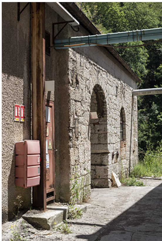
Bâtiment d'eau : façade antérieure, vue en enfilade. 25, Liebvillers rue des Forges, lieudit : le Gouffre du Lods
