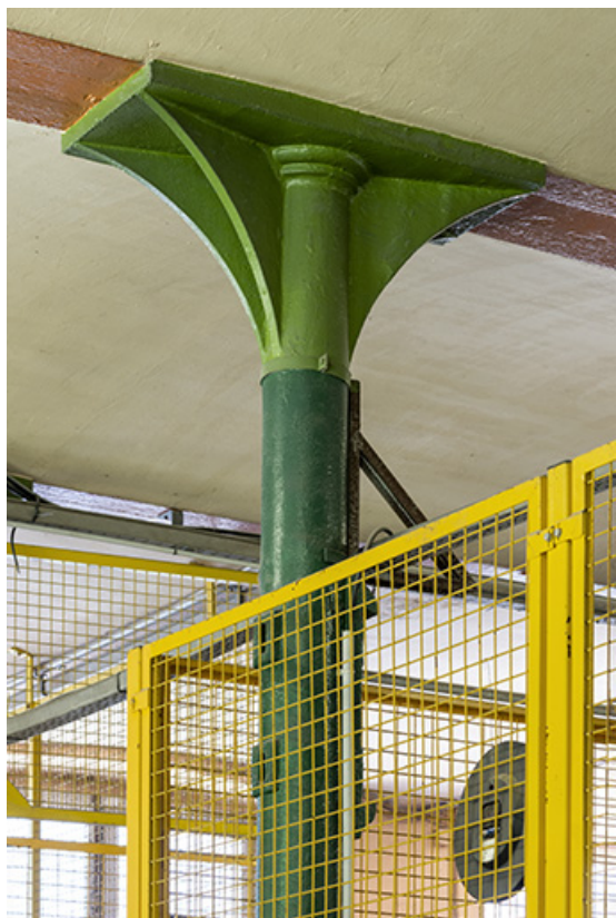
Atelier de fabrication (ancienne pointerie) : poteau en fonte (chapiteau). 25, Liebvillers rue des Forges, lieudit : le Gouffre du Lods
