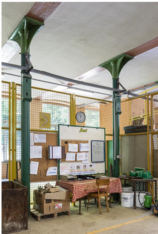
**Atelier de fabrication (ancienne pointerie) : poteaux en fonte et voûtains en briques plâtrées.**
