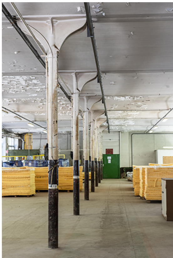
Atelier de fabrication (ancienne tréfilerie, 1er étage) : poteaux en fonte et voûtains en briques plâtrées. 25, Liebvillers rue des Forges, lieudit : le Gouffre du Lods
