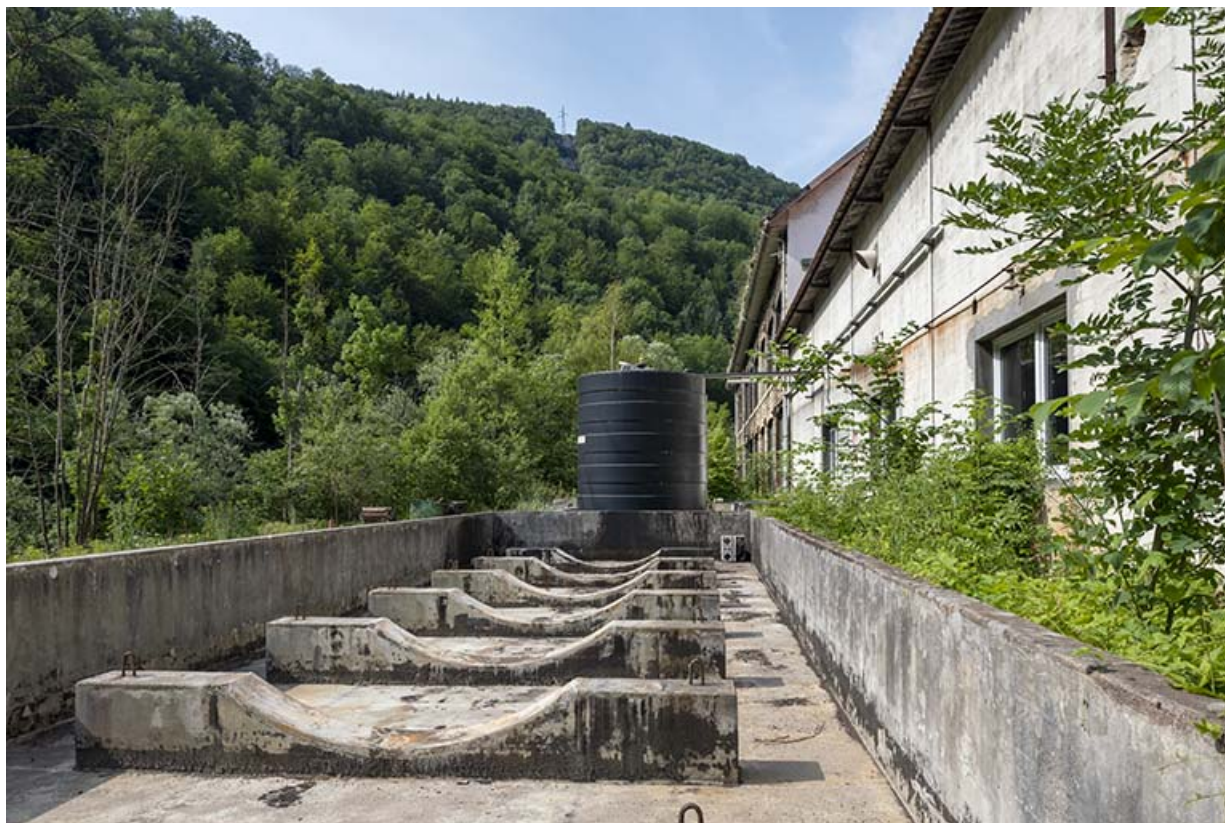
Magasin industriel (façade postérieure) et supports de cuve.
