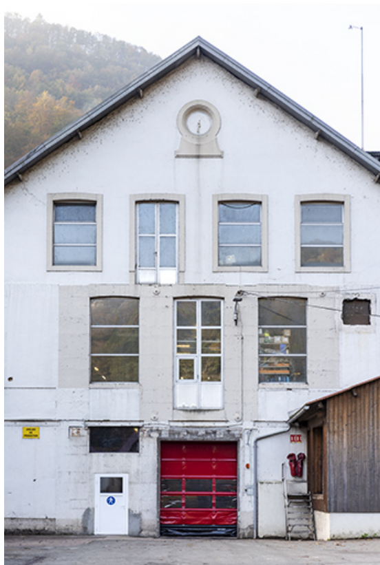
Atelier de fabrication (ancienne pointerie) : façade antérieure.
