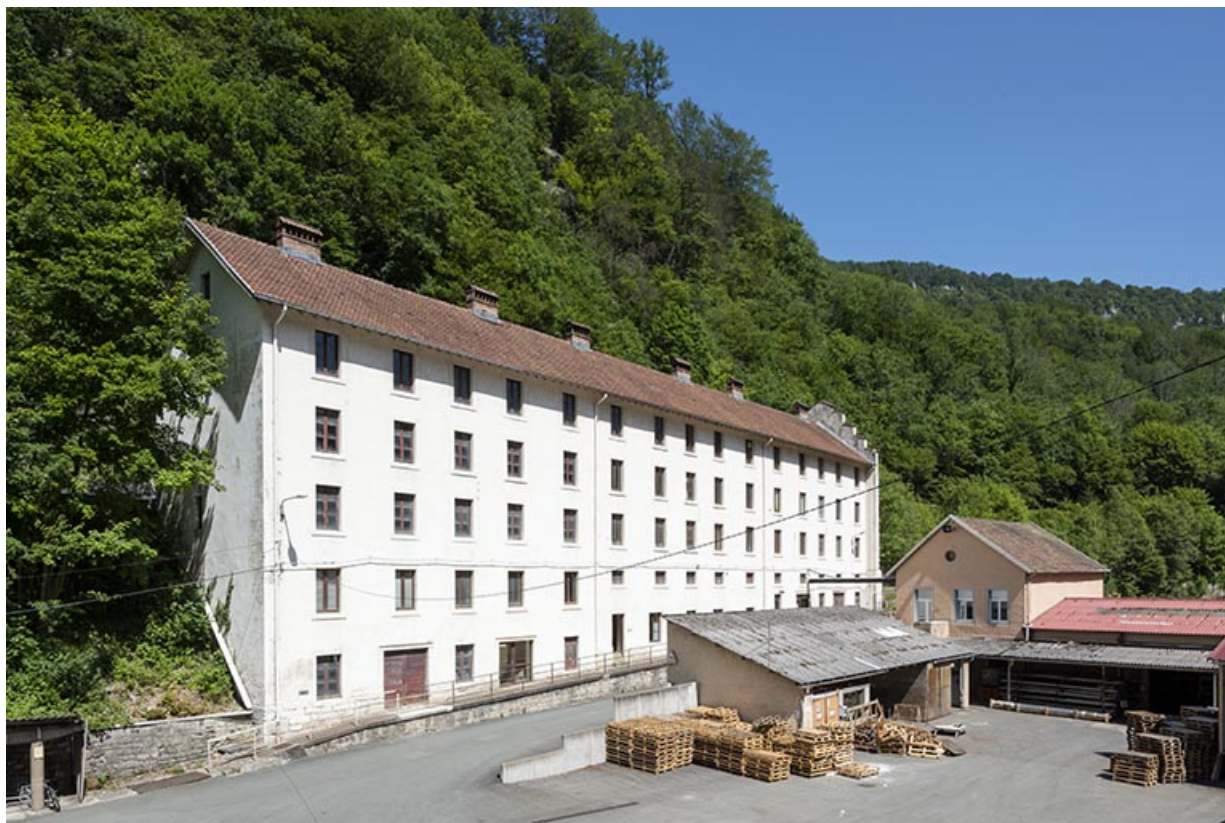
Bureau (anciens logements) : façade postérieure, de trois quarts gauche.
