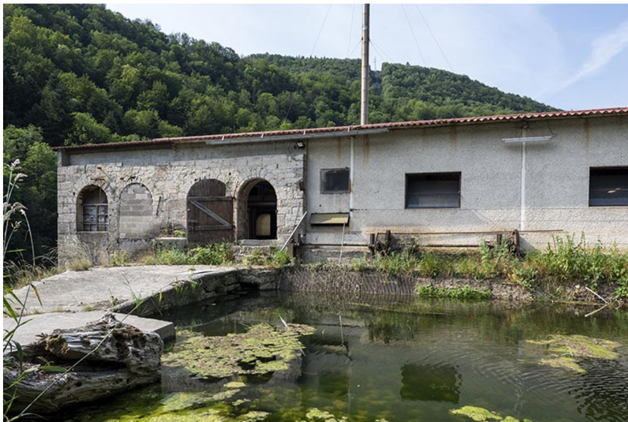
Bâtiment d'eau, façade postérieure : extrémité du barrage et prise d'eau.
