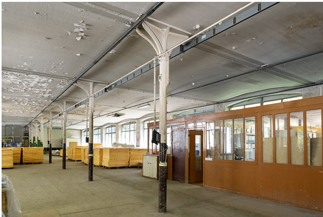
Atelier de fabrication (ancienne tréfilerie) : intérieur au 1er étage.
