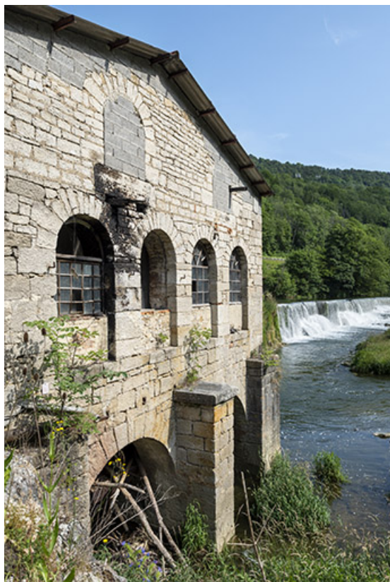
Bâtiment d'eau : façade latérale droite, vue en enfilade. 25, Liebvillers rue des Forges, lieudit : le Gouffre du Lods
