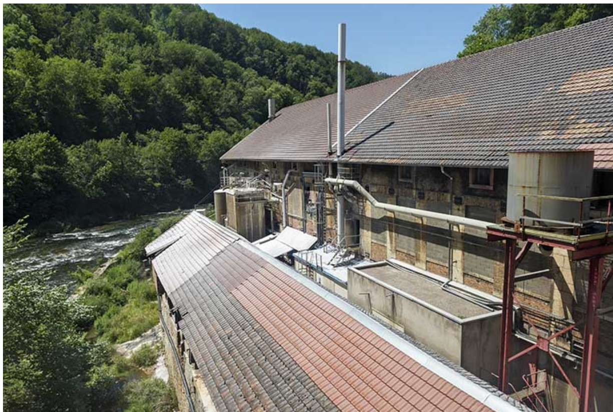
Atelier de fabrication (ancienne pointerie) : façade latérale gauche, vue en enfilade.
