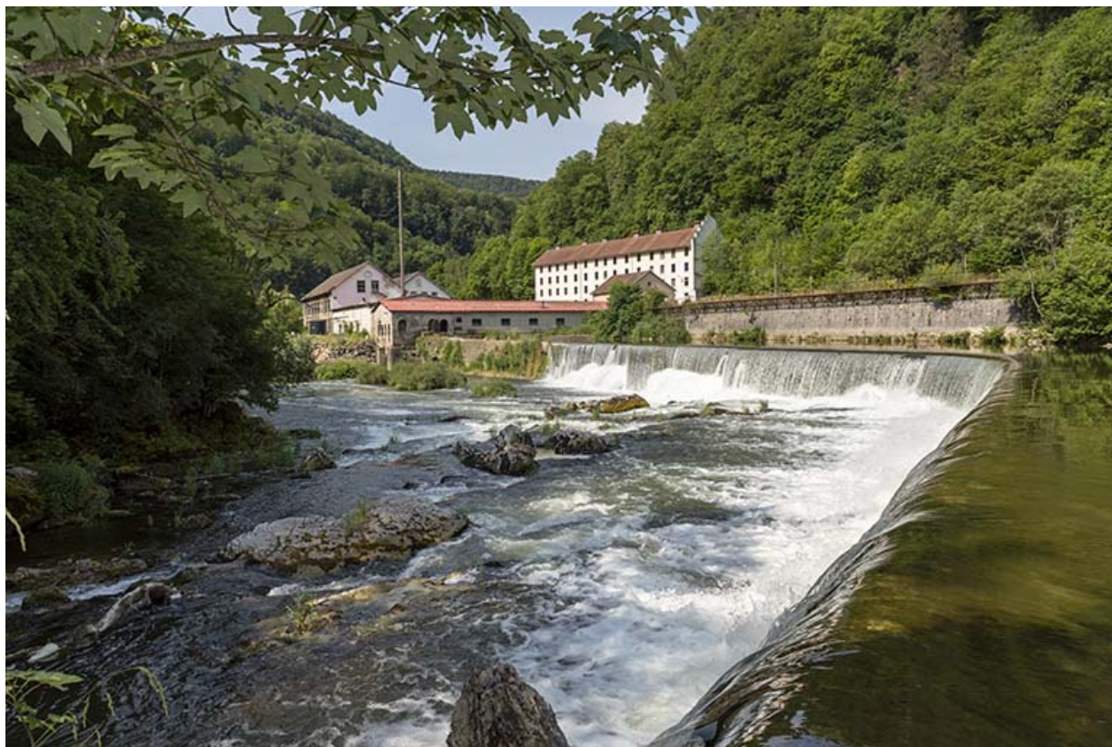
Vue d'ensemble, depuis l'extrémité du barrage au nord-est.
