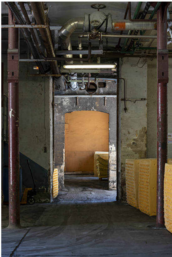
Atelier de fabrication (ancienne pointerie) : passage vers l'ancienne tréfilerie. 25, Liebvillers rue des Forges, lieudit : le Gouffre du Lods
