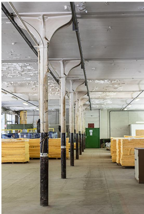
**Atelier de fabrication (ancienne tréfilerie, 1er étage) : poteaux en fonte et voûtains en briques plâtrées.**
