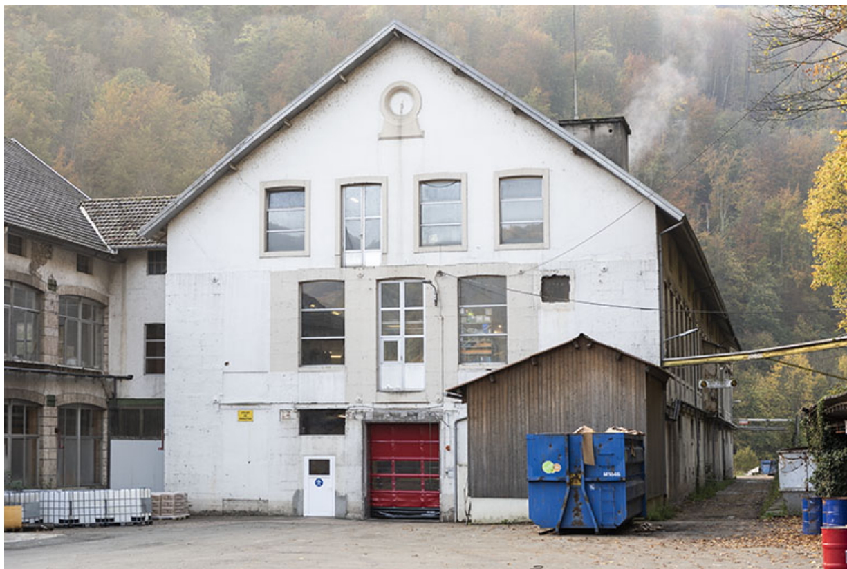
Atelier de fabrication (ancienne pointerie) : façade antérieure, de trois quarts droite.
