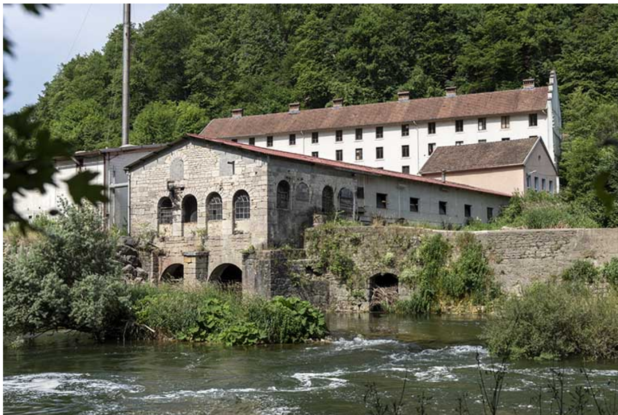
Bâtiment d'eau et entrepôt industriel, depuis la rive droite (est).
