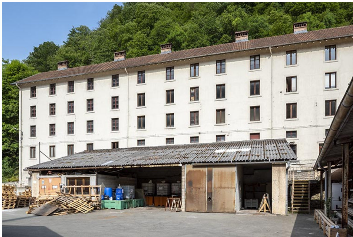
Bureau (façade postérieure) et entrepôt industriel. 25, Liebvillers rue des Forges, lieudit : le Gouffre du Lods
