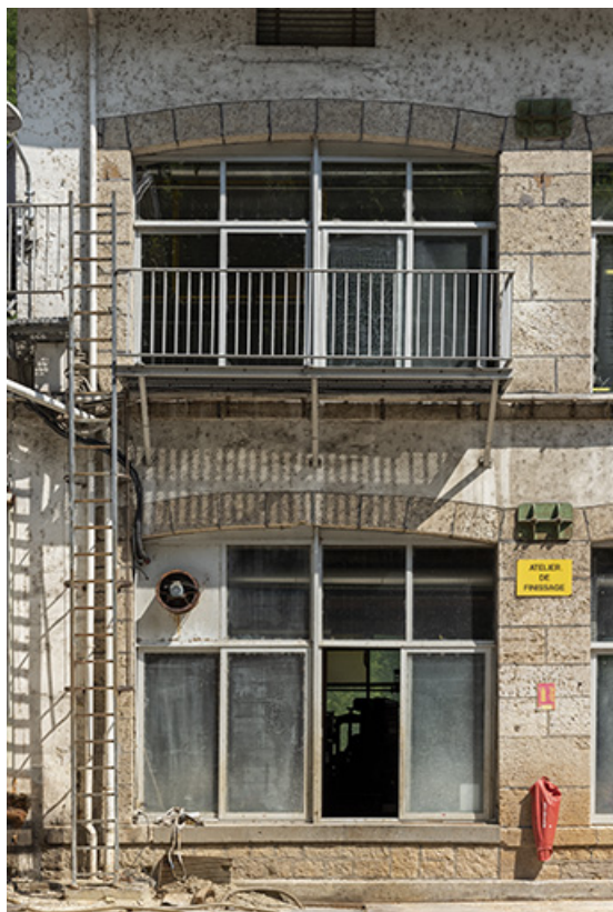
Atelier de fabrication (ancienne tréfilerie), façade antérieure : une travée.
