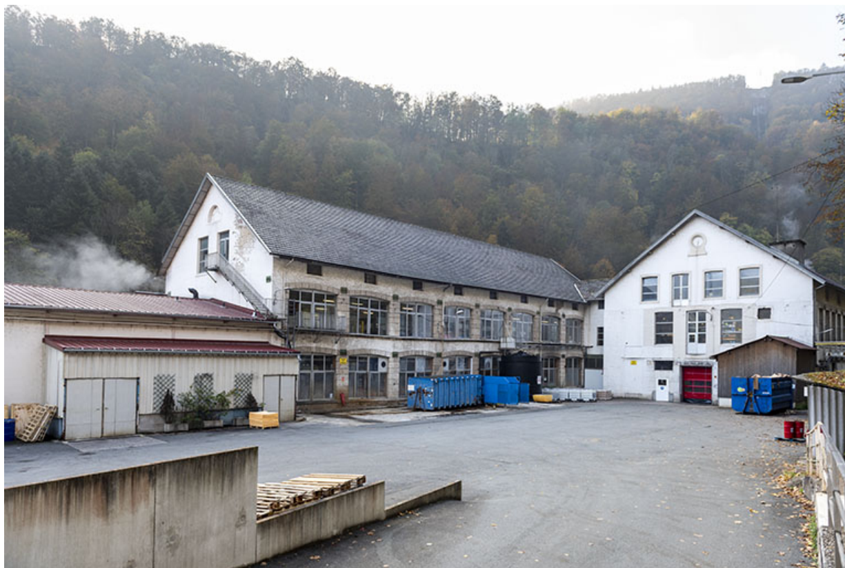
Anciennes forges : bâtiments de 1897 (tréfilerie au centre et pointerie à droite). 25, Liebvillers rue des Forges, lieudit : le Gouffre du Lods
