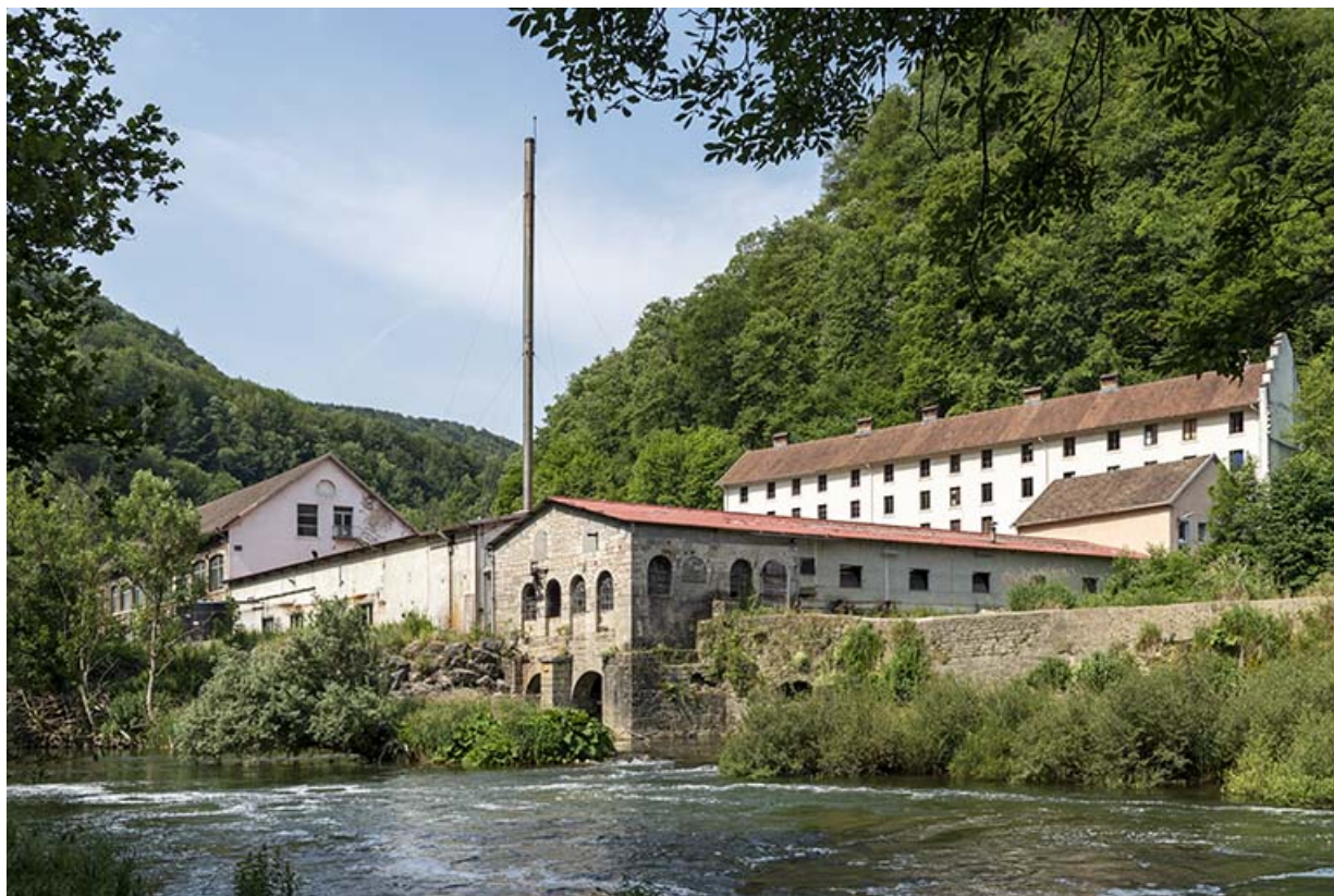
Anciennes forges : vue d'ensemble, depuis l'extrémité du barrage au nord-est. 25, Liebvillers rue des Forges, lieudit : le Gouffre du Lods
