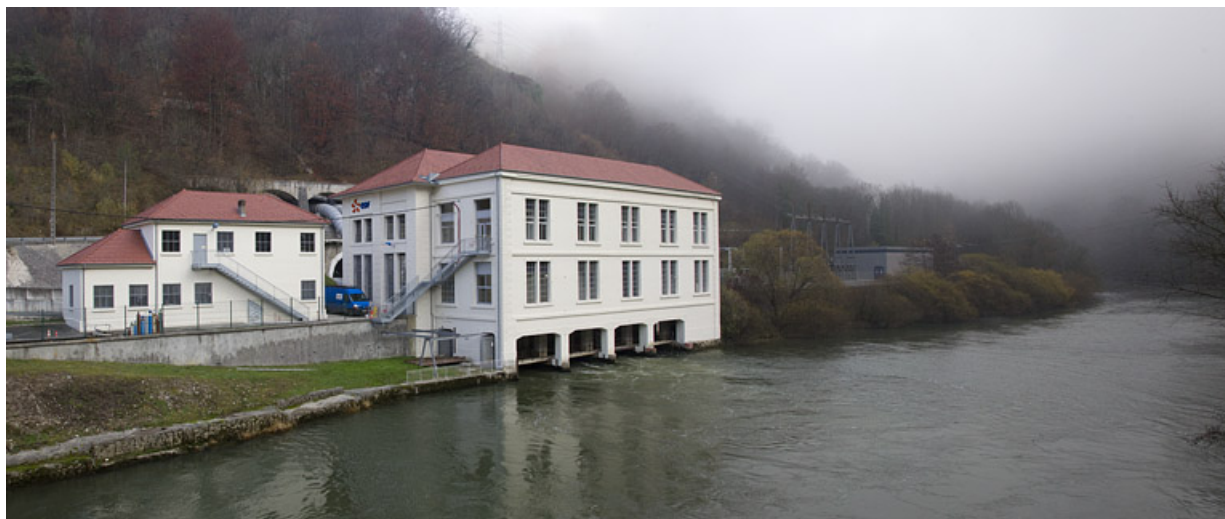
Vue d'ensemble depuis le sud-ouest (aval rive gauche).
