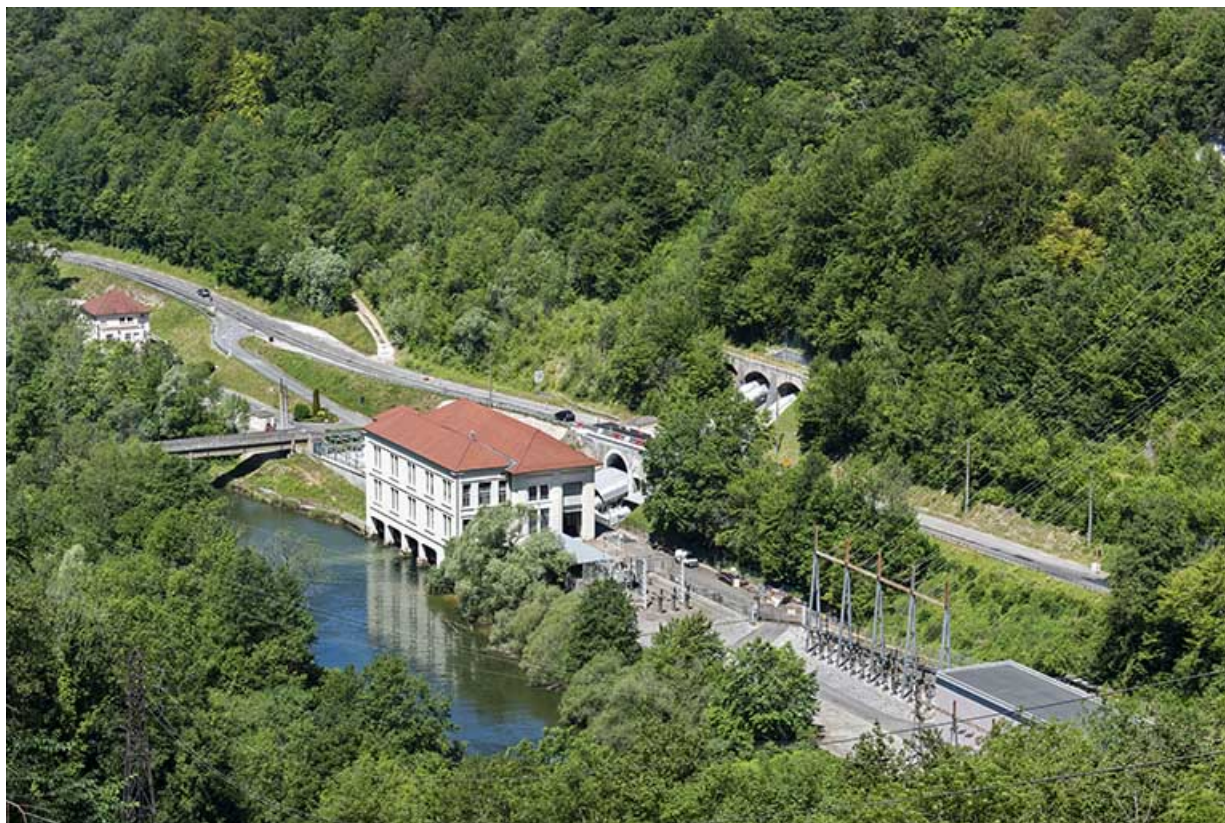
Vue d'ensemble plongeante, depuis le sud-est.
