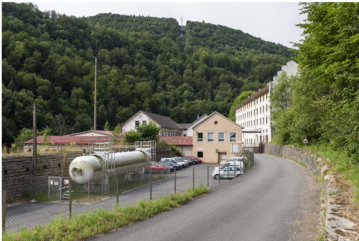
Anciennes forges : vue d'ensemble, depuis l'entrée au nord.
