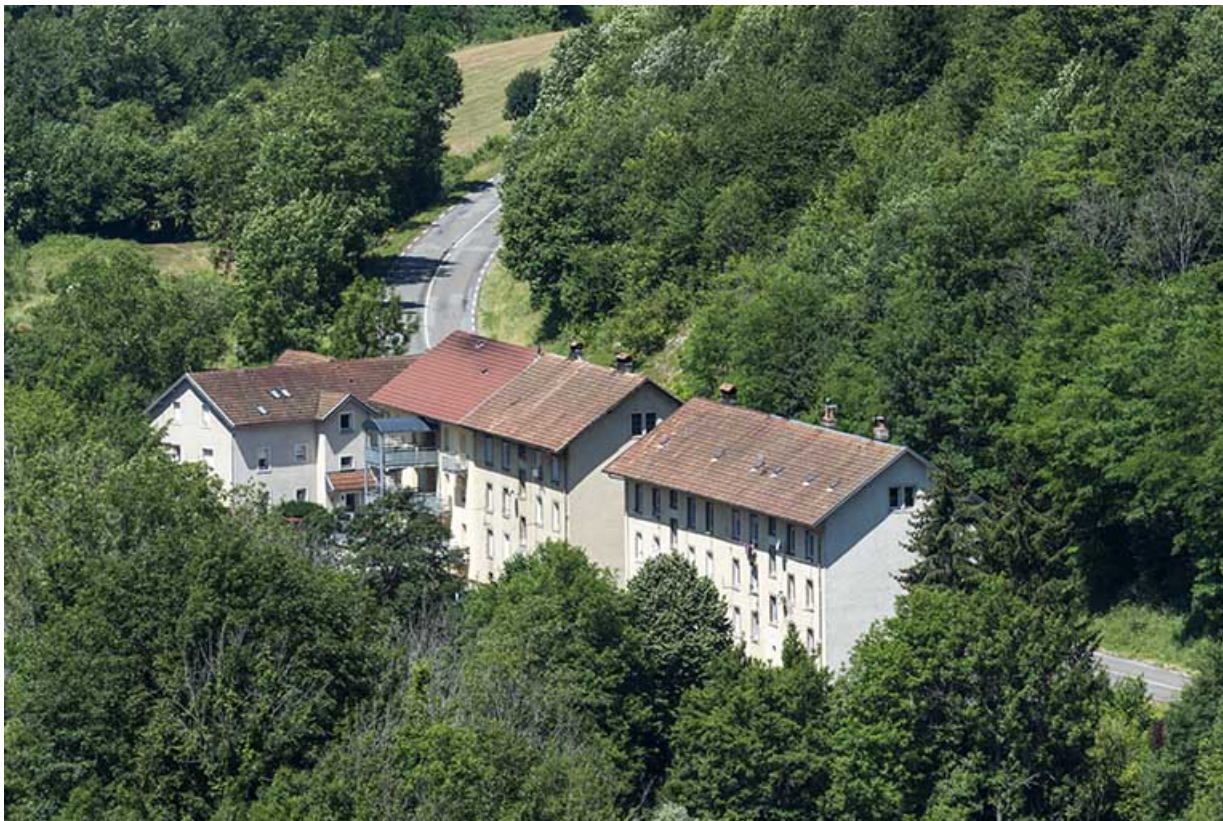
Vue d'ensemble plongeante rapprochée, depuis le sud-est.
