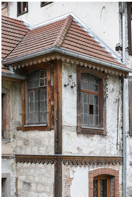
Usine (3e corps de bâtiment) : bureau du contremaître. 25, Liebvillers, 2-4 impasse du Moulin
