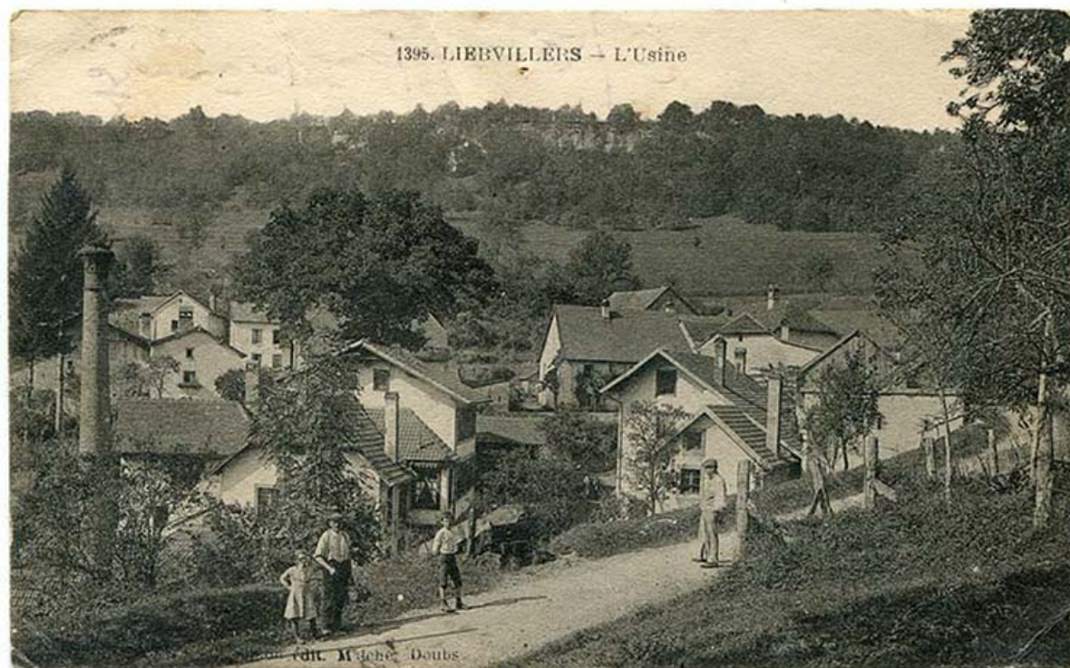
1395. Liebvillers - L'usine, 1ère moitié 20e siècle [avant 1932].
