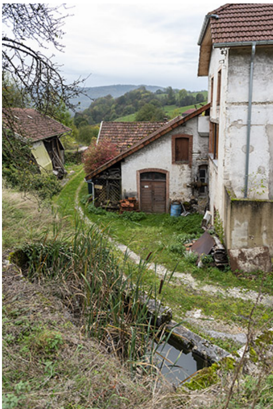
Bâtiment d'eau, vu de l'est.
