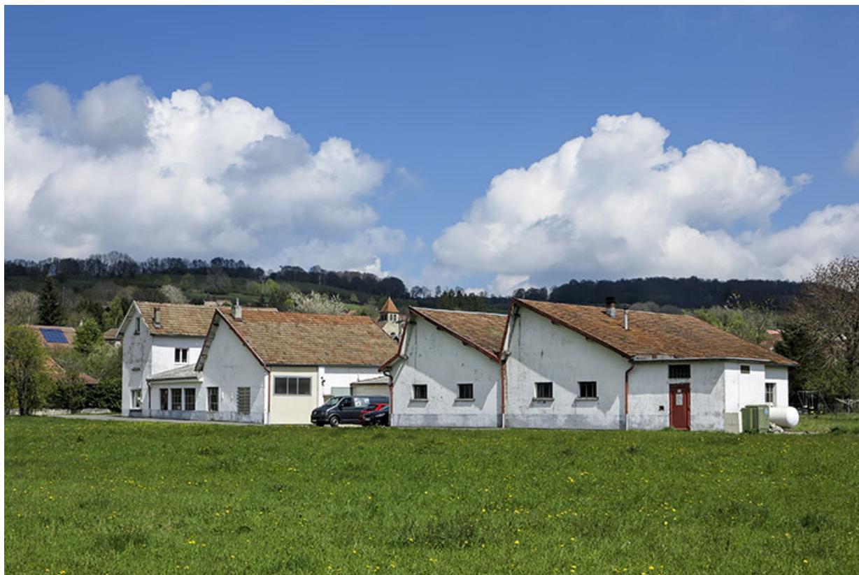
Vue d'ensemble, depuis le sud-ouest (façade latérale droite).
