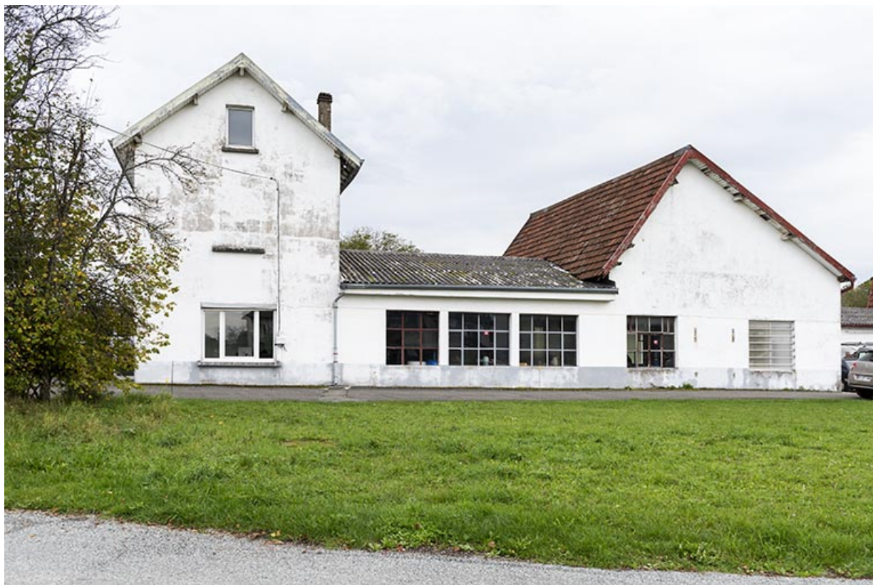
Bâtiments nord : façade latérale droite.
