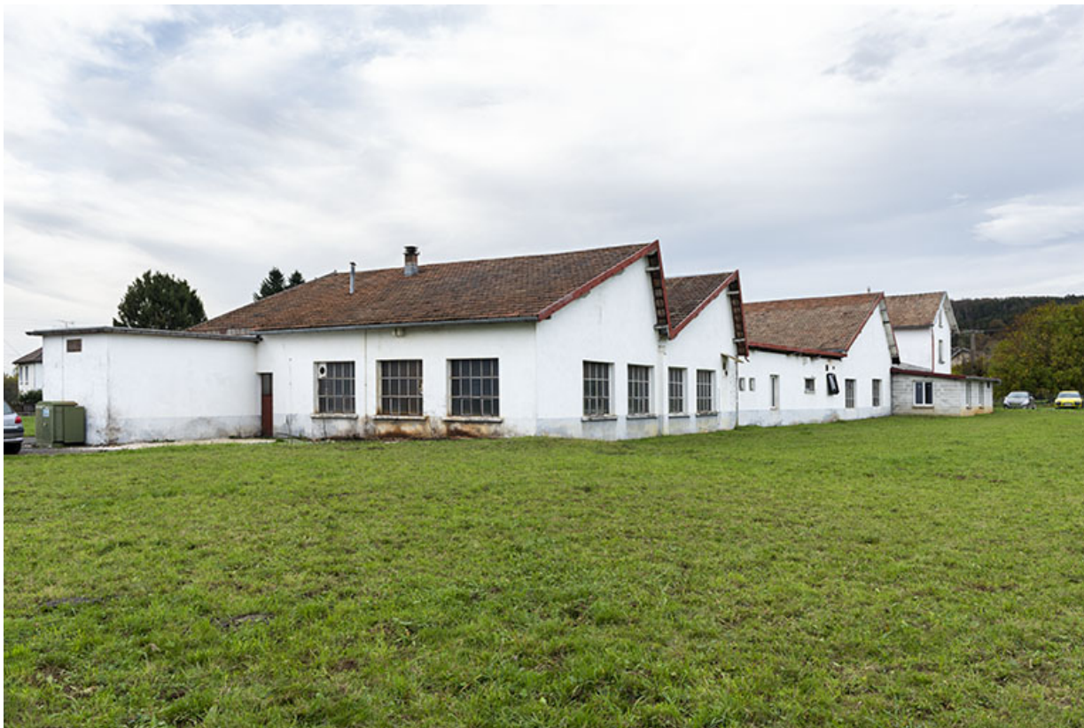
Vue d'ensemble, depuis le sud-est (façade latérale gauche). 25, Montécheroux, 18 rue de la Pâle
