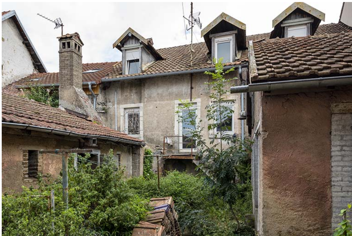
Façade postérieure. Dépendance à gauche, forge à droite.
