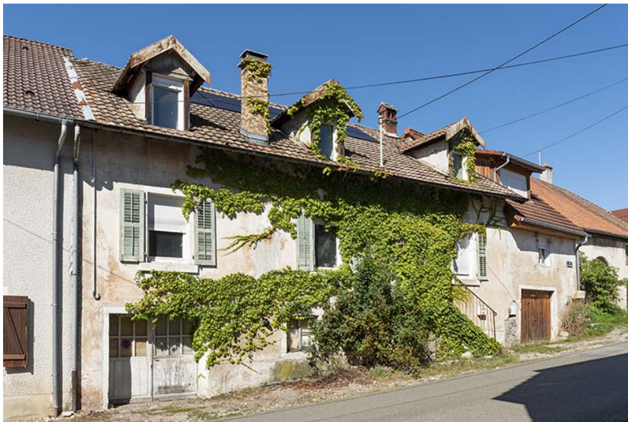
Façade antérieure, de trois quarts gauche. 25, Montécheroux, 6 rue de Saint-Hippolyte
