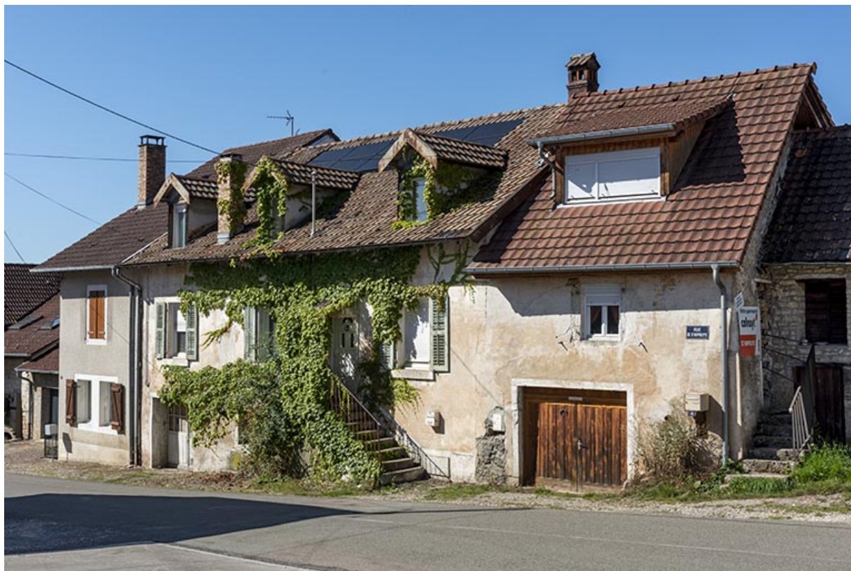
Vue d'ensemble, de trois quarts droite. La maison correspond au corps de bâtiment central.
