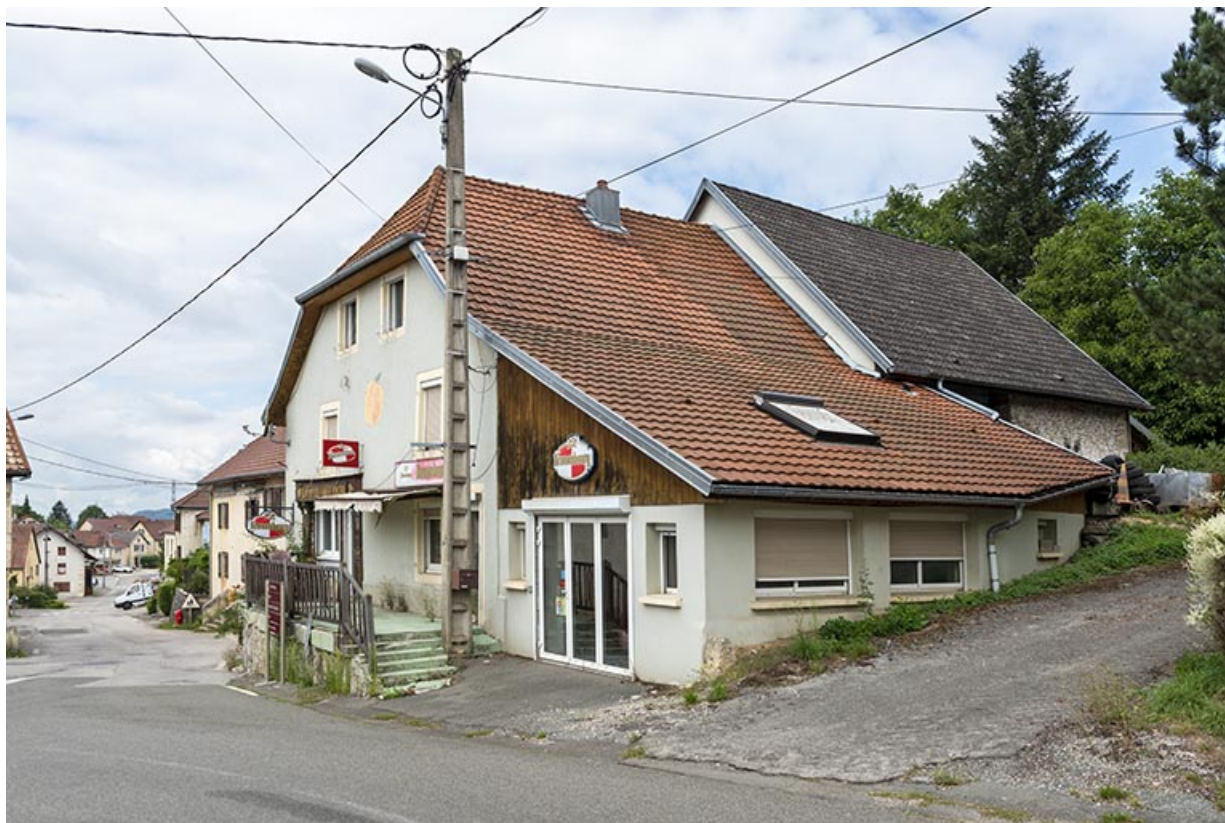
Façades antérieure et latérale droite.
