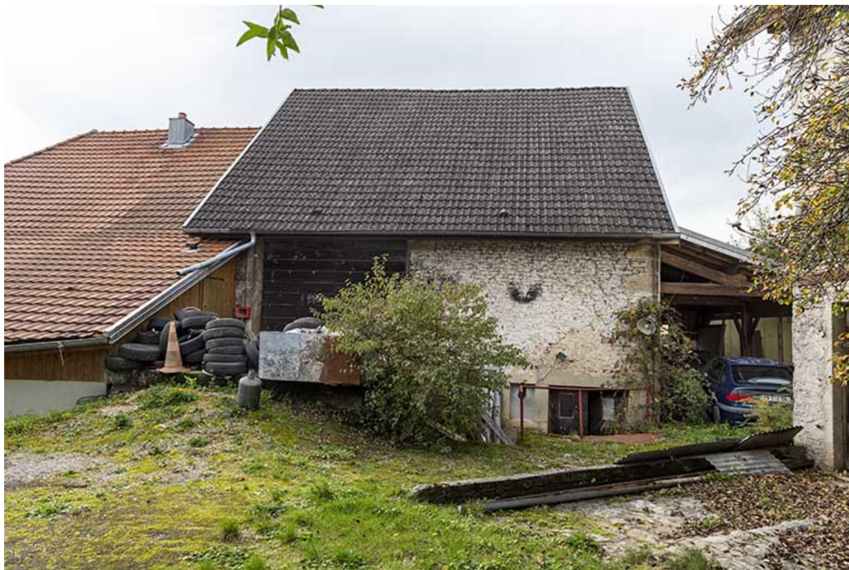
Façade latérale droite : la grange.
