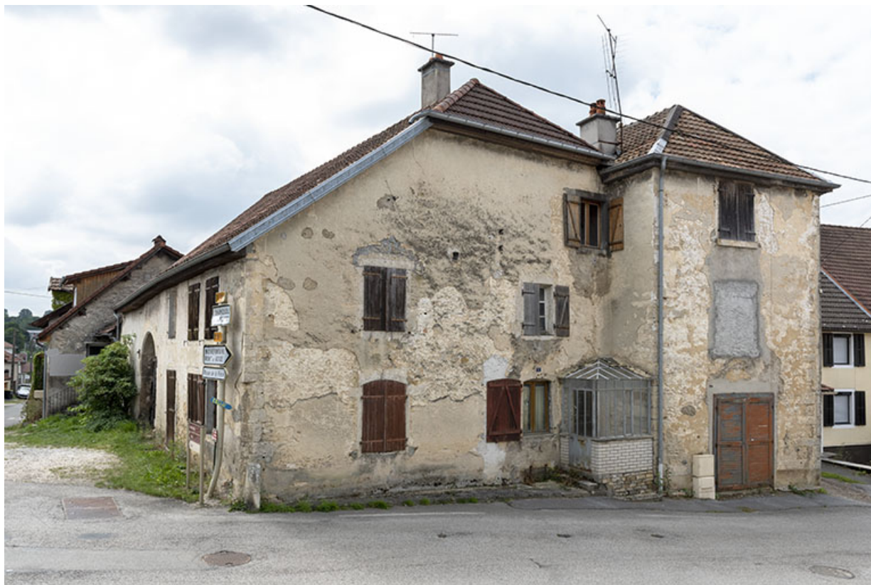
Façade sur la Grande Rue.
