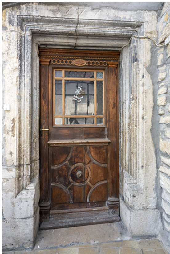
Façade sur la Grande Rue : baie dans la véranda, à encadrement mouluré et portant la date 1777. 25, Montécheroux, 1 Grande Rue
