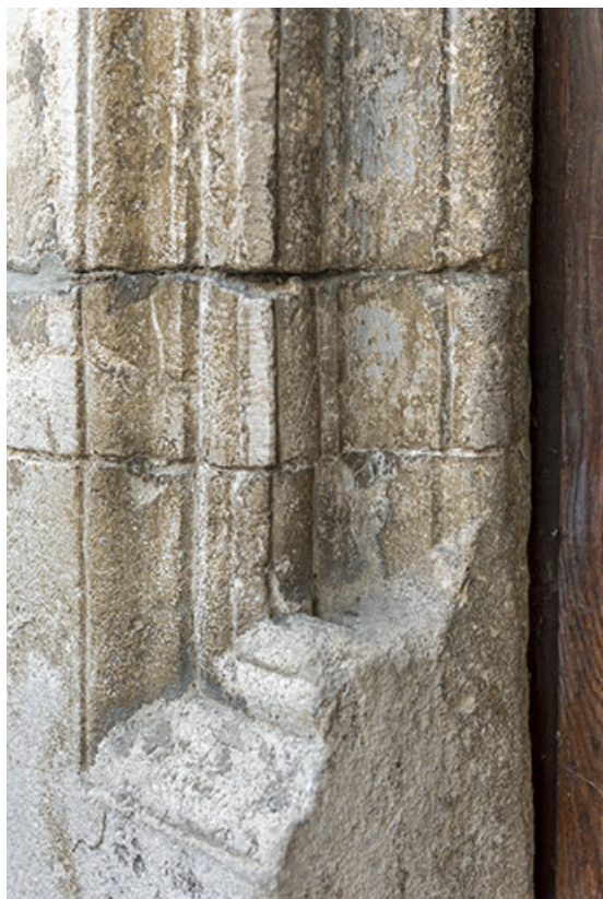
Façade sur la Grande Rue : détail de moulure de la baie dans la véranda. 25, Montécheroux, 1 Grande Rue
