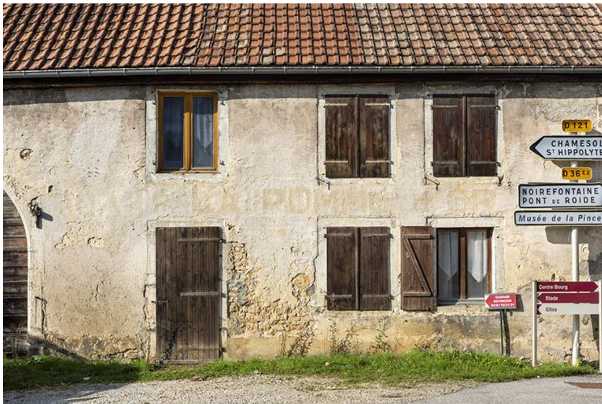
Façade sur la rue de Saint-Hippolyte : détail de l'inscription La Pomme d'Or. 25, Montécheroux, 1 Grande Rue
