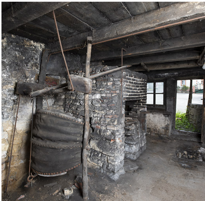
Forge : vue d'ensemble, depuis le fond de la première pièce. 25, Montécheroux
