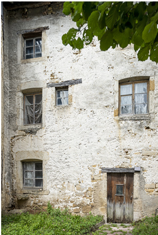
Maison : façade postérieure, de trois quarts.
