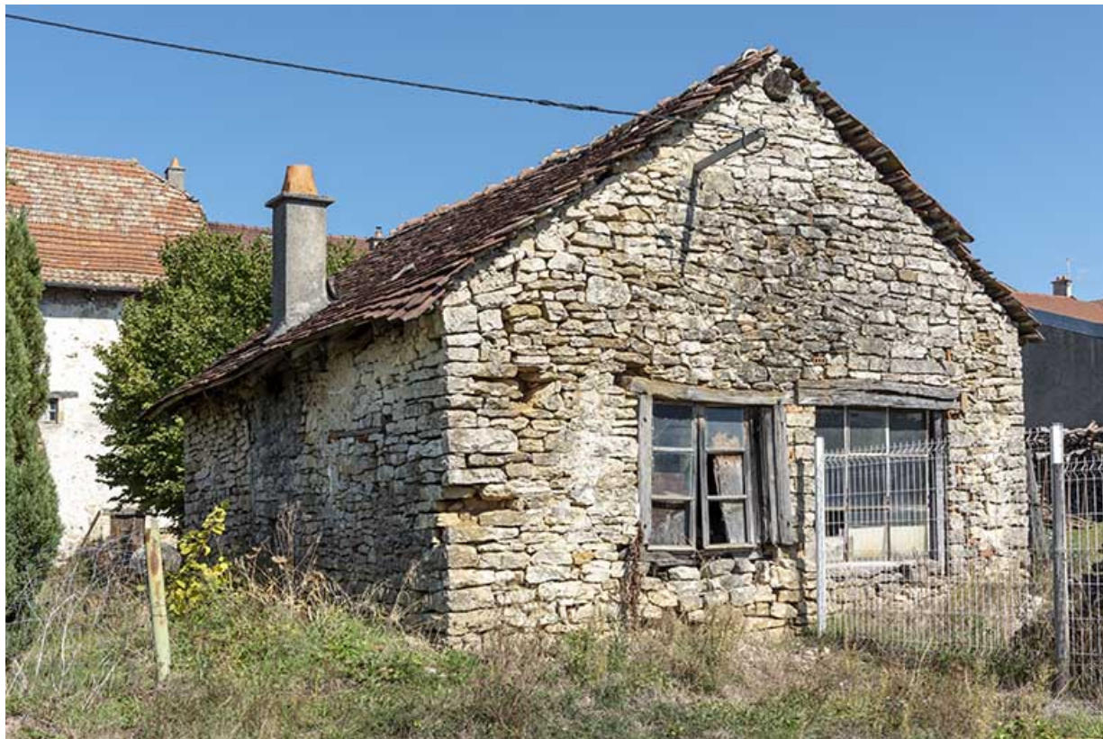
Forge : façade postérieure, de trois quarts gauche.
