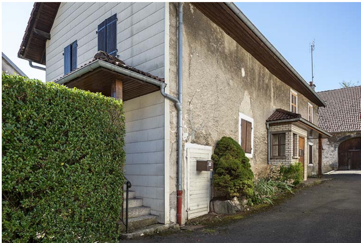
Maison de 1836 ayant abrité le café-restaurant : façades antérieure et latérale droite. 25, Montécheroux, 31-33 Grande Rue
