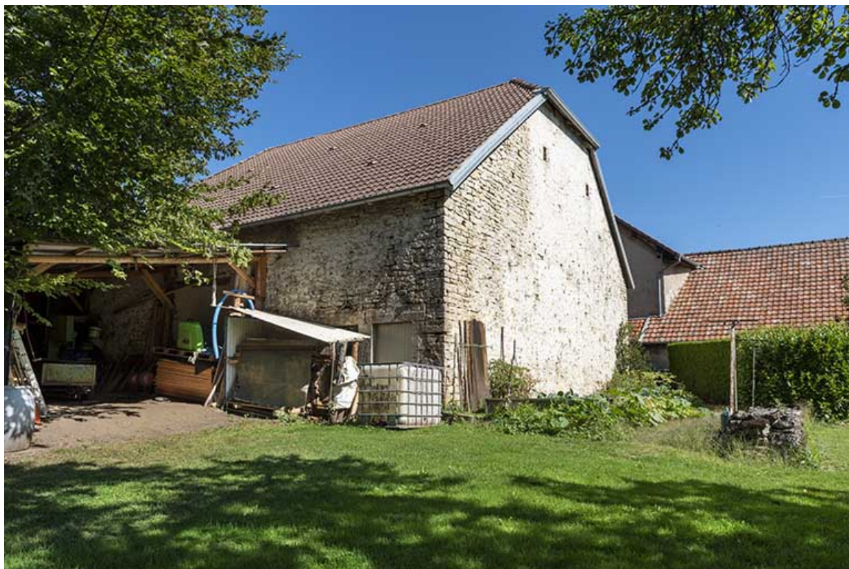
Grange et étable : façades postérieure et latérale gauche.
