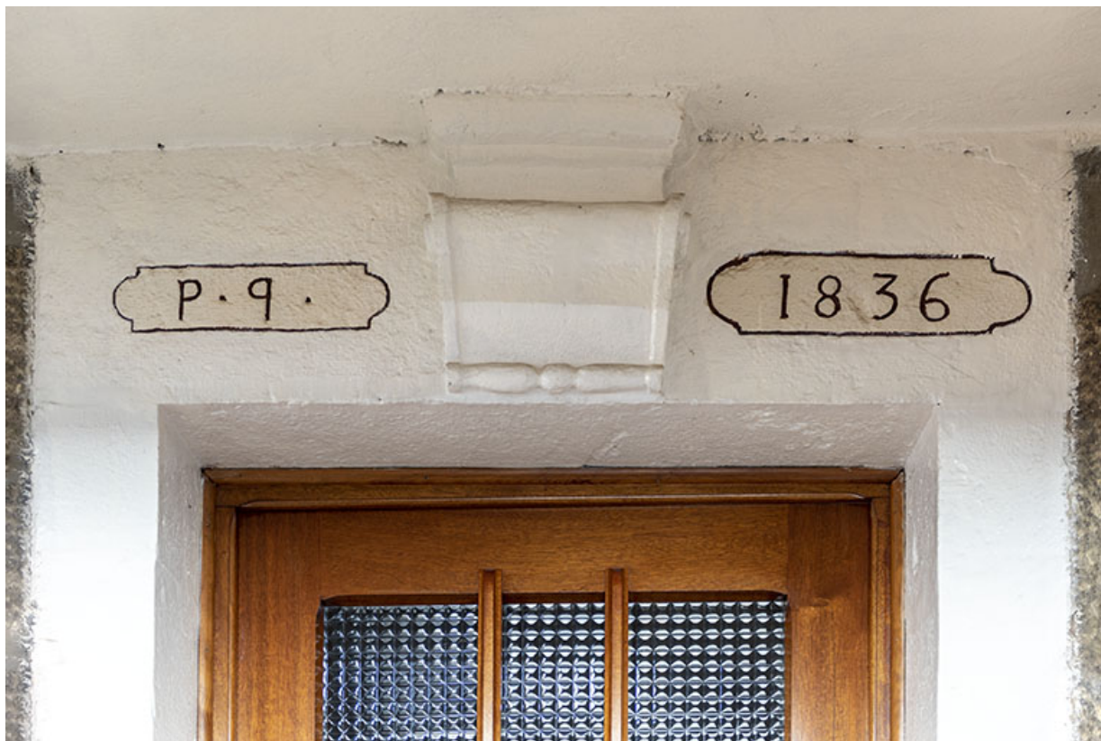
Maison de 1836 : linteau daté (sur la façade latérale droite).
