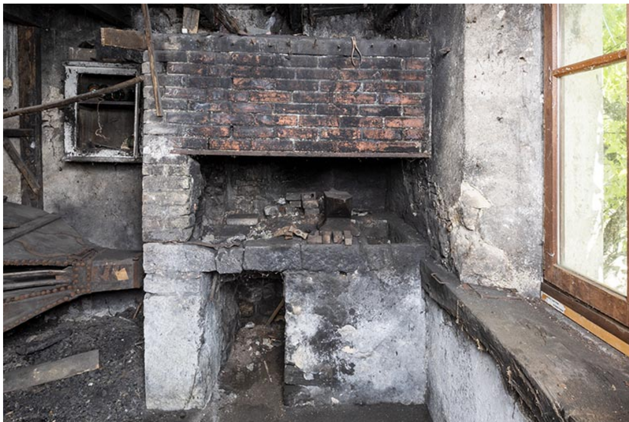
Forge : foyer et établi (à l'arrière de la fenêtre). 25, Montécheroux, 5-7 rue de la Planchette
