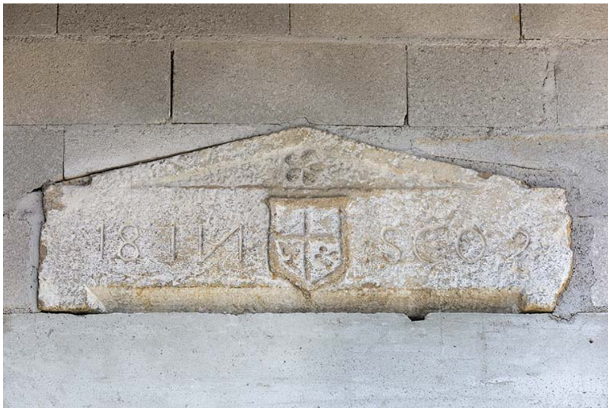
Grange, façade antérieure (partie occidentale) : linteau daté 1802 (remploi). 25, Montécheroux, 5-7 rue de la Planchette
