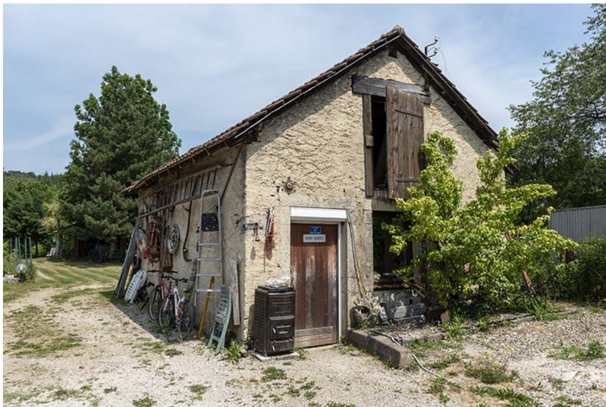
Forge : façade antérieure, de trois quarts gauche.
