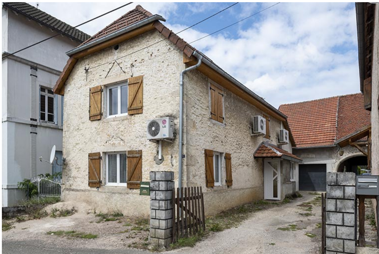
Logement ancien, de trois quarts depuis la rue. 25, Montécheroux, 5-7 rue de la Planchette
