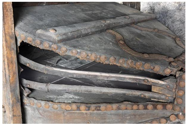
Forge : côté du soufflet en cuir, en mauvais état. 25, Montécheroux, 5-7 rue de la Planchette
