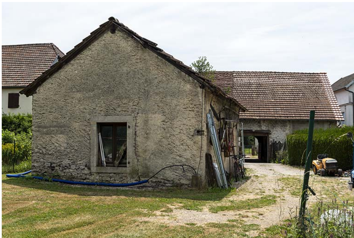
Forge : façade postérieure, de trois quarts droite.
