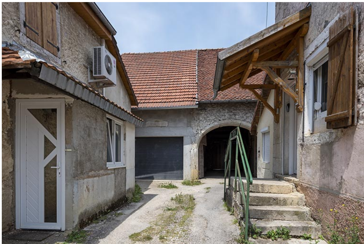
Grange, depuis l'entrée de la cour.
