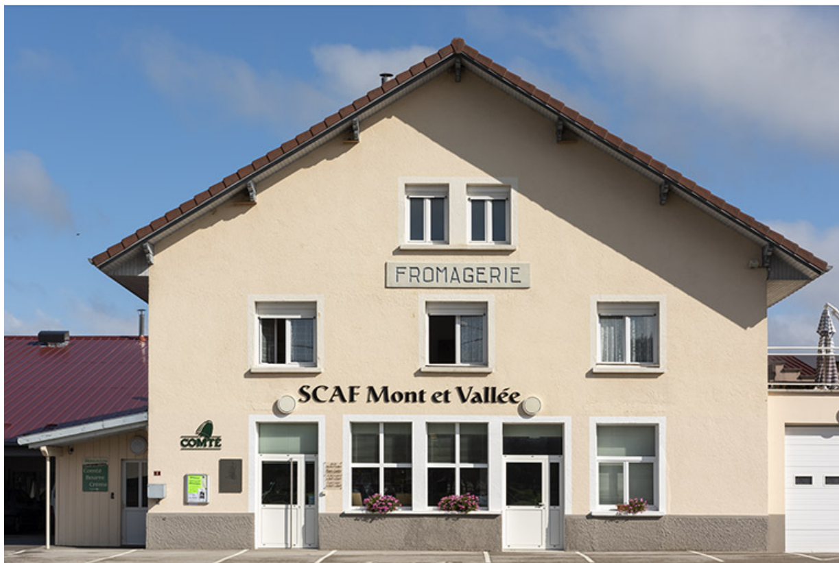
Bâtiment de 1820 : façade antérieure.
