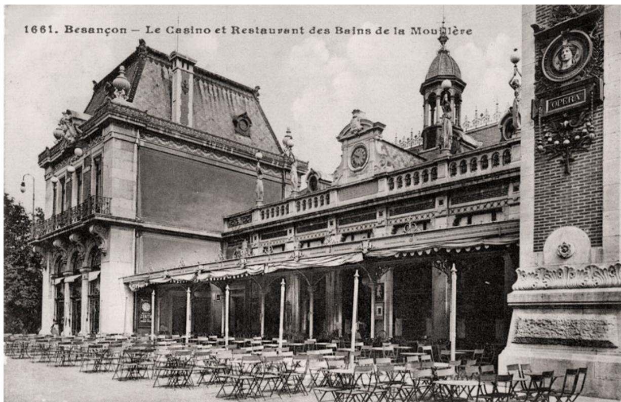
Façade principale, casino-restaurant (vers 1900). 25, Besançon, 1 esplanade Jean-Luc Lagarce
