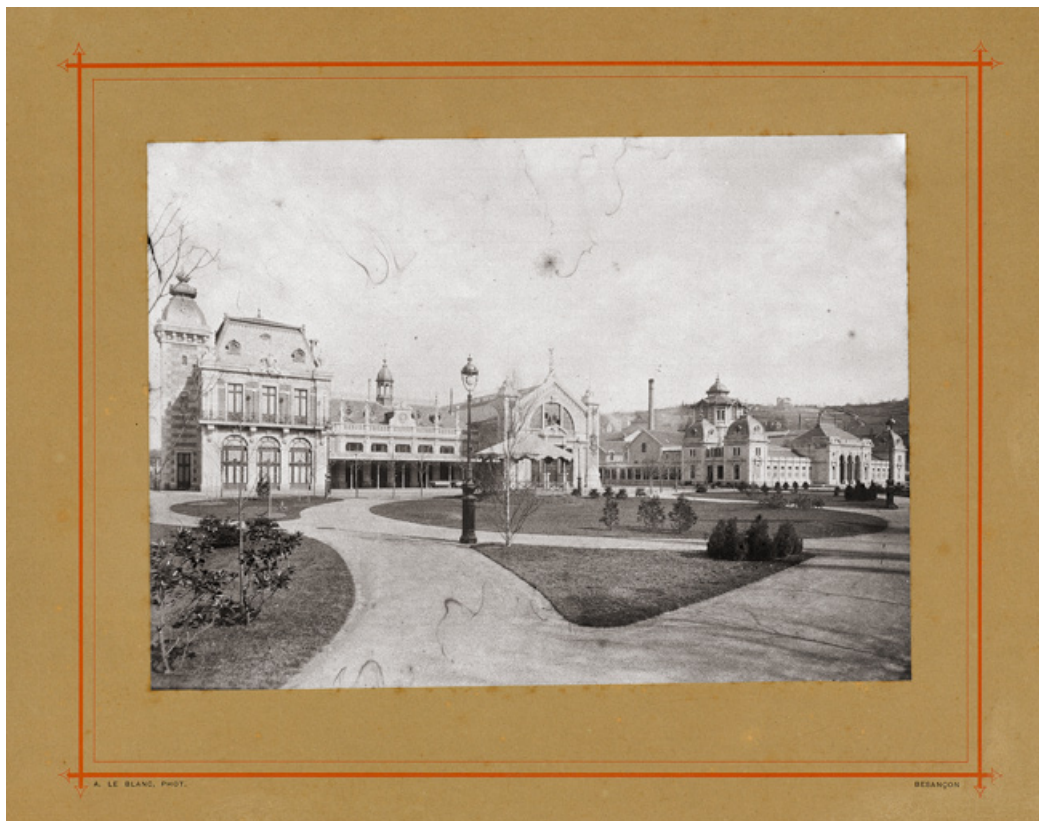
Vue d'ensemble, avec le casino-restaurant à gauche (1893).
