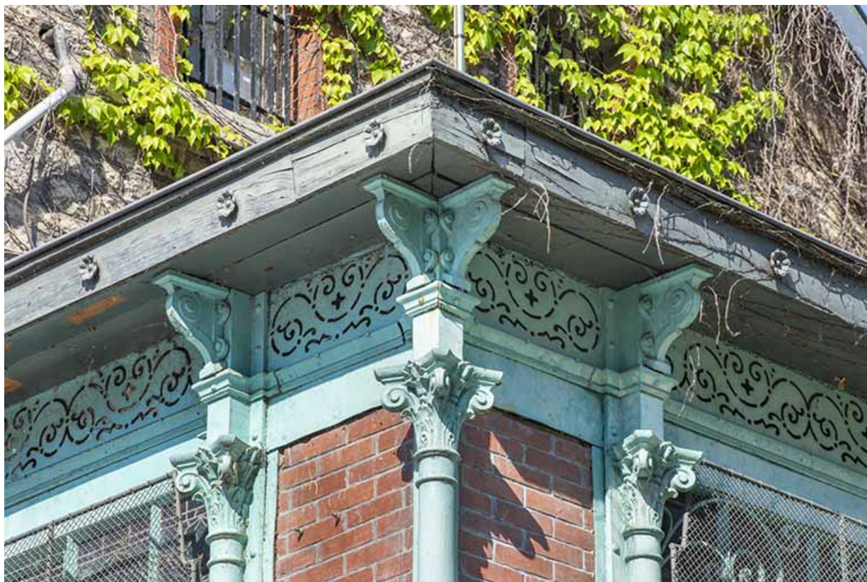
Jardin d'hiver (salle de bridge), détail.
