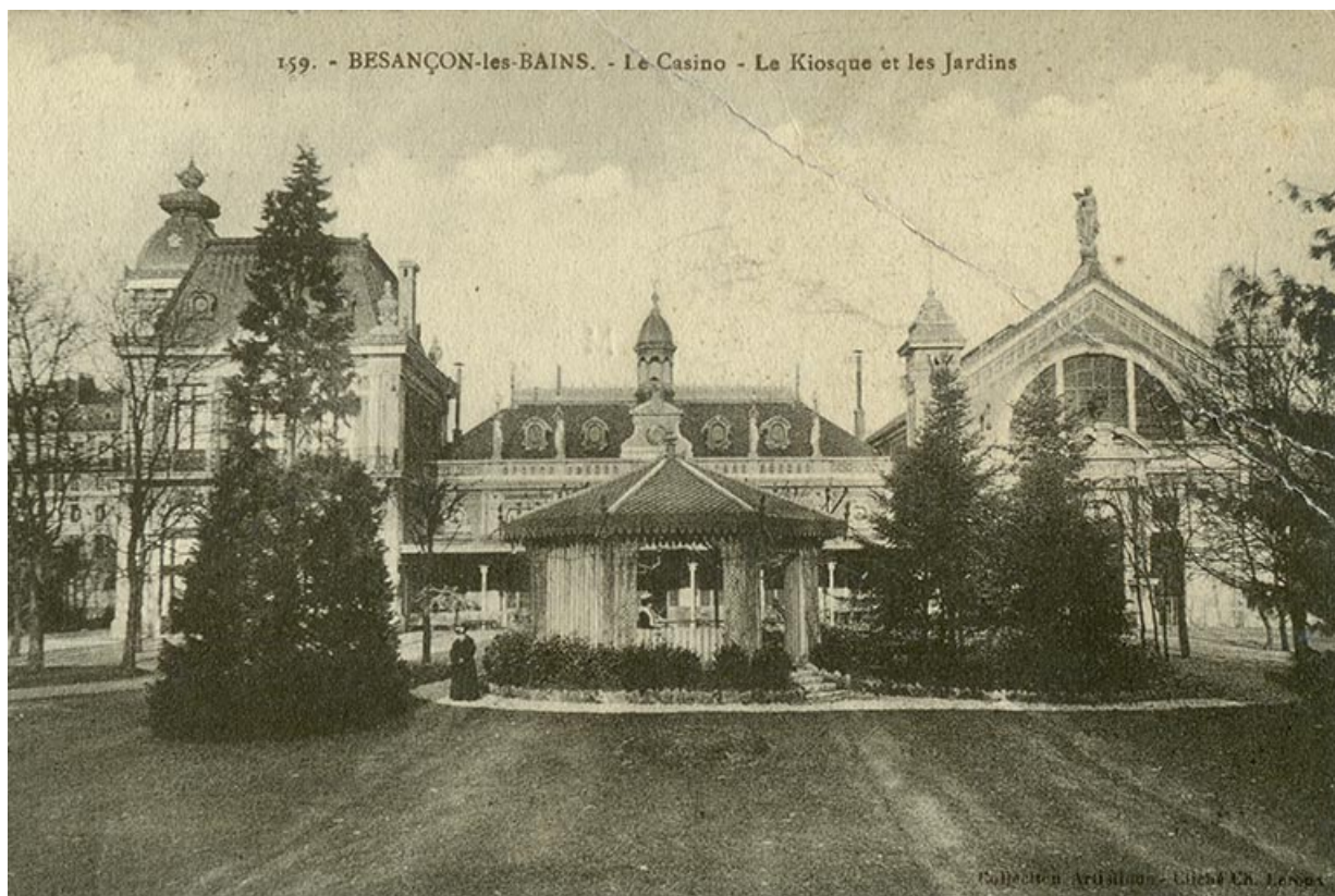
Façade principale, casino-restaurant (à gauche et au centre) et salle des fêtes (à droite). 25, Besançon, 1 esplanade Jean-Luc Lagarce
