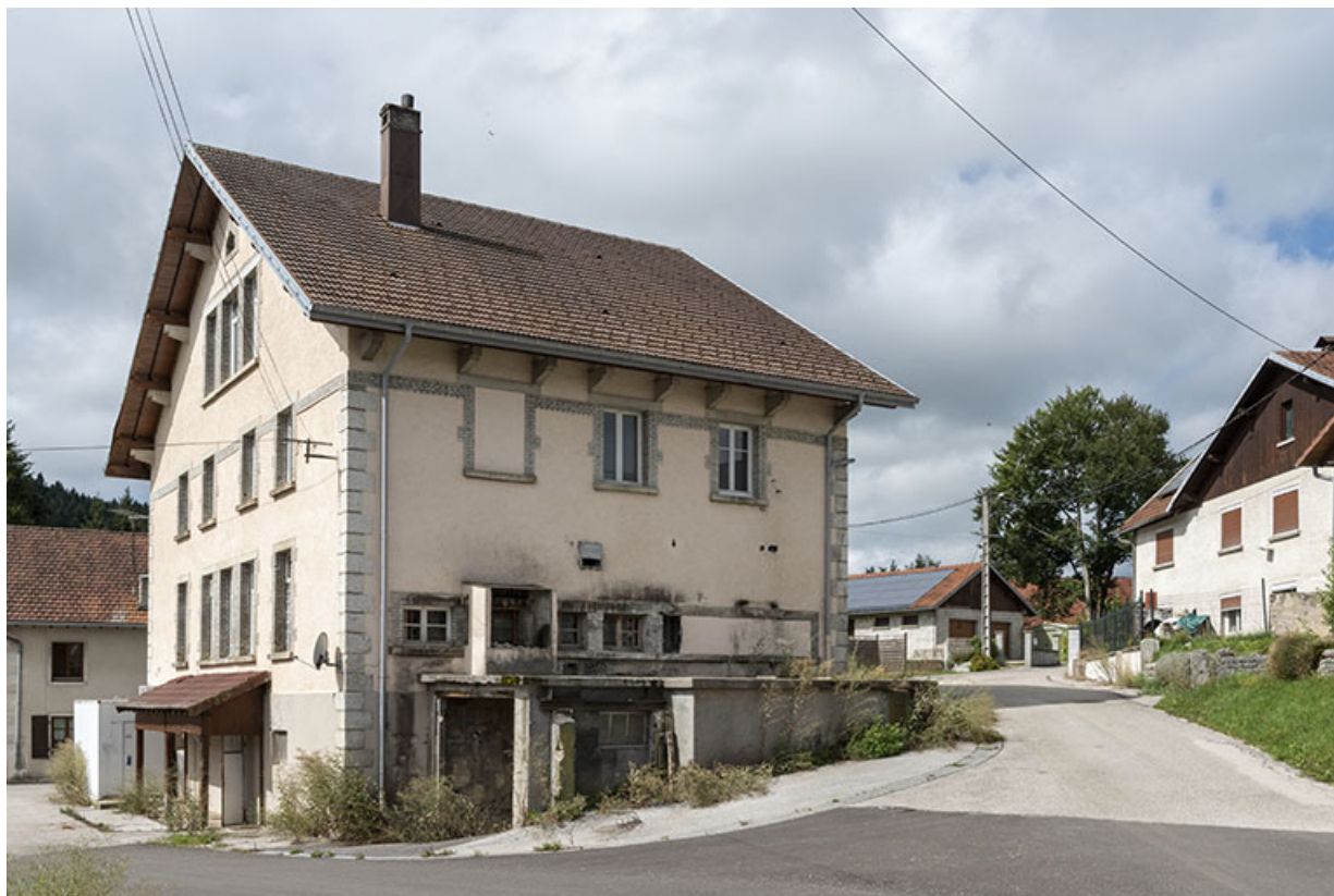
Façades postérieure et latérale gauche.
