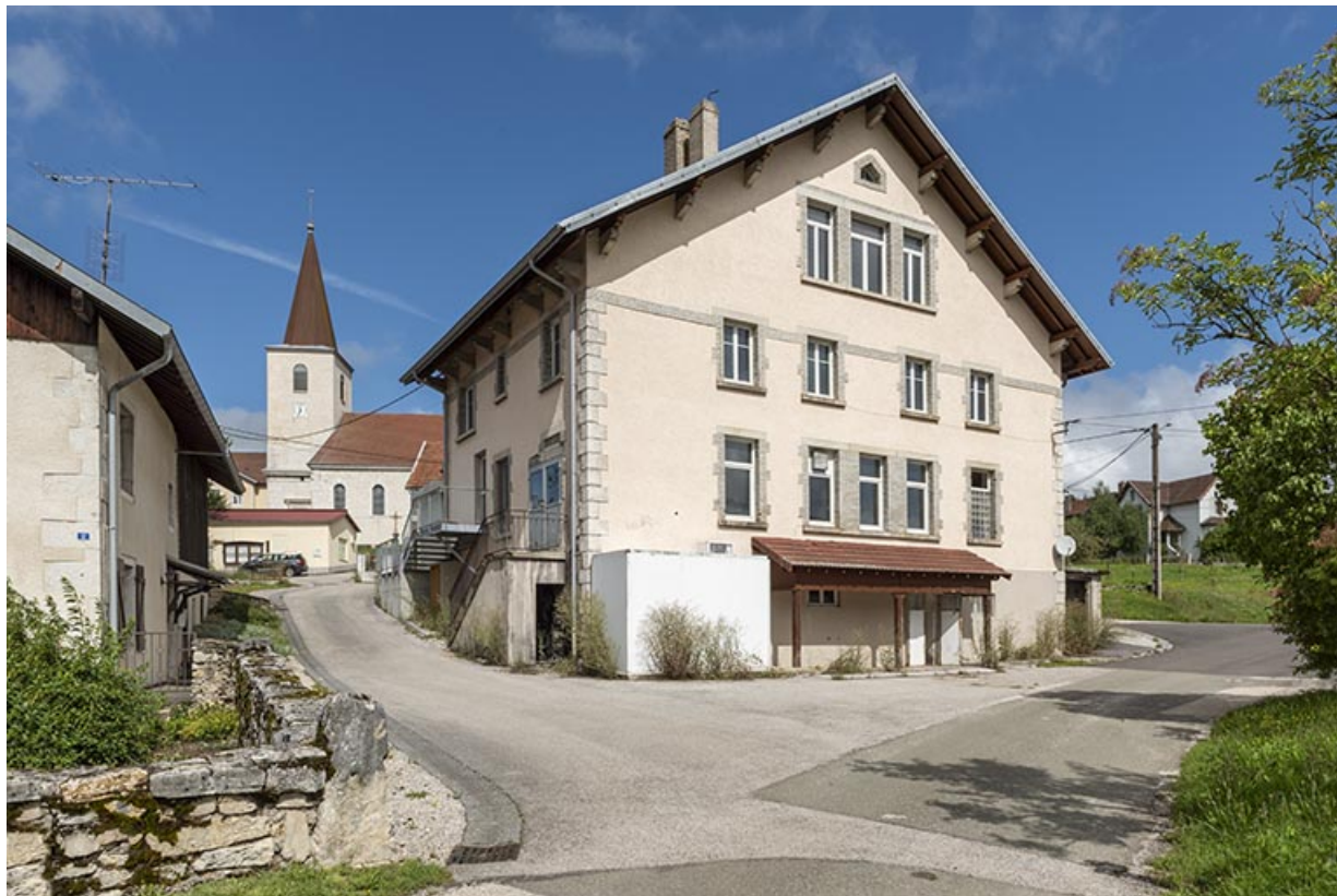
Façade postérieure, de trois quarts gauche. 25, Indevillers place Gaston Bourquard
