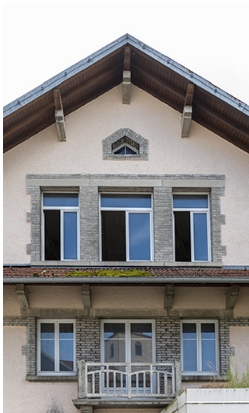
Façade antérieure : travées centrales en partie haute.
