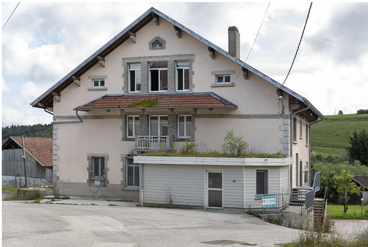
Façade antérieure, de trois quarts droite. 25, Indevillers place Gaston Bourquard
