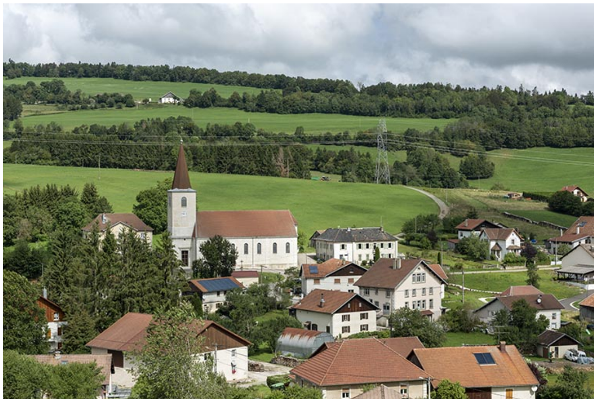
Vue d'ensemble du village et de la fromagerie, depuis le sud.
