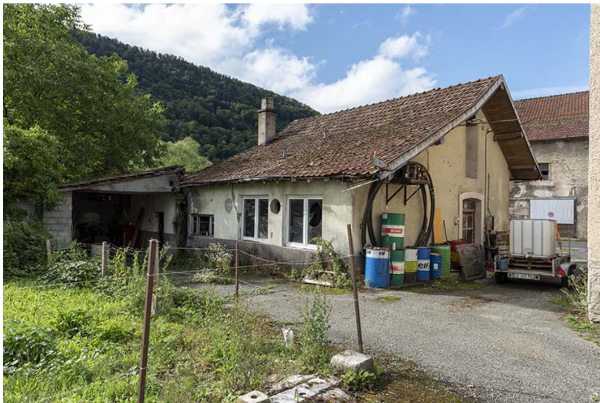
Façades antérieure et latérale gauche.
