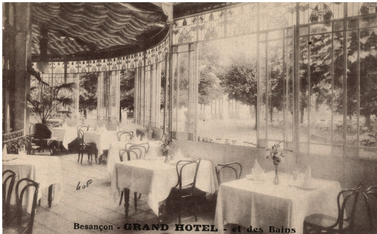
Salle de restaurant, marquise vue de l'intérieur (vers 1910-1920). 25, Besançon, 2 avenue Carnot
