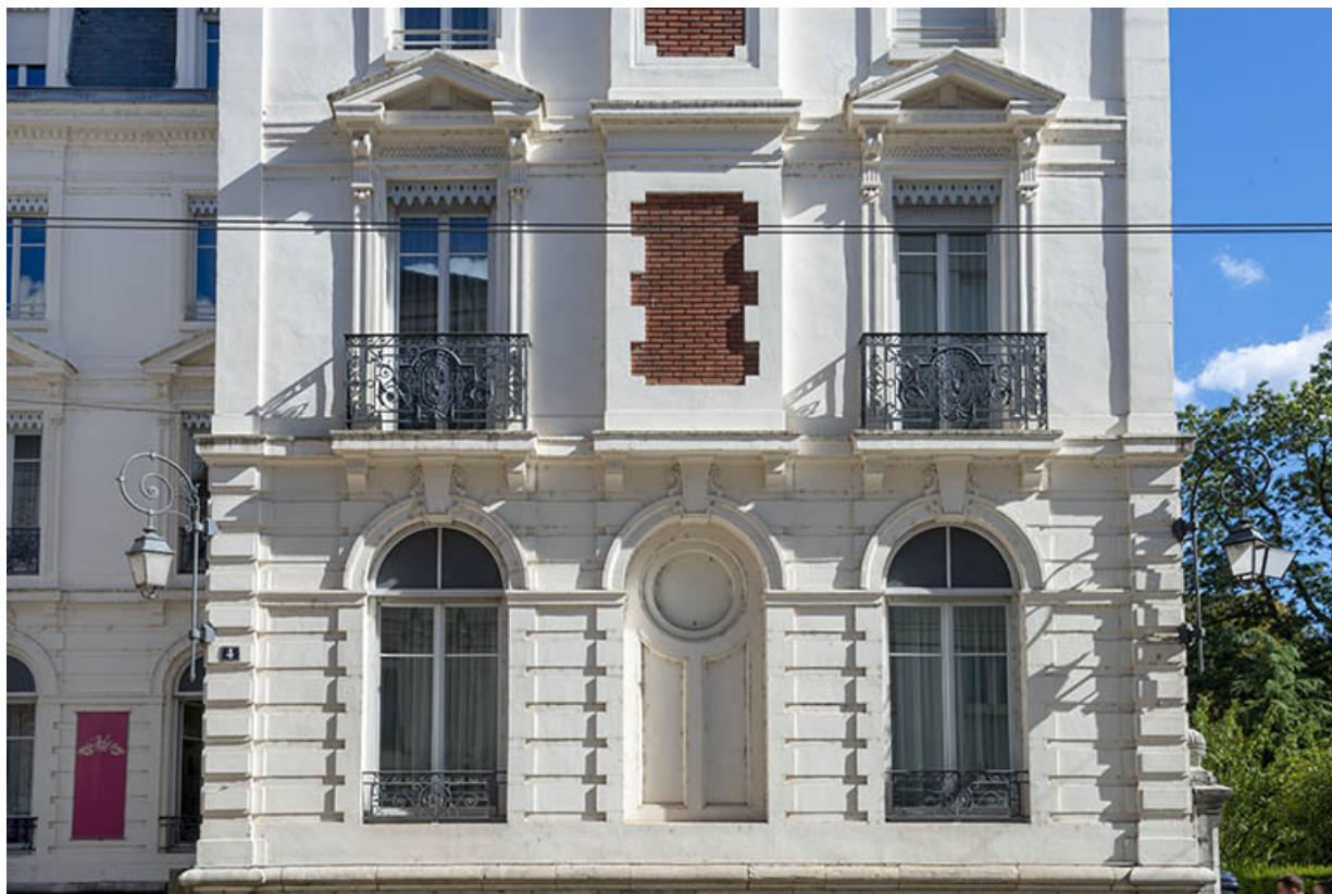
Façade sur l'avenue Carnot, avant-corps de droite, détail du rez-de-chaussée surélevé. 25, Besançon, 2 avenue Carnot
