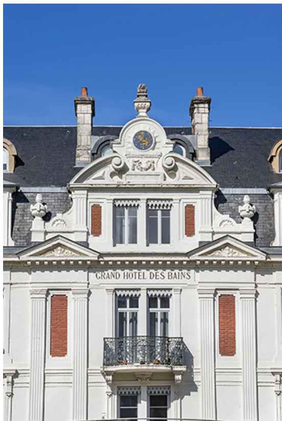
Façade sur le jardin, travées centrales, détail.
