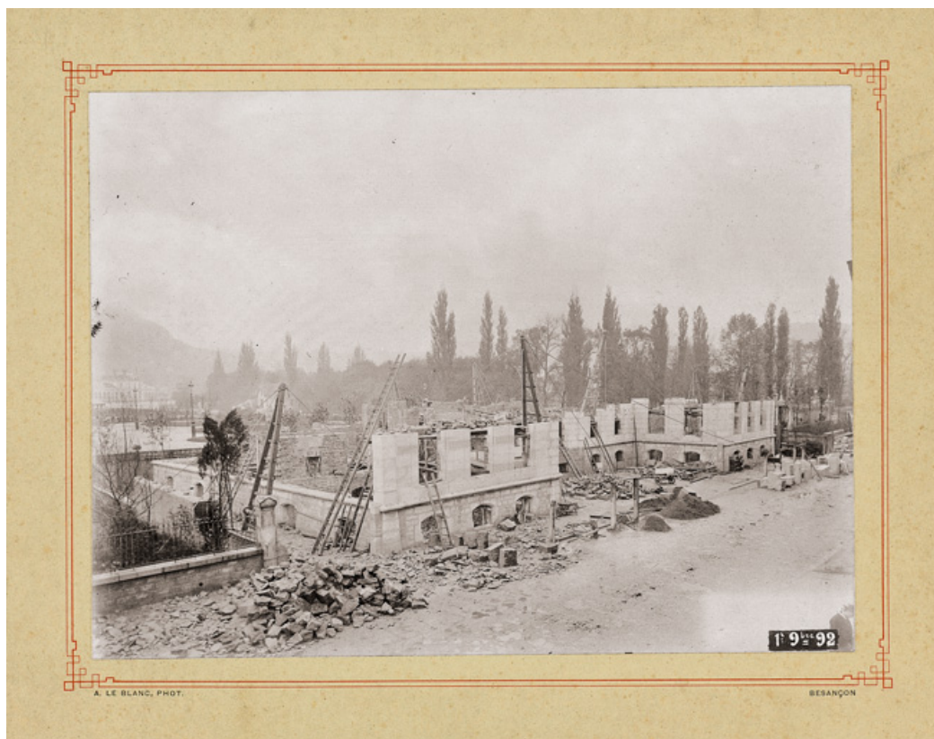
Chantier de construction (1er novembre 1892).
