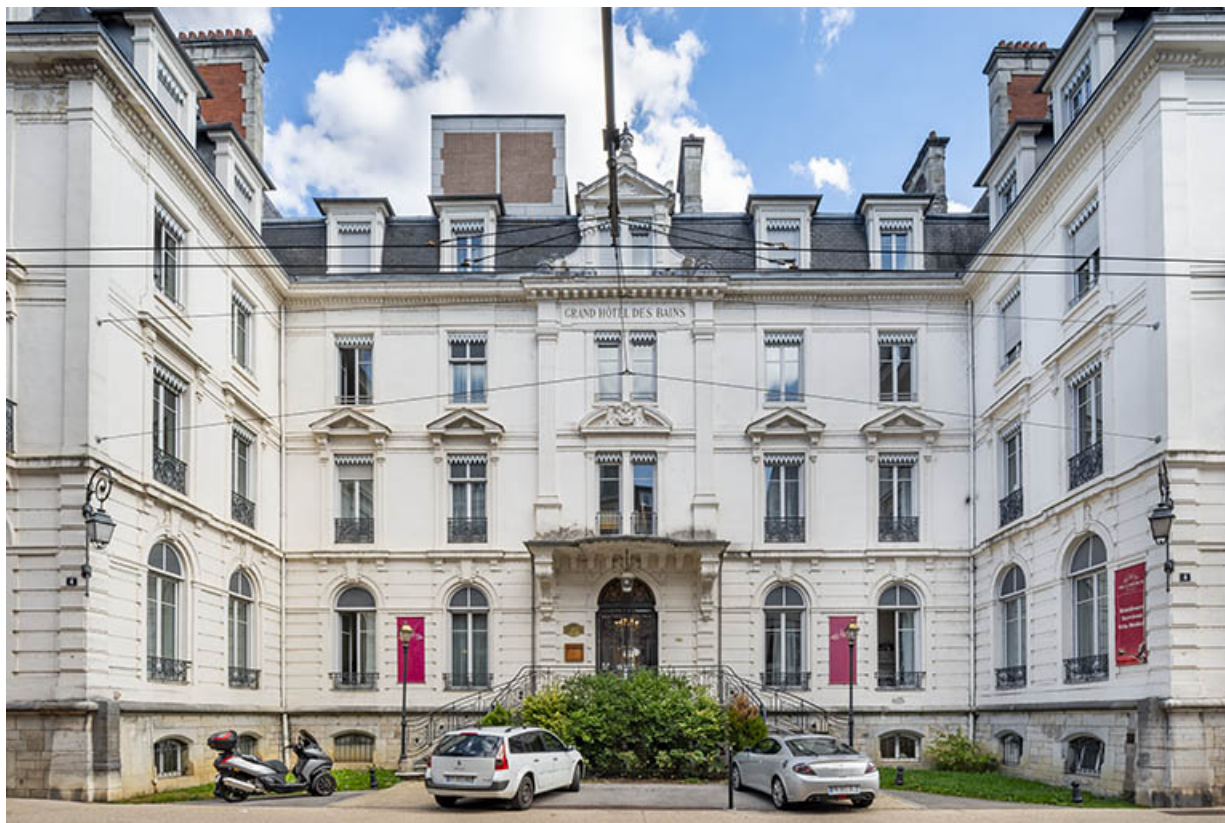
Façade sur l'avenue Carnot.
