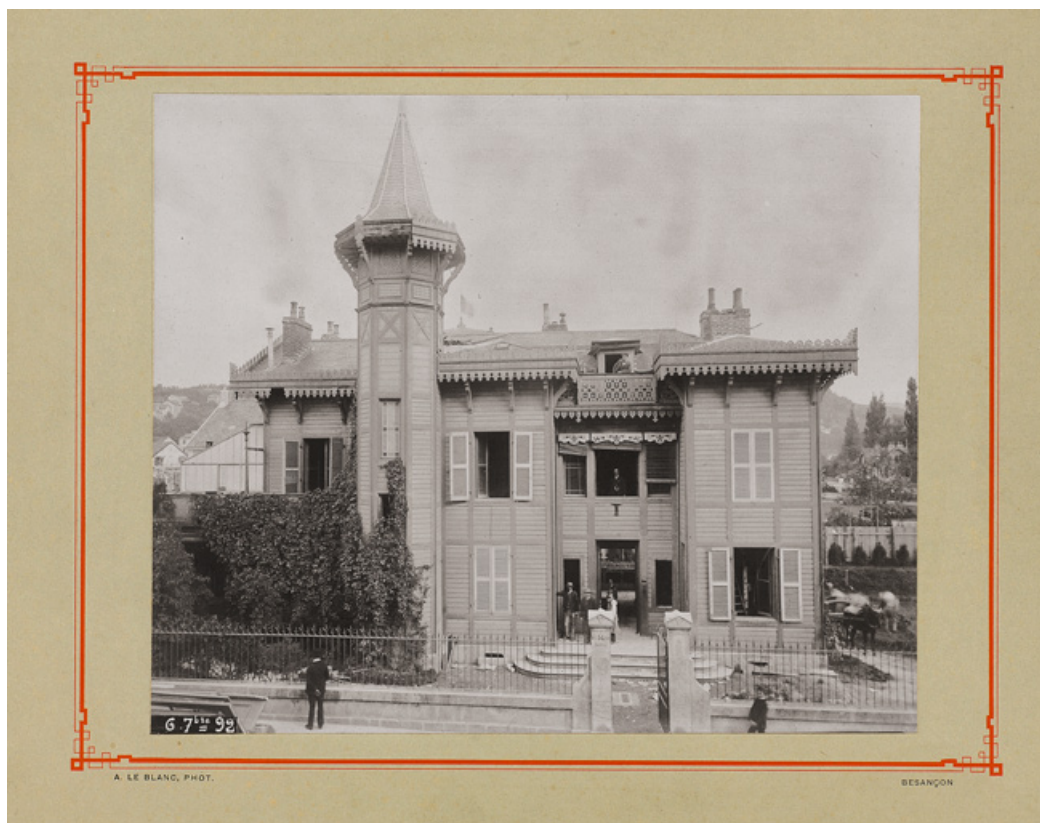
Maison Vermont, sur le terrain de laquelle est construit l'hôtel, au début des travaux (6 septembre 1892). 25, Besançon, 2 avenue Carnot
