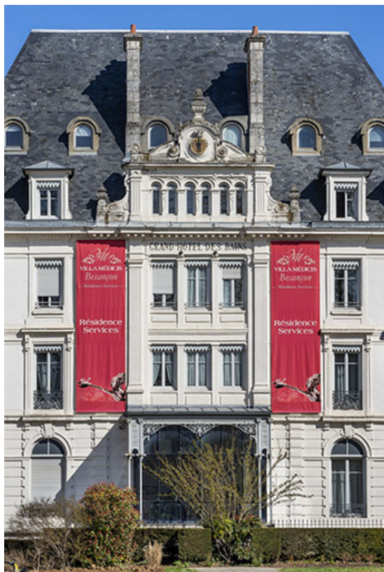
Façade sur l'avenue Édouard Droz, travées centrales. 25, Besançon, 2 avenue Carnot
