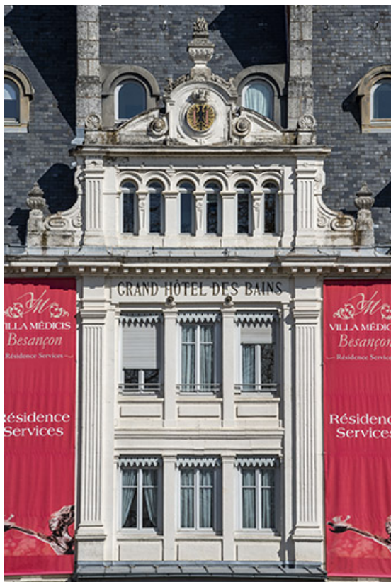
Façade sur l'avenue Édouard Droz, travées centrales, détail. 25, Besançon, 2 avenue Carnot
