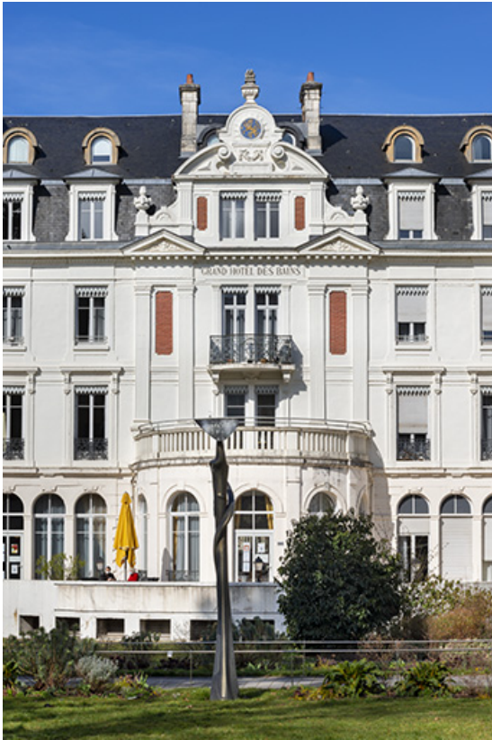
Façade sur le jardin, travées centrales.
