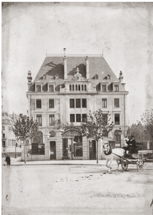
Façade sud (vers 1893). 25, Besançon, 2 avenue Carnot
