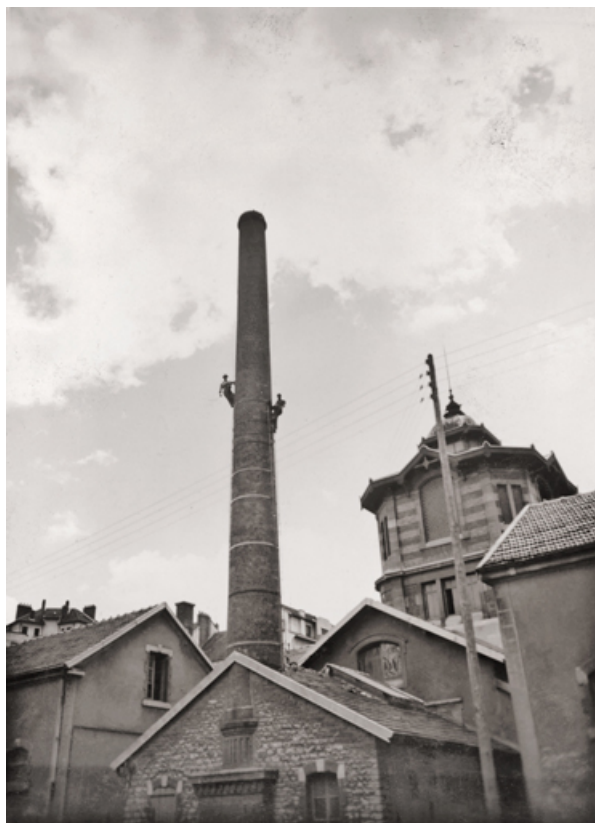
Cheminée de la chaufferie (vers 1950). 25, Besançon, 3 avenue Édouard Droz
