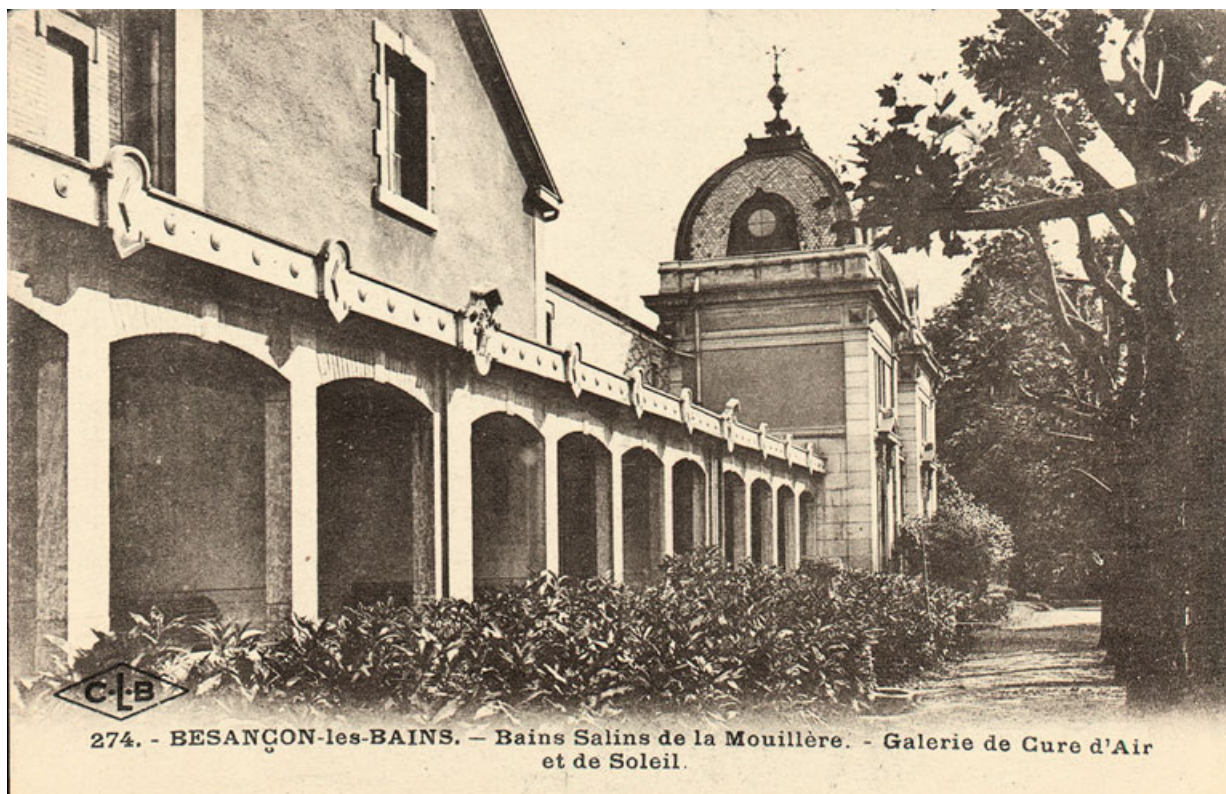
Façade latérale (vers 1930).
