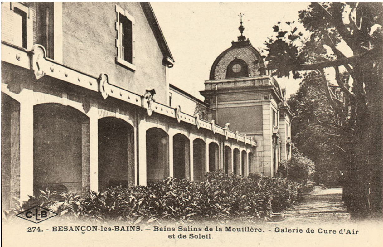
Façade latérale (vers 1930).
