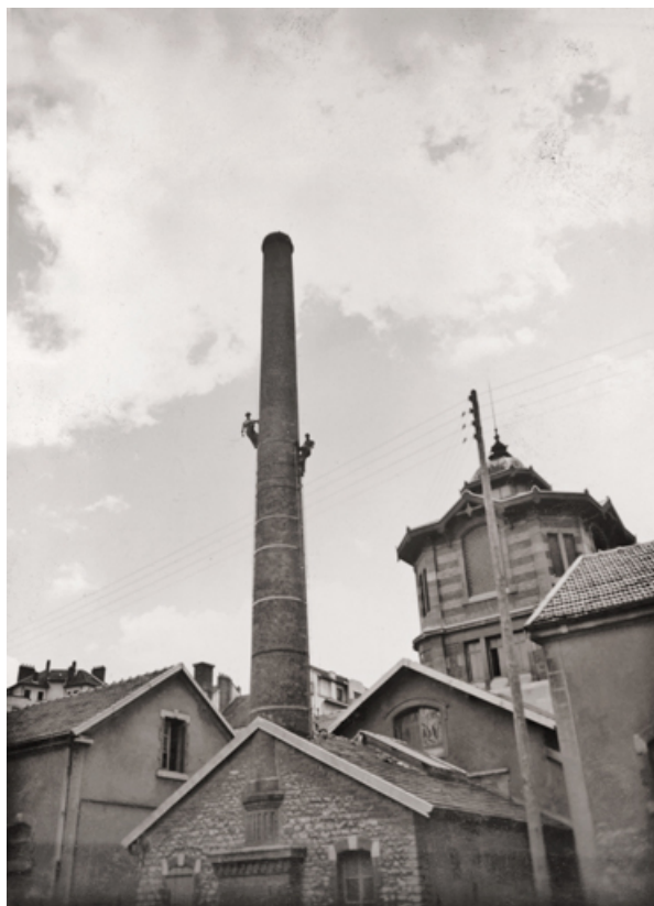
Cheminée de la chaufferie (vers 1950). 25, Besançon, 3 avenue Édouard Droz
