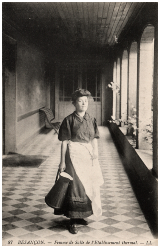
Façade latérale, galerie (vers 1920). 25, Besançon, 3 avenue Édouard Droz
