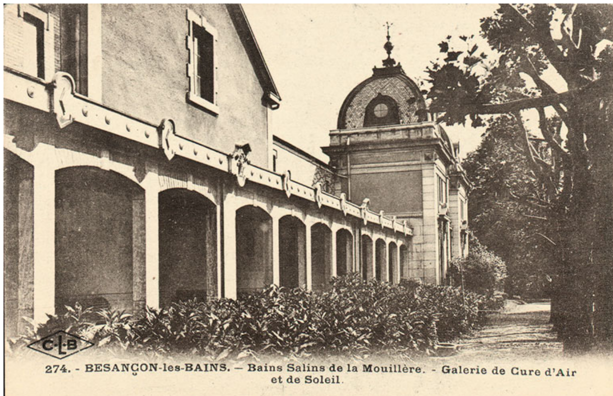
Façade latérale (vers 1930).
