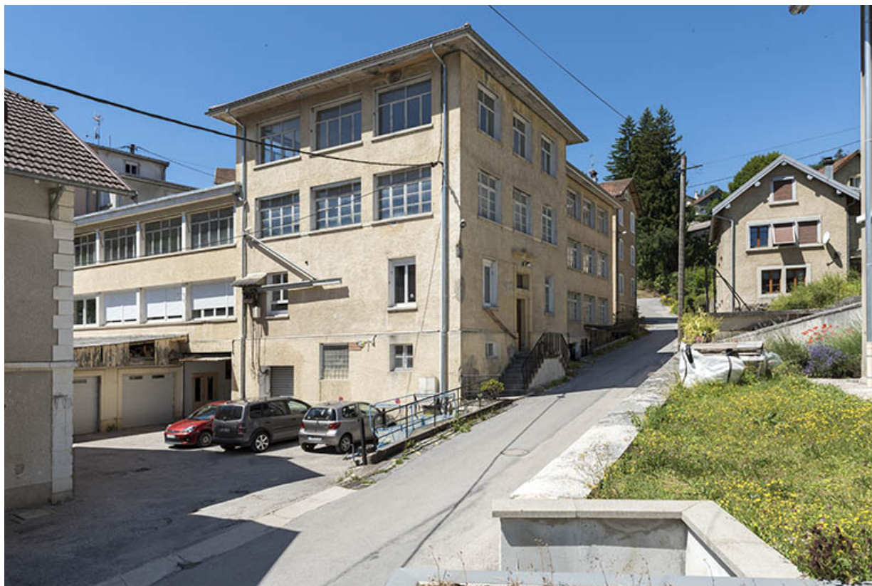
Usine n° 4 (ancienne usine Marius Anguenot reprise par Cupillard), au 3 rue de la Perrière à Villers-le-Lac. 25, Villers-le-Lac
