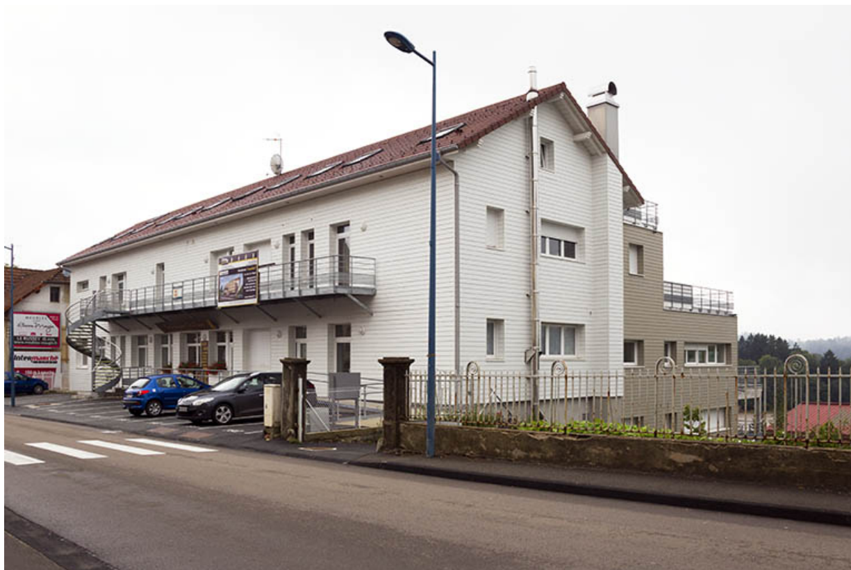
Usine n° 2 (Ets Joseph Jeambrun), au 19 rue de Saint-Hippolyte à Maîche. 25, Maîche, 19, 21, 26 rue de Saint-Hippolyte
