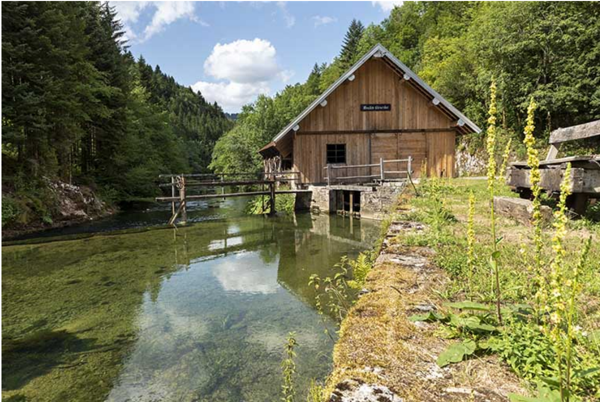
Scierie, depuis l'amont (sud) : vue rapprochée. 25, Plaimbois-du-Miroir, lieudit : le Moulin Girardot
