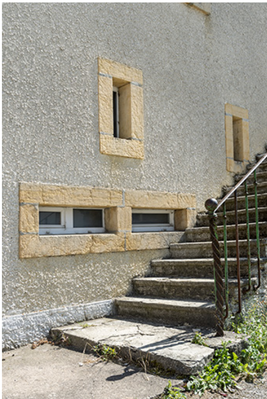
Baies fromagères horizontales sur la façade nord.
