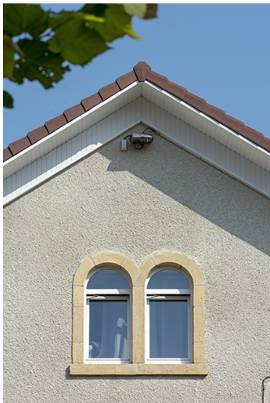
Façade sud : baie géminée dans le pignon.
