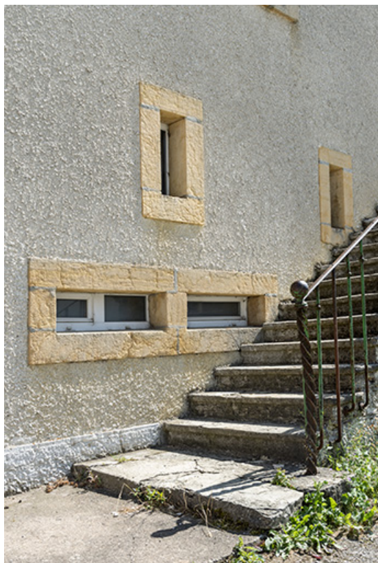
Baies fromagères horizontales sur la façade nord.
