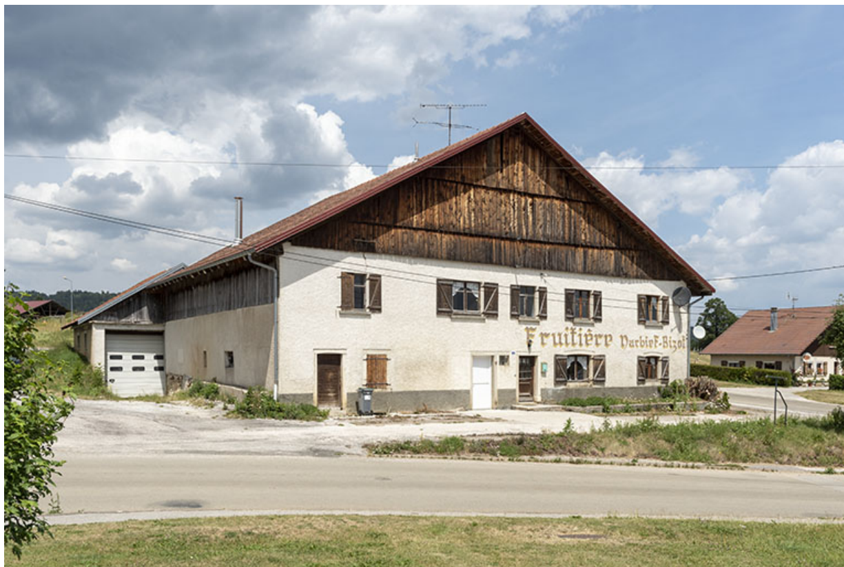
Façades antérieure et latérale gauche.
