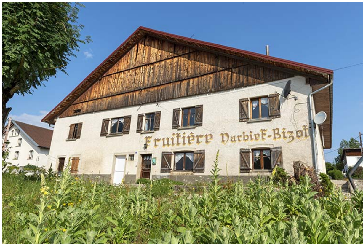
Façade antérieure, vue en contre-plongée.
