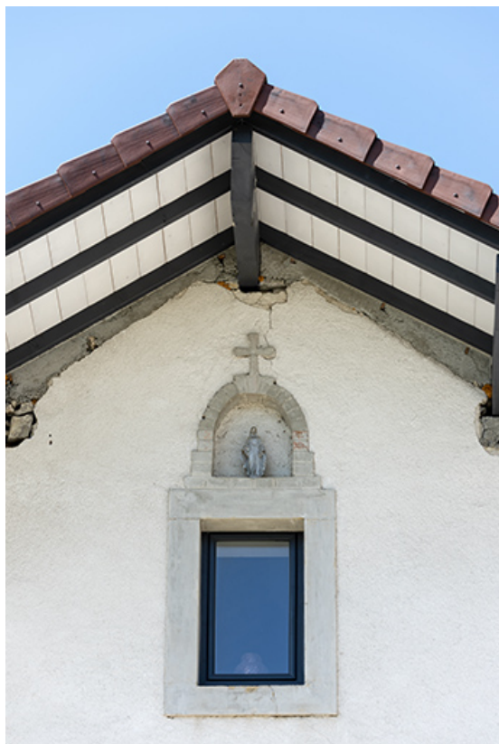
Fenêtre et niche abritant une statue de la Vierge, sous le faitage.
