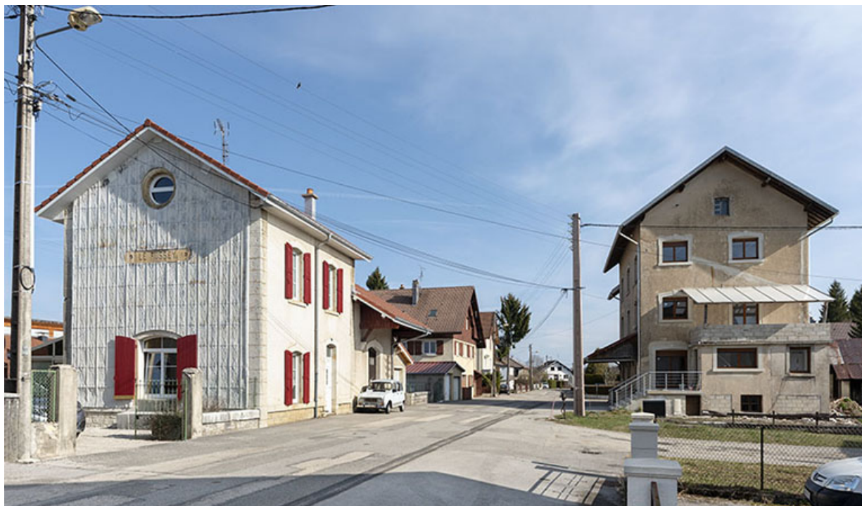
Vue d'ensemble depuis le sud, avec l'ancienne gare à gauche.
