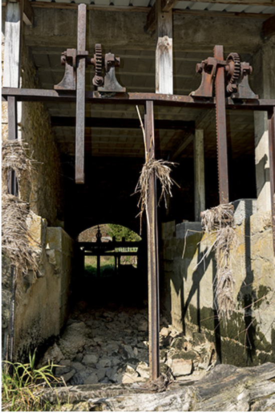
Moulin : vestiges des vannes de prise d'eau gauche. 25, Les Combes, 4 rue du Moulin, lieudit : Remonot
