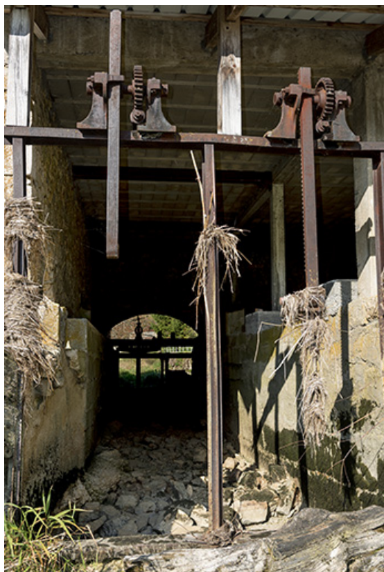
Moulin : vestiges des vannes de prise d'eau gauche. 25, Les Combes, 4 rue du Moulin, lieudit : Remonot
