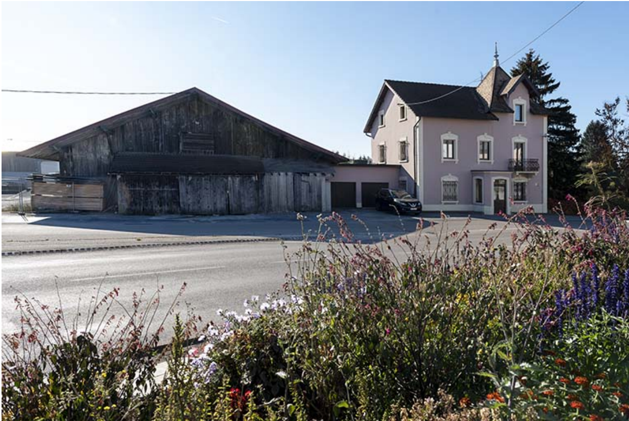
Atelier de 1919 et deuxième maison : façade antérieure (nord).
