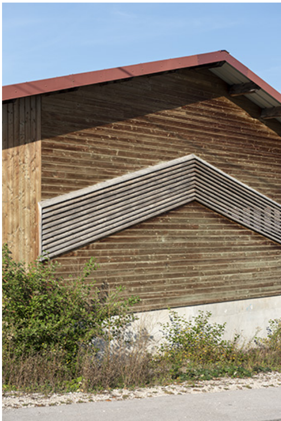
Magasin industriel : essentage de planches sur le mur est.
