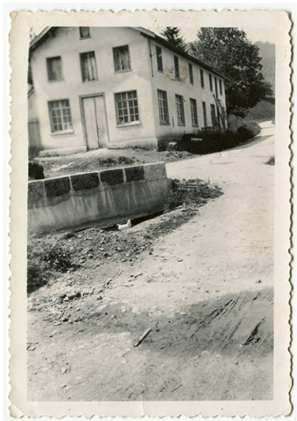
[La "caisserie"], milieu 20e siècle. 25, Les Fins, lieudit : les Combes
