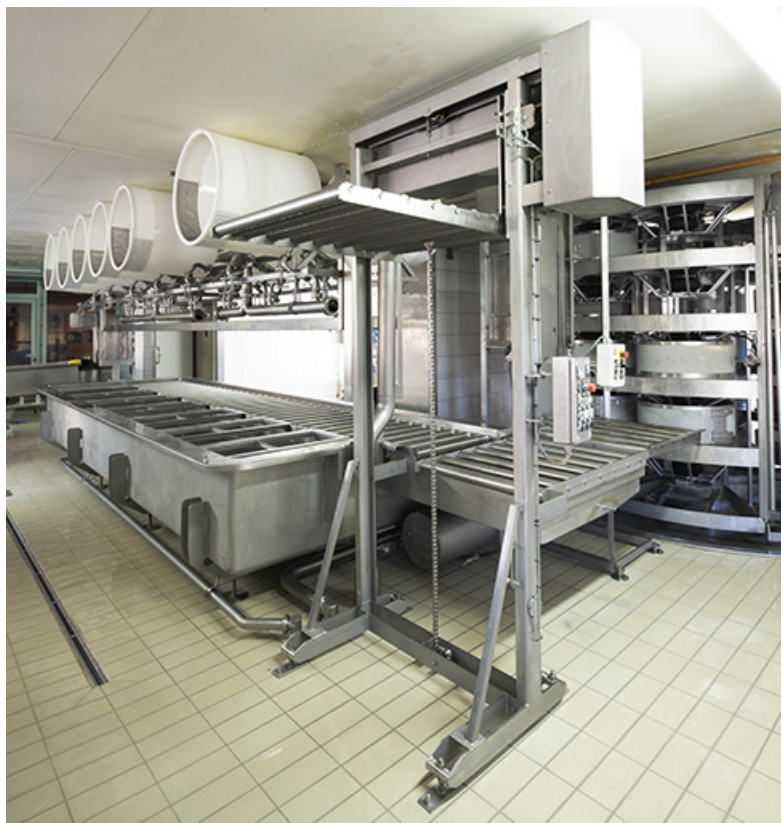
Atelier de fabrication: installations de soutirage et de pressage.
