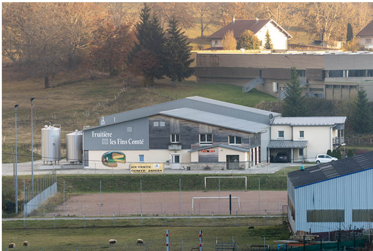
Vue plongeante sur la façade antérieure, depuis le nord.
