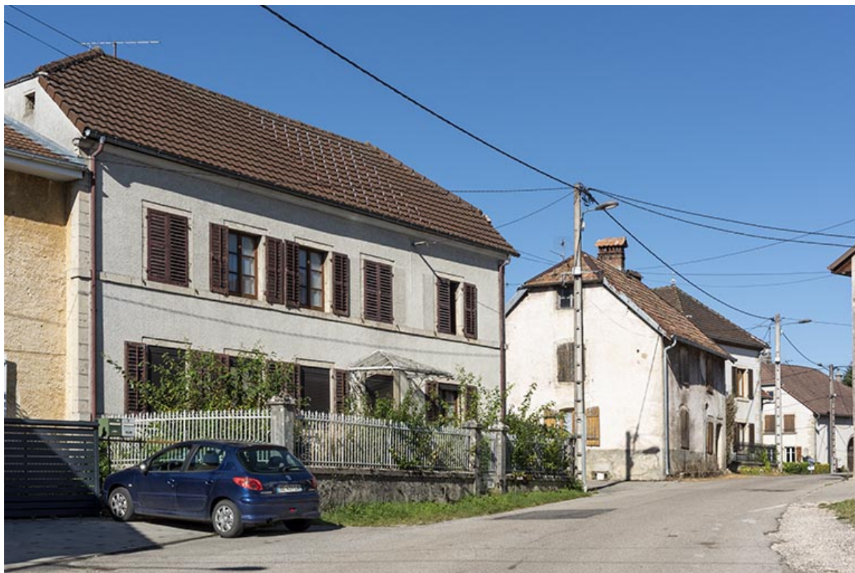
Vue d'ensemble, depuis l'est. Maison de 1859 (n° 45) à gauche, maisons de Nicolas Gueutal (n° 49 et 53) à droite. 25, Montécheroux, 45-47 Grande Rue
