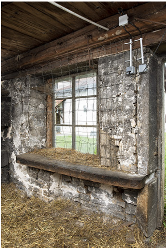
Forge nord : fenêtre et établi.
