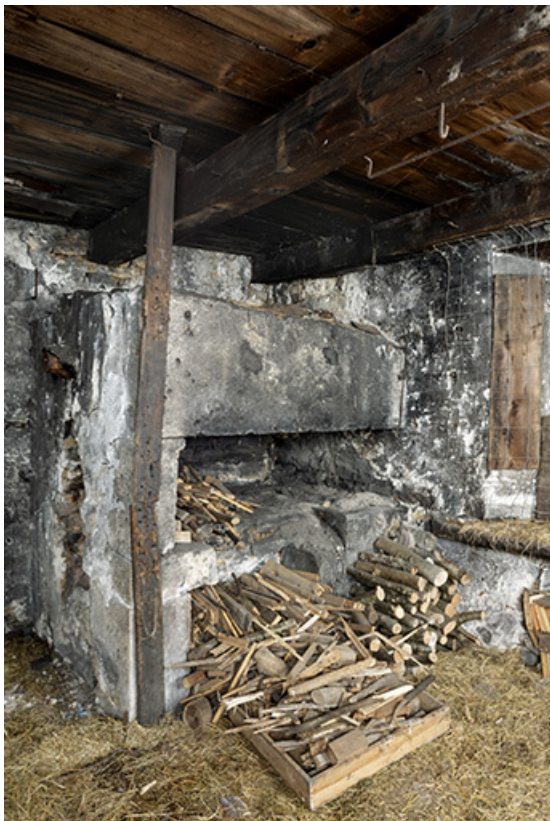
Forge sud : 1er foyer.
