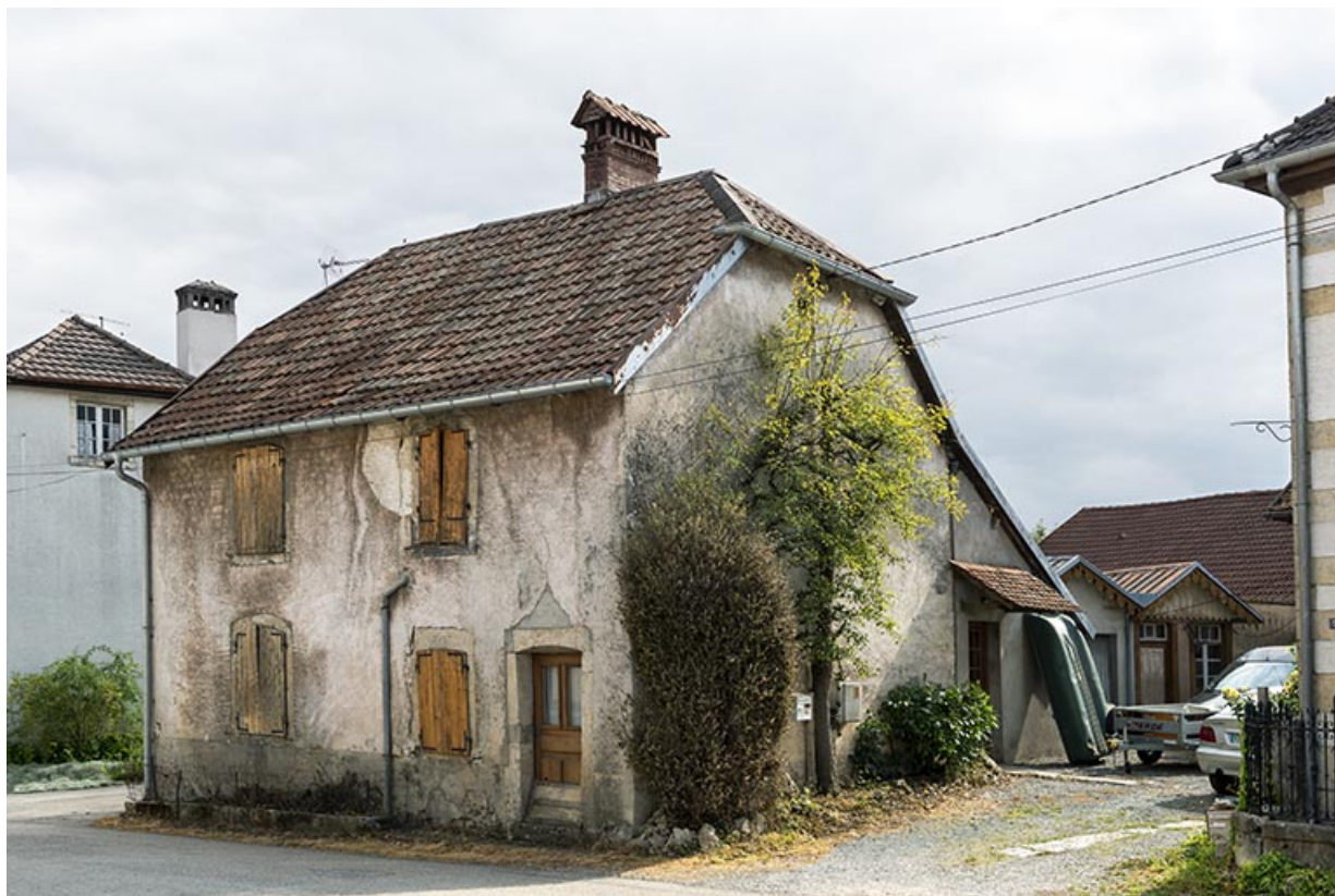
Maison de 1786, de trois quarts droite. 25, Montécheroux, 49-53 Grande Rue
