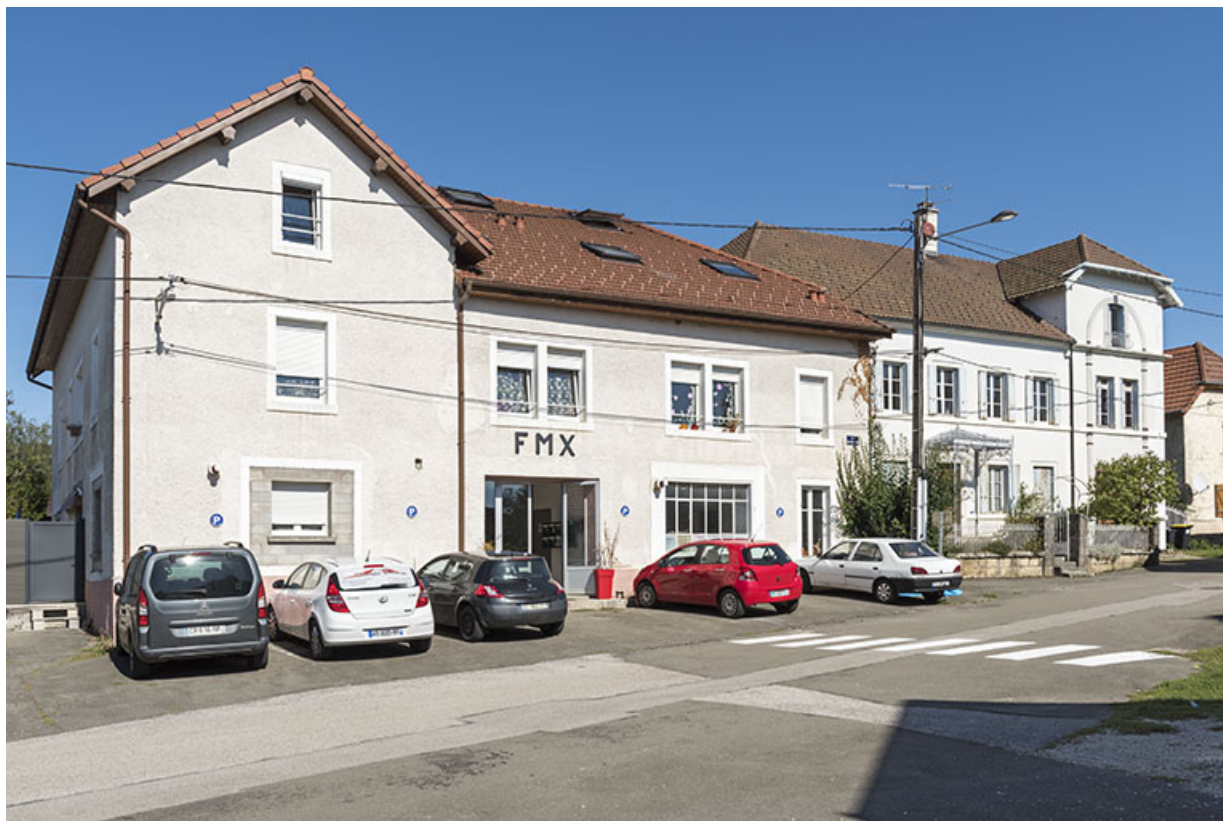
Usine (bâtiments d'origine), de trois quart gauche. Le logement est visible à droite.
