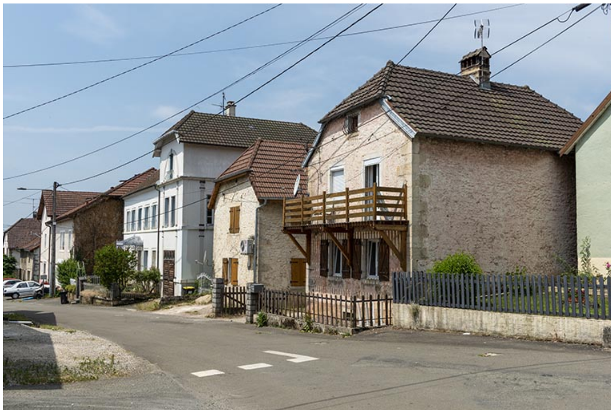
La rue de la Planchette, depuis le nord-est. L'usine et le logement Ducommun et Marti sont visibles à gauche, les deux logements Schom à droite.
