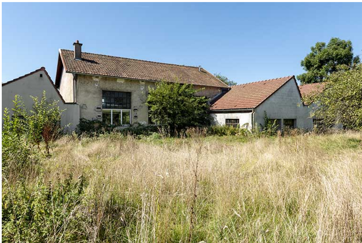
Usine : façade postérieure des ateliers (depuis l'est).
