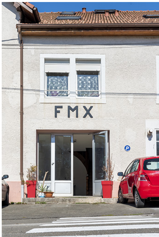
Usine : entrée sur la rue de la Planchette. 25, Montécheroux, 1-3 rue de la Planchette
