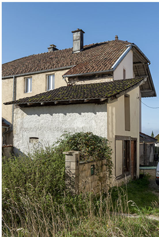
Atelier de fabrication, de trois quarts gauche.
