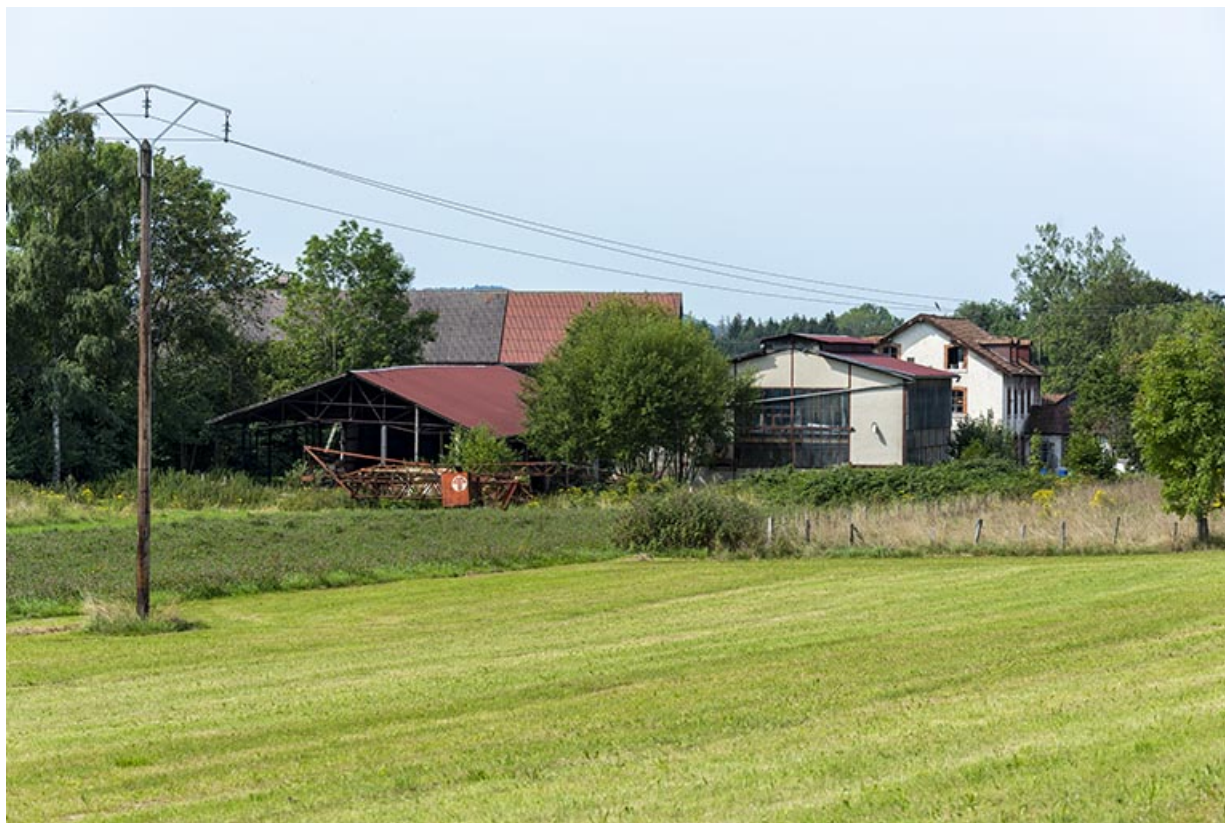
Vue d'ensemble du site, depuis le nord-est.
