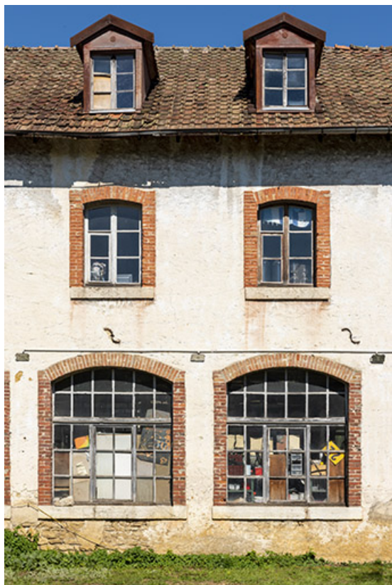
Atelier principal : baies de la façade latérale droite.
