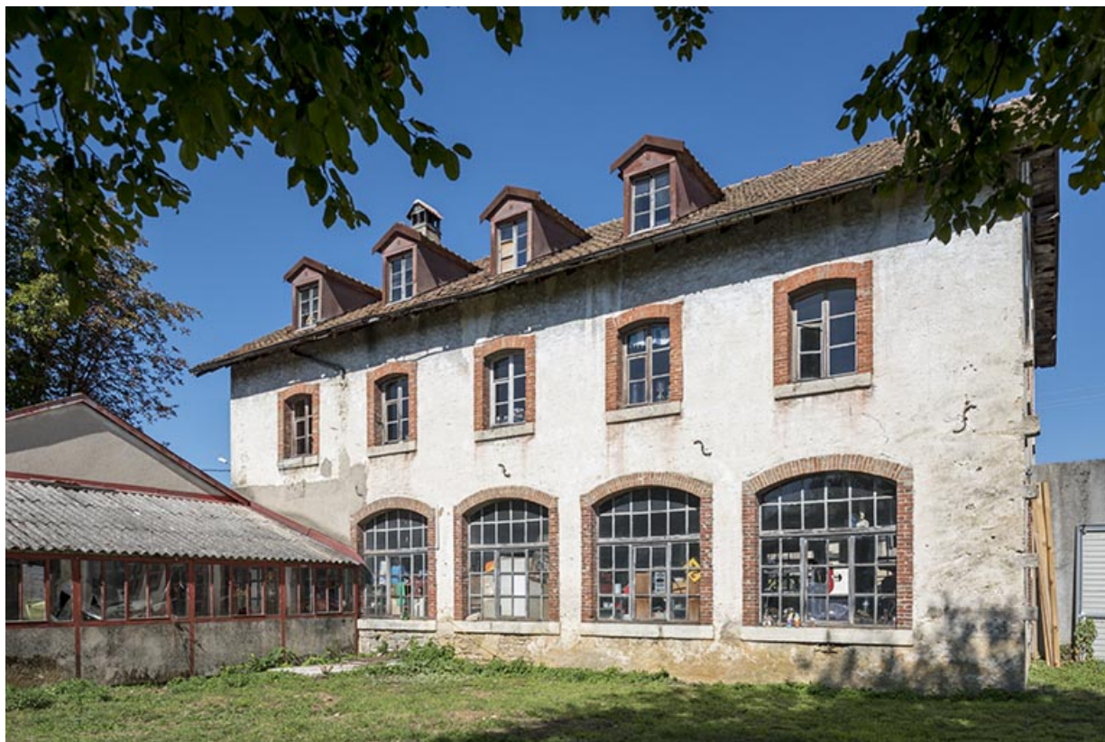
Usine d'outillage Hugoniot-Tissot dite la Fabrique, à Montécheroux. 25, Montécheroux, 31-33 rue de Saint-Hippolyte
