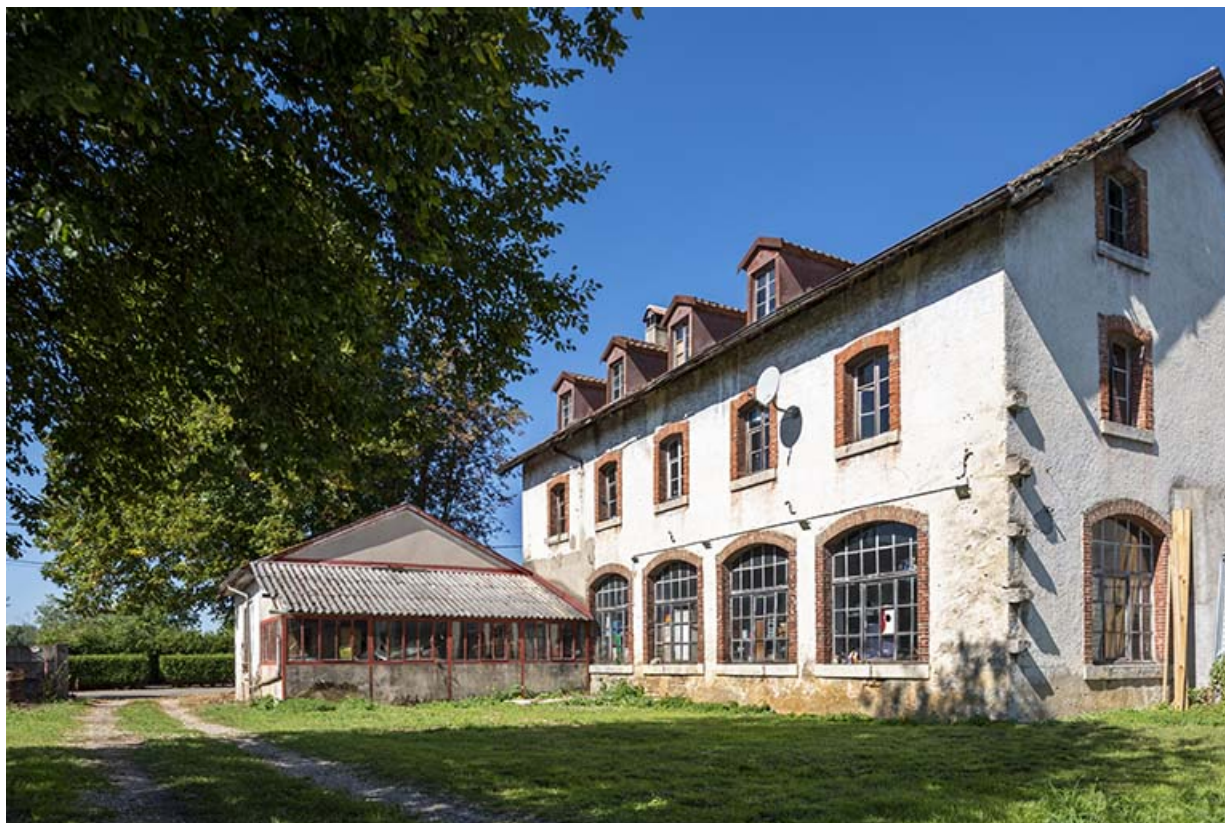
Forge (façade postérieure) et atelier principal (façade latérale droite). 25, Montécheroux, 31-33 rue de Saint-Hippolyte
