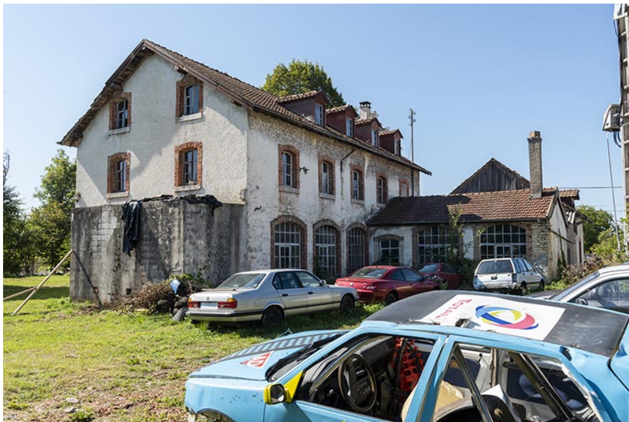
Atelier principal (façade postérieure, de trois quarts droite) et atelier du traitement thermique. 25, Montécheroux, 31-33 rue de Saint-Hippolyte
