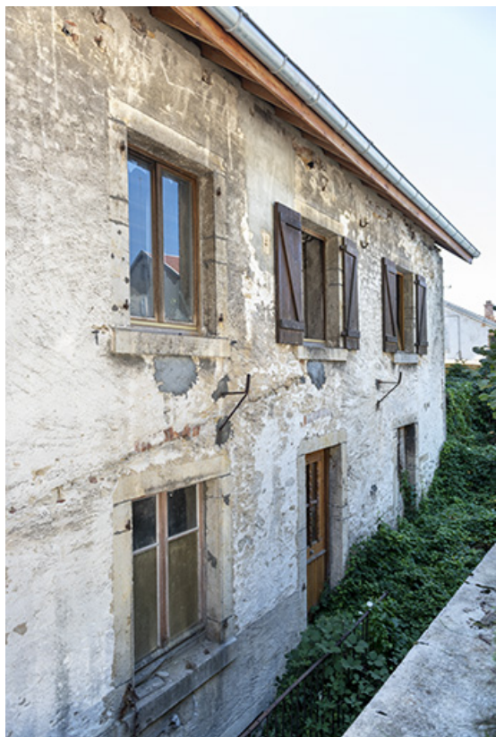
Façade postérieure de la partie gauche (n° 6), vue en enfilade. 25, Montécheroux, 2-6 Grande Rue
