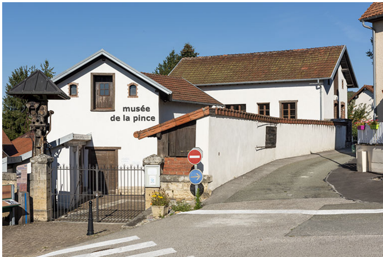
Usine d'outillage (actuel musée de la Pince), 12 rue de la Pommeraie. 25, Montécheroux
