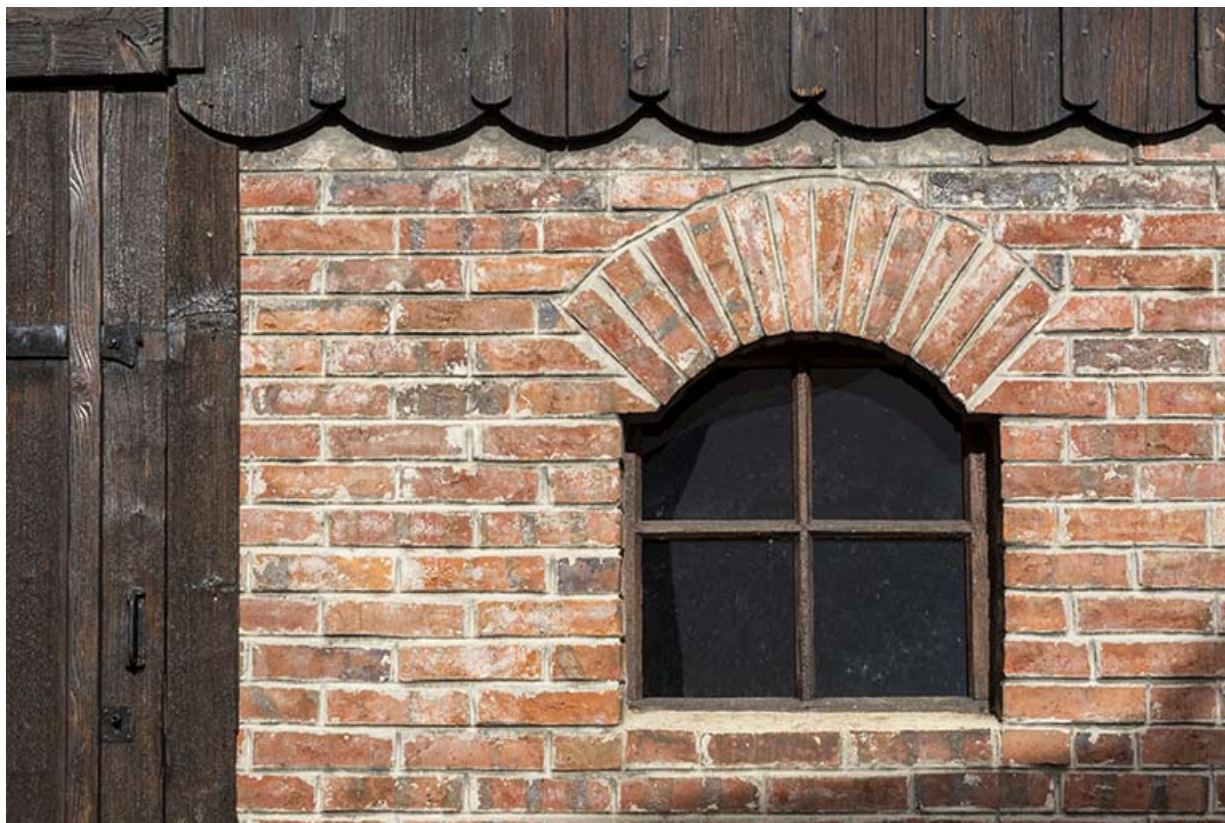
Une fenêtre de la pièce de stockage du combustible.
