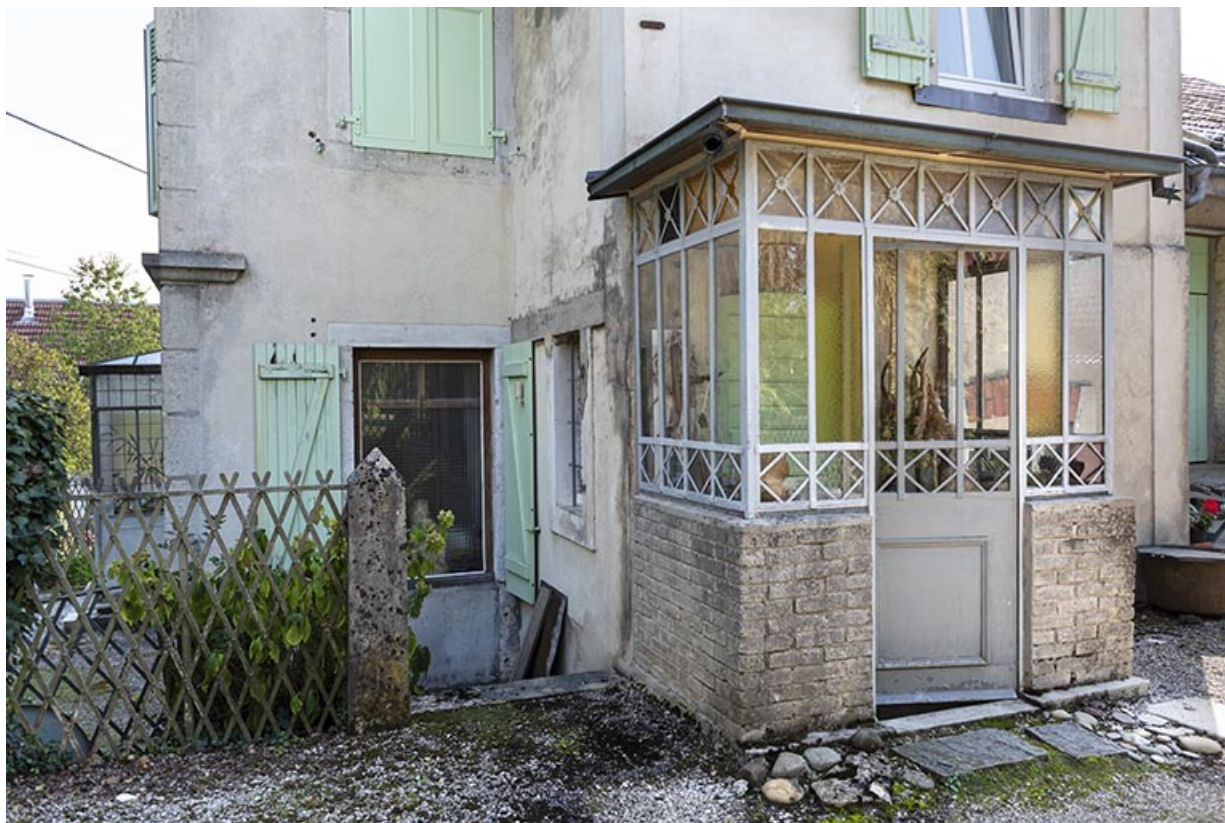
Logement Hugoniot : véranda nord, de trois quarts.
