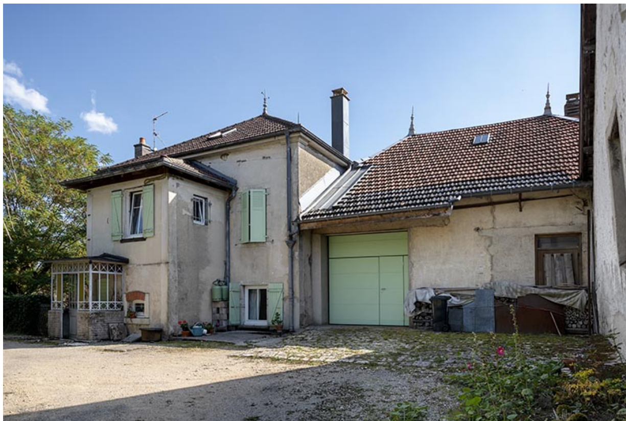
Magasin industriel et logement Hugoniot, depuis le nord-ouest.
