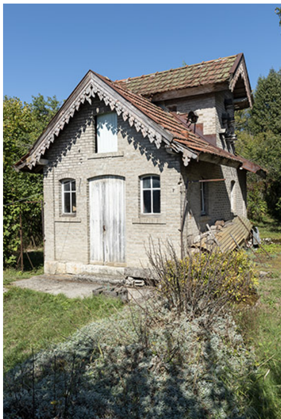
Pigeonnier : façade antérieure, de trois quarts droite.
