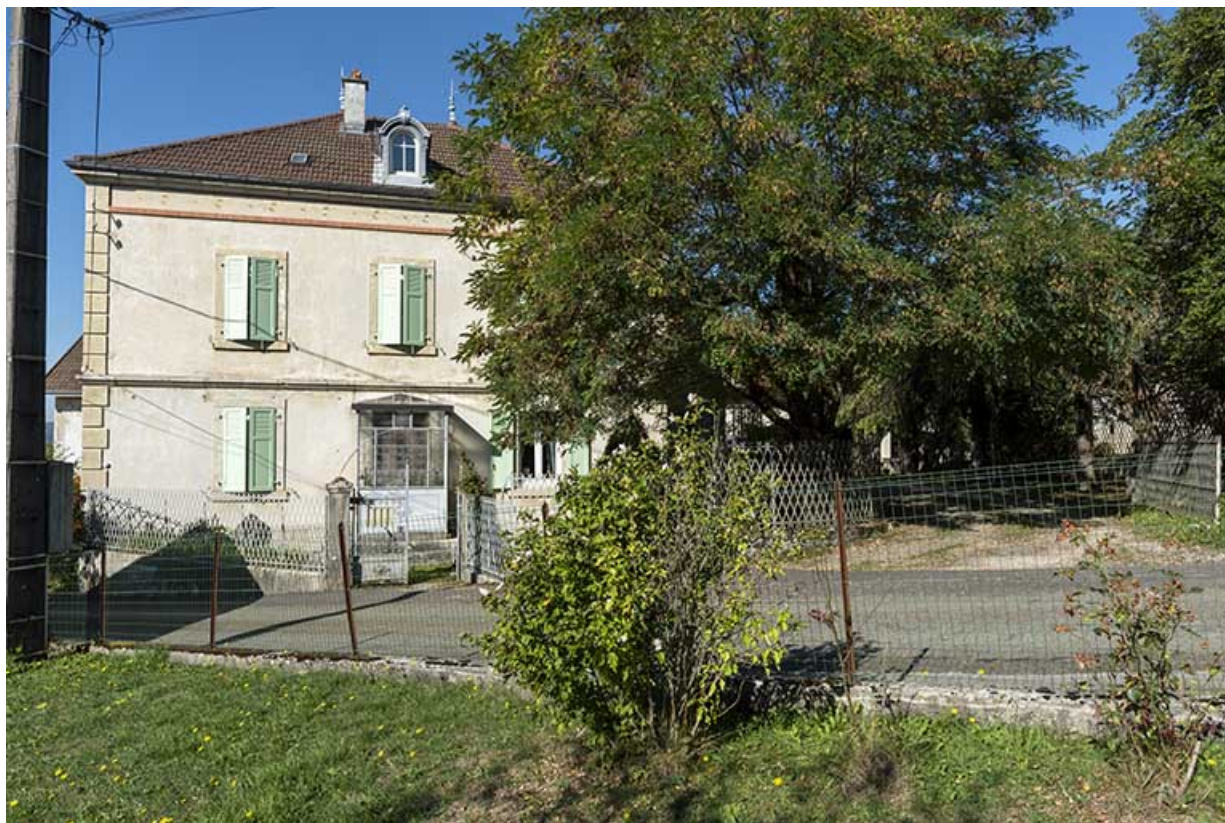
Logement Hugoniot : façade latérale droite. 25, Montécheroux, 5-7 rue du Chêne
