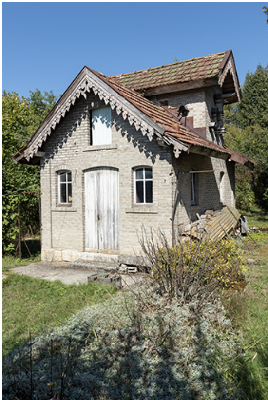
Pigeonnier : façade antérieure, de trois quarts droite.
