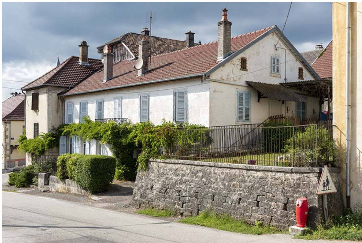
Bâtiment au 8 Grande Rue, de trois quarts droite. 25, Montécheroux, 8-10 Grande Rue
