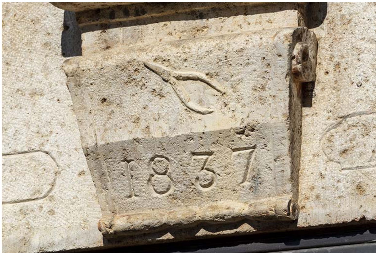
Ancienne ferme (cadastrée 2019 D 700), 9 rue du Lomont : pince gravée et date 1837 (détail). 25, Montécheroux
