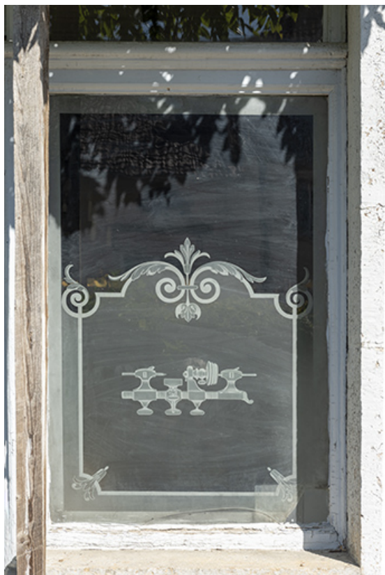
Bâtiment au 8 Grande Rue : fenêtre ornée d'un dessin de tour d'horloger gravé sur le verre. 25, Montécheroux
