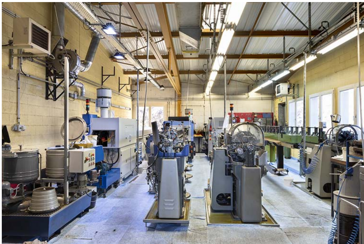
Atelier de fabrication nord : intérieur.
