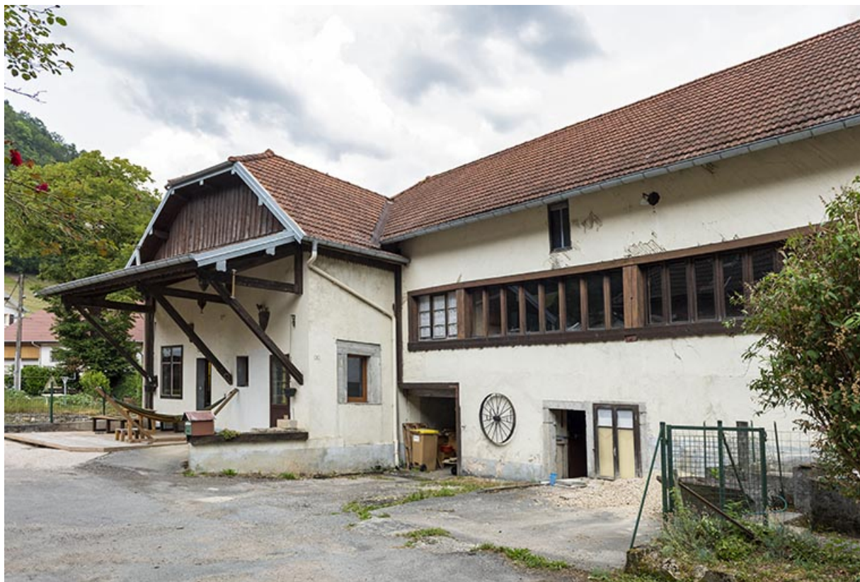
Forge : façade ouest (côté cour).
