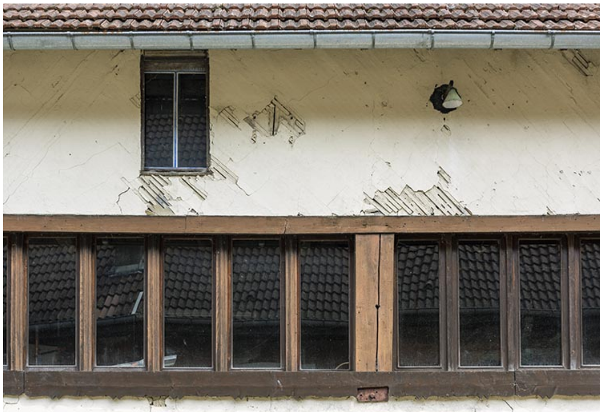
Forge (façade ouest) : fenêtres multiples et lattis de plâtre.
