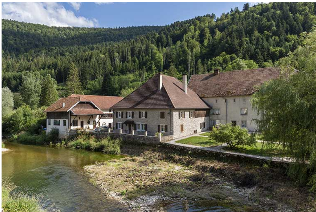
Vue d'ensemble rapprochée, depuis le nord-ouest. De gauche à droite : forge, maison et ferme. 25, Rosureux, 1-3 impasse de la Truite
