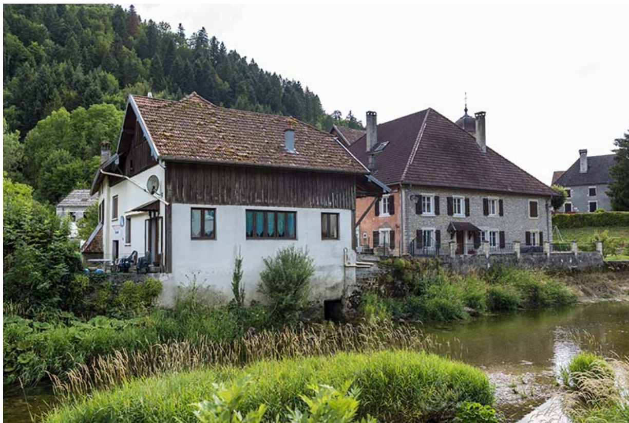
Forge et maison : façade nord (côté Dessoubre). 25, Rosureux, 1-3 impasse de la Truite
