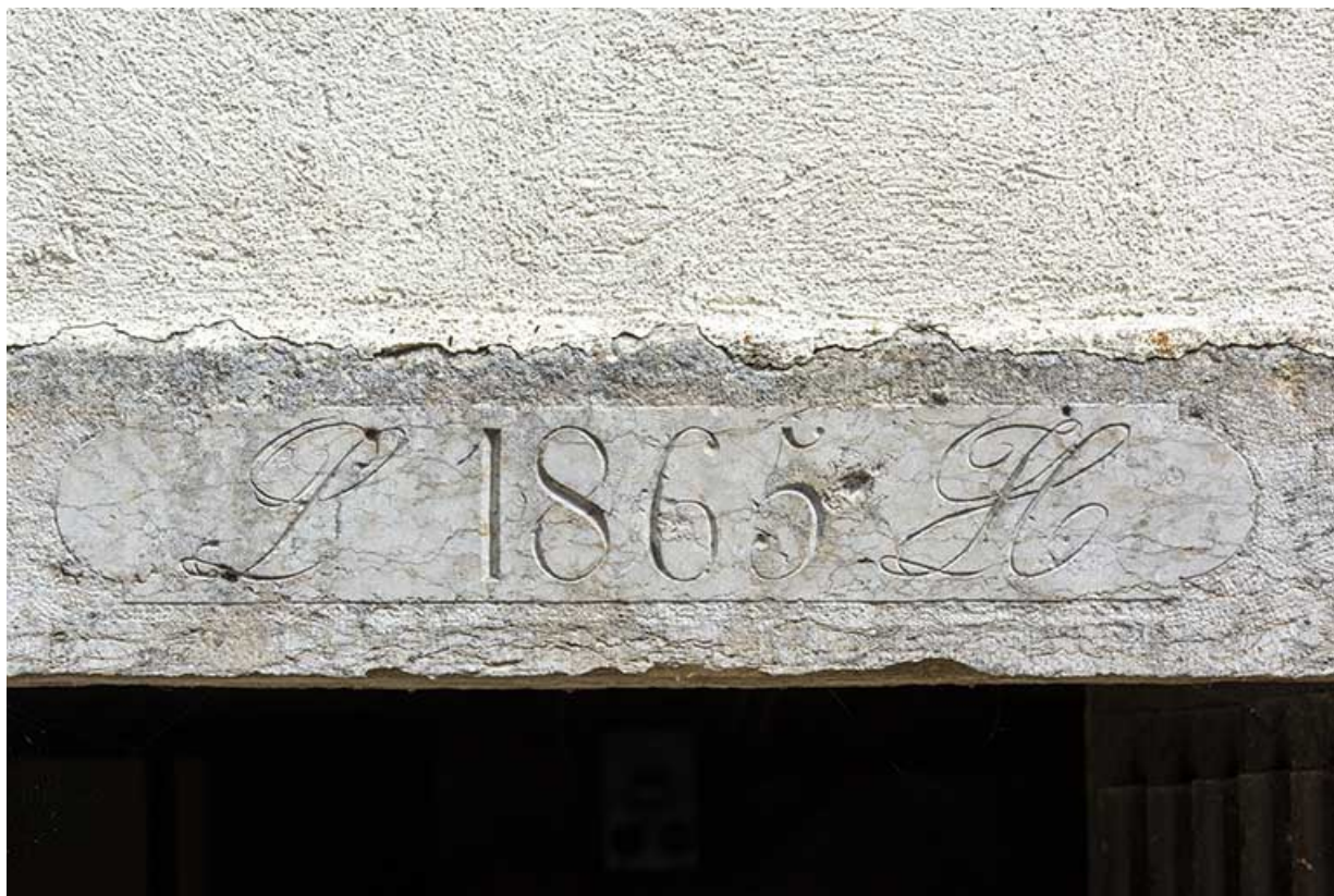
Forge (façade ouest) : linteau daté.
