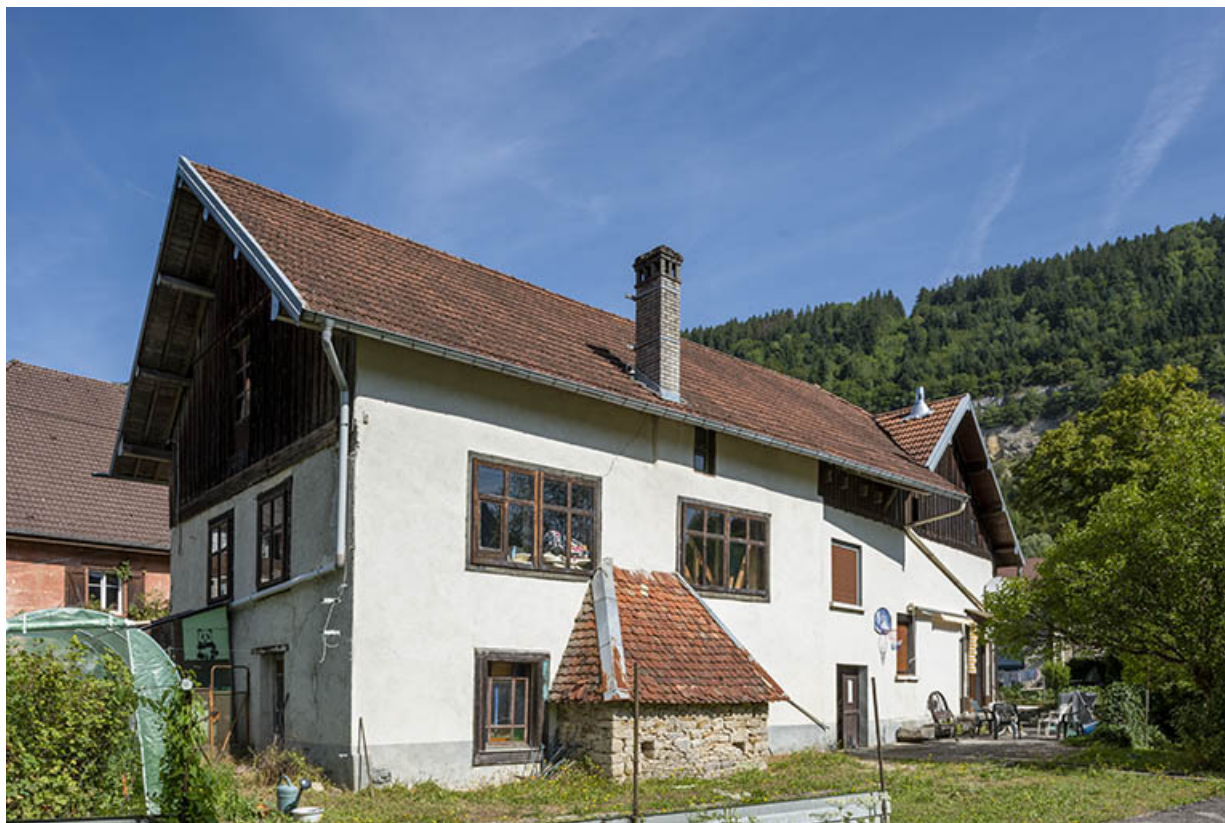
Forge : façades sud et est.
