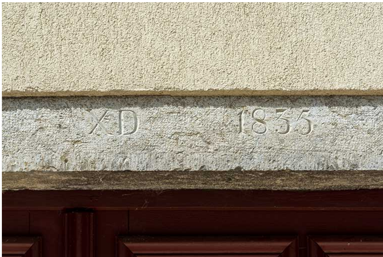
Ferme : linteau daté sur la façade antérieure.
