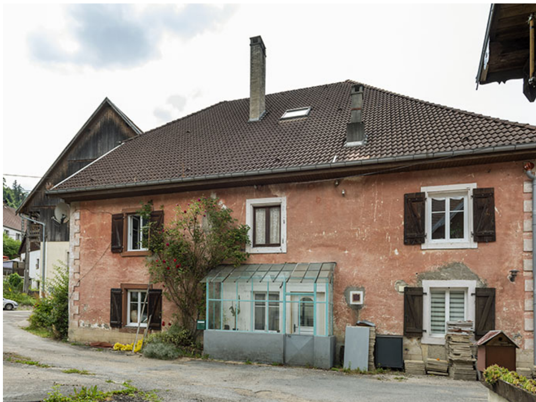
Maison : façade est (côté cour).
