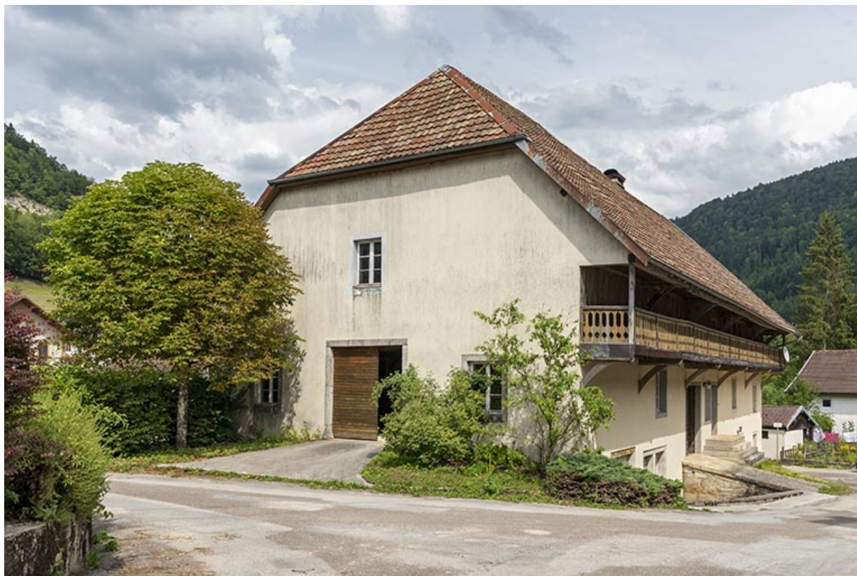
Ferme : façades antérieure et latérale gauche.
